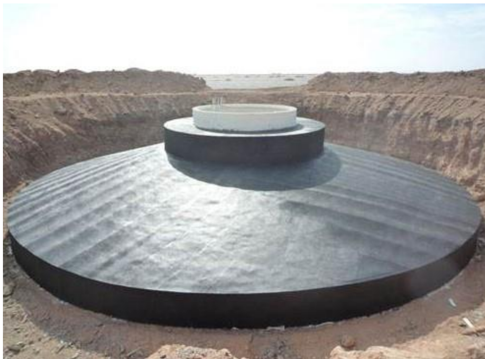
Εικόνα 33: Κυκλικό Πέδιλο Α/Γ
