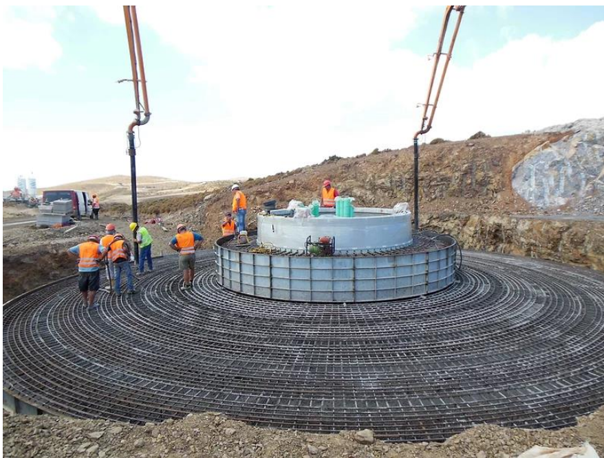
Εικόνα 35: Θεμελίωση σε Βράχο
