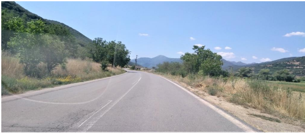
Εικόνα 36. Λήψη από αυτοψία στο χώρο του έργου (22)
