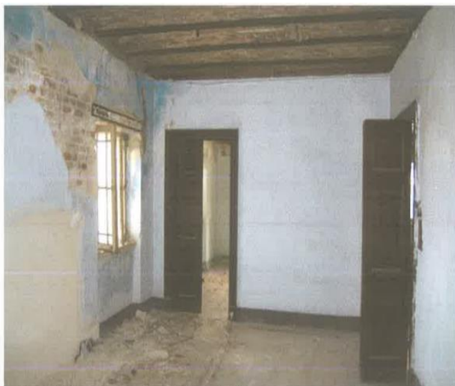
Εικόνα 42. Χώρος υπνοδωματίου στο Β' όροφο (B.04)
