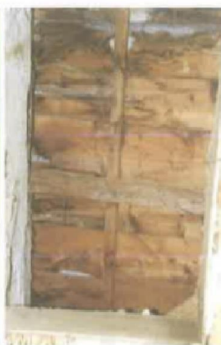
ΙΣ.02 κενό οροφής-φαίνεται καθαρά η κεκλιμένη στέγη
