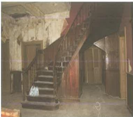
Εικόνα 33. Το κεντρικό κλιμακοστάσιο στο χώρο υποδοχής (I. 01)
