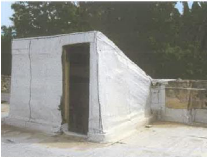
Η απόληξη του κλιμακοστασίου στο δώμα της οικίας
