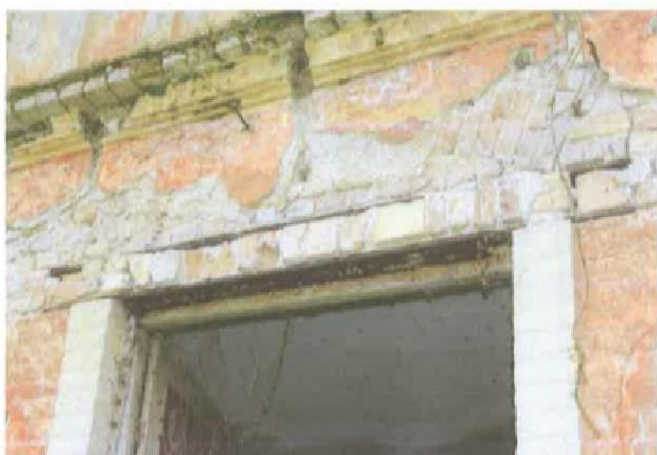
εξωτερικό μεταλλικό πρέκι στην κύρια όψη
