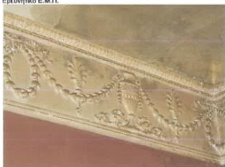
Φωτ. 118. Διακοσμητική περιμετρική ζώνη στο ανώτερο τμήμα της τοιχοποιίας. Διακρίνονται φυτικά μοτίβα και στοιχεία που παραπέμπουν σε κυμάτια αρχαίων ρυθμών Πηγή: Ερευνητικό Ε.Μ.Π.
