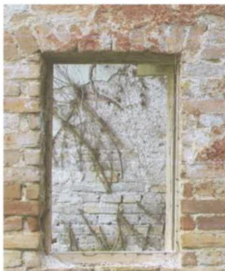
ΙΣ.06 έλλειψη οριζόντιων σενάζ στις ποδιές των παραθύρων
