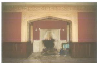
Φωτ. 116. Πηγή: Ερευνητικό Ε.Μ.Π. Διαμόρφωση στο εσωτερικό του χώρου I.10 που τονίζει την κεντρικότητα της εστίας. Το ξύλο δε διασώζεται στην αρχική του θέση.
