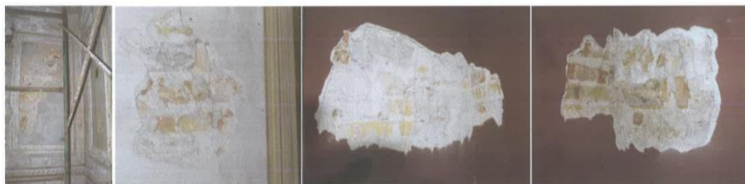
Φωτ. 12. χ. Ι.02 Λιθοδομή Φωτ. 13. χ. Ι.04 μικτή τοιχοποιία Φωτ. 14. χ. Ι.10 συνάντηση δύο κατασκευαστικών φάσεων με διαφορετικά είδη τοιχοποιίας Φωτ. 15. χ. Ι.10 συνάντηση μικτής τοιχοποιίας με οπτοπλινθοδομή α φάσης
