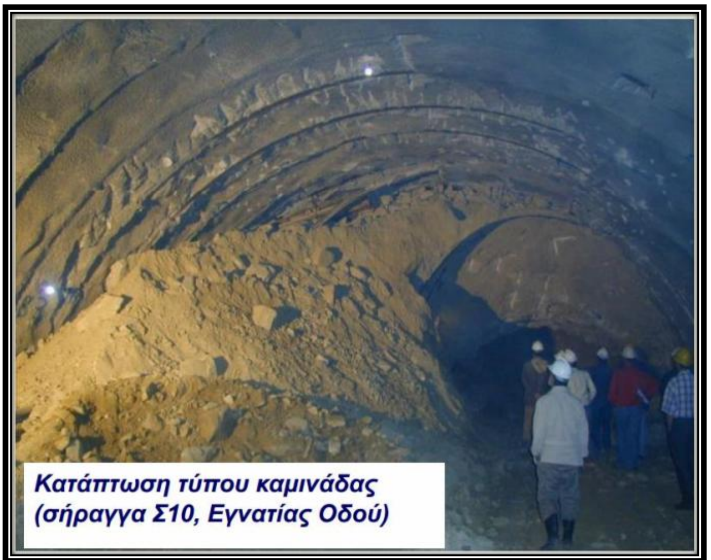
Εικόνα 3 : Κατάπτωση τύπου καμινάδας (Προυντζόπουλος, 2012)
