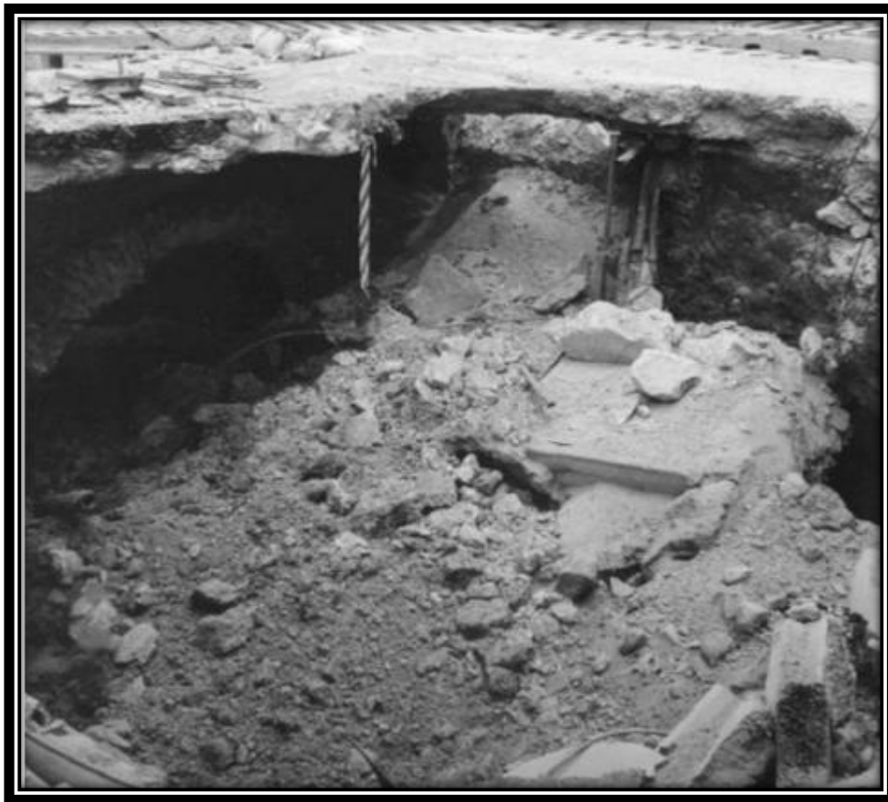
Εικόνα 4 : Αστοχία στην πλατεία Καραϊσκάκη λόγω φαινομένου καμινάδας πάνω από το μέτωπο της σήραγγας του Μετρό Αθηνών (Τσαπέκης, 2019)
