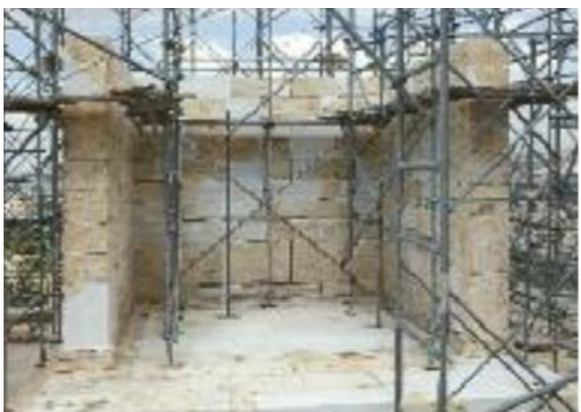
Εικ.87: Ο ναός της Αθηνάς Νίκης κατά και μετά την επανασυναρμολόγηση του. (Φυλλάδιο Αποκαταστάσεις Αρχαίων Μνημείων – Ακρόπολη,17).
