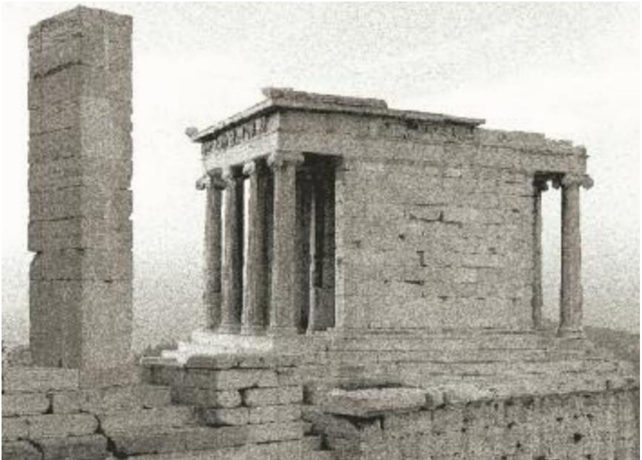
Εικ. 93: Αποψη της βορειοανατολικής πλευράς του ναού πριν την αποσυναρμολόγηση. (Φυλλάδιο Αποκαταστάσεις Αρχαίων Μνημείων – Ακρόπολη, 18).
