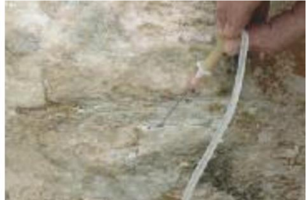
Εικ.23: Διαδικασία συγκόλλησης εσωτερικών ρηγμάτων. Σύστημα σωλήνων σε κίονα του οπισθόναου του Παρθενώνα για τη διοχέτευση ενέματος. (Φυλλάδιο Αποκαταστάσεις Αρχαίων Μνημείων – Ακρόπολη,8).
