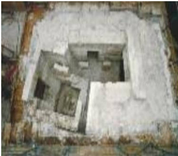
Εικ.89: Τμήμα του αρχαϊκού πόρινου ναΐσκου κάτω από το δάπεδο του ναού της Αθηνάς Νίκης και η νέα μεταλλική εσχάρα του ναού. (Φυλλάδιο Αποκαταστάσεις Αρχαίων Μνημείων – Ακρόπολη,17).
