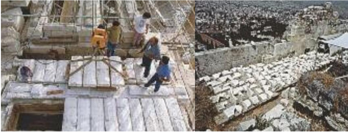
Εικ.55: Αποσυναρμολόγηση φατνωματικών πλακών από την οροφή του κεντρικού κτιρίου Εικ.56: Θραύσματα φατνωματικών πλακών στο δάπεδο εργασίας των Προπυλαίων. (Φυλλάδιο Αποκαταστάσεις Αρχαίων Μνημείων – Ακρόπολη,15).
