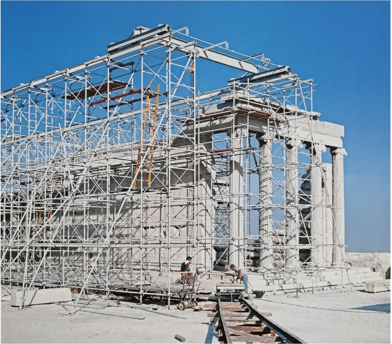
Εικ.51: Η νοτιοανατολική γωνία του μνημείου. Διακρίνονται οι ράγες για τη μεταφορά των Καρνάτιδων, (ΚΙΖΗΣ Γ. ΑΠΟΚΑΤΑΣΤΑΣΗ ΜΝΗΜΕΙΩΝ ΑΝΑΒΙΩΣΗ ΙΣΤΟΡΙΚΩΝ ΚΤΙΡΙΩΝ ΣΤΗΝ ΑΤΤΙΚΗ, α' τόμος,46.)
