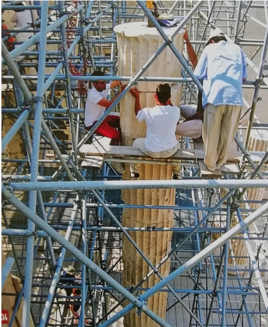
Εικ. 73: Αναποθέτηση του 12 ου σφονδύλου του βορειοανατολικού κίονα της Δυτικής Αίθουσας των Προπυλαίων, από Β.(2005). Φωτ. Κ. Καρανάσος, (ΚΙΖΗΣ Γ. ΑΠΟΚΑΤΑΣΤΑΣΗ ΜΝΗΜΕΙΩΝ ΑΝΑΒΙΩΣΗ ΙΣΤΟΡΙΚΩΝ ΚΤΙΡΙΩΝ ΣΤΗΝ ΑΤΤΙΚΗ, γ'τομος,35.)
