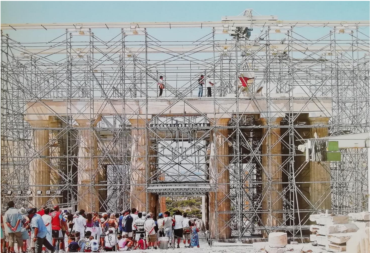
Εικ.65: Η Ανατολική Στοά των Προπυλαίων, κατά την ανατοποθέτηση δοκού της οροφής από Α.(2004) Φωτ. Τ. Τανούλας, (ΚΙΖΗΣ Γ. ΑΠΟΚΑΤΑΣΤΑΣΗ ΜΝΗΜΕΙΩΝ ΑΝΑΒΙΩΣΗ ΙΣΤΟΡΙΚΩΝ ΚΤΙΡΙΩΝ ΣΤΗΝ ΑΤΤΙΚΗ, γ'τομος,31.)
