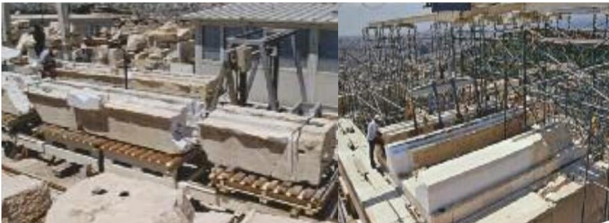
Εικ.57: Συγκόλληση θραυσμάτων δοκού της ανατολικής στοάς των Προπυλαίων Εικ.58: Ανατοποθέτηση δοκού της ανατολικής στοάς των Προπυλαίων. (Φυλλάδιο Αποκαταστάσεις Αρχαίων Μνημείων – Ακρόπολη,15).
