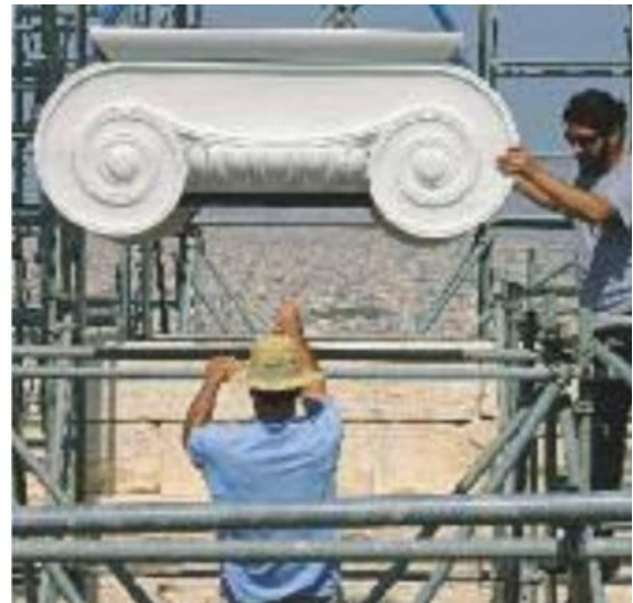
Εικ.59: Αποσυναρμολόγηση ιωνικού κιονόκρανου της κεντρικής αίθουσας και τοποθέτηση των δύο νέων ιωνικών κιονόκρανων στην κεντρική αίθουσα των Προπυλαίων. (Φυλλάδιο Αποκαταστάσεις Αρχαίων Μνημείων – Ακρόπολη,15).
