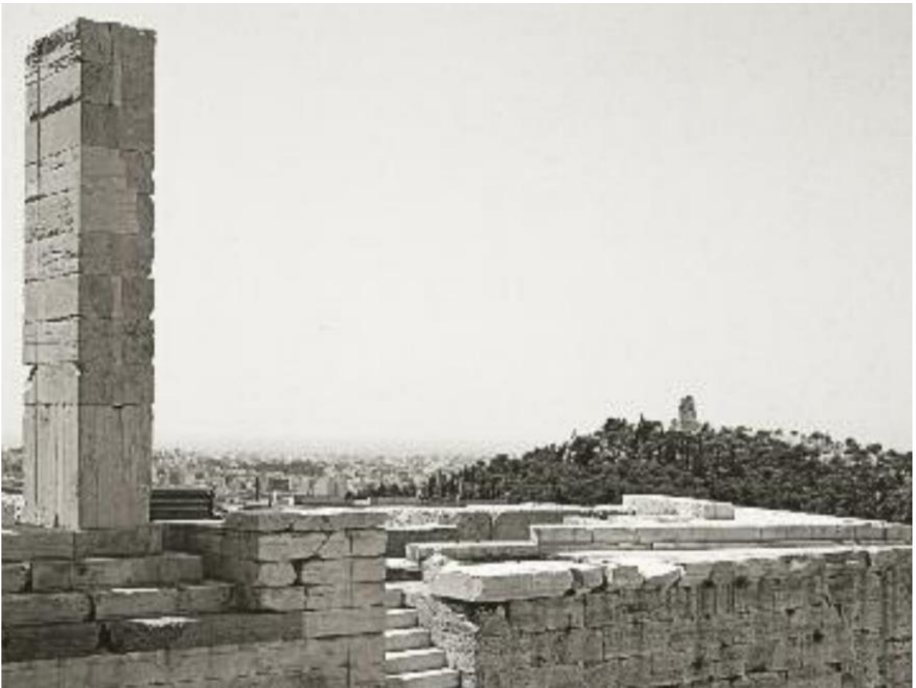
Εικ.94: Ο ναός της Αθηνάς Νίκης μετά την αποσυναρμολόγησή του. (Φυλλάδιο Αποκαταστάσεις Αρχαίων Μνημείων – Ακρόπολη,18).
