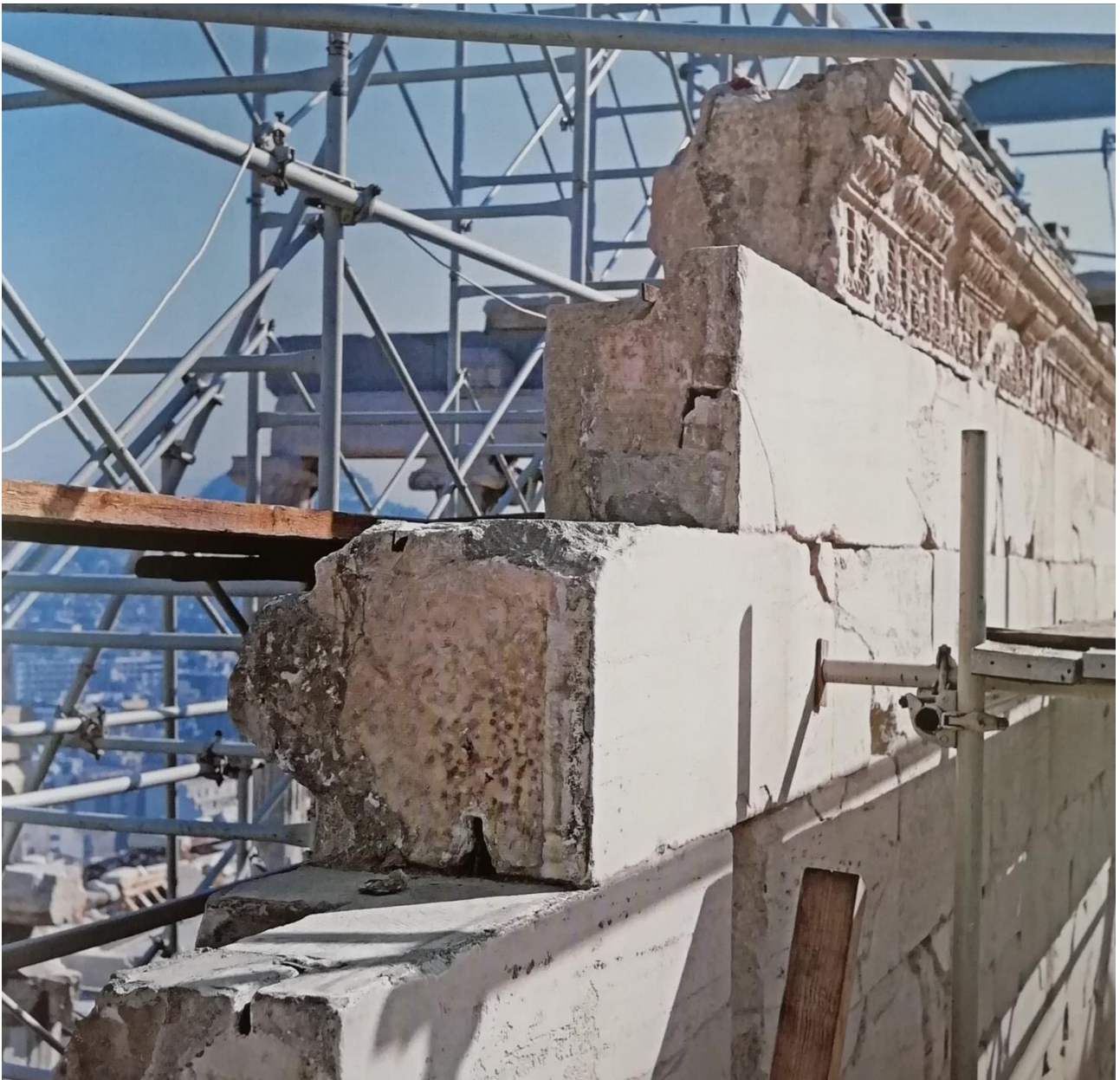
Εικ.50: Λεπτομέρεια της τοιχοποιίας, (ΚΙΖΗΣ Γ. ΑΠΟΚΑΤΑΣΤΑΣΗ ΜΝΗΜΕΙΩΝ ΑΝΑΒΙΩΣΗ ΙΣΤΟΡΙΚΩΝ ΚΤΙΡΙΩΝ ΣΤΗΝ ΑΤΤΙΚΗ, α΄τομος,45.)
