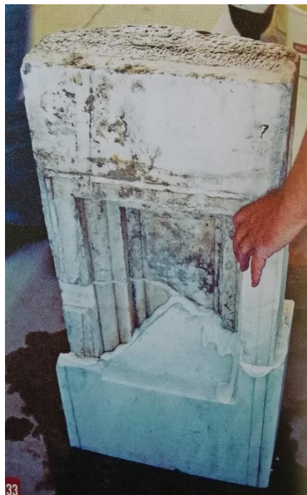
Εικ. 72: Συγκόλληση νέου συμπληρώματος σε φατνωματική πλάκα της Δυτικής Αίθουσας με ένα φάτνωμα. Φωτ.: Β. Πασχαλίδης. (ΚΙΖΗΣ Γ. ΑΠΟΚΑΤΑΣΤΑΣΗ ΜΝΗΜΕΙΩΝ ΑΝΑΒΙΩΣΗ ΙΣΤΟΡΙΚΩΝ ΚΤΙΡΙΩΝ ΣΤΗΝ ΑΤΤΙΚΗ, γ' τομος, 34.)
