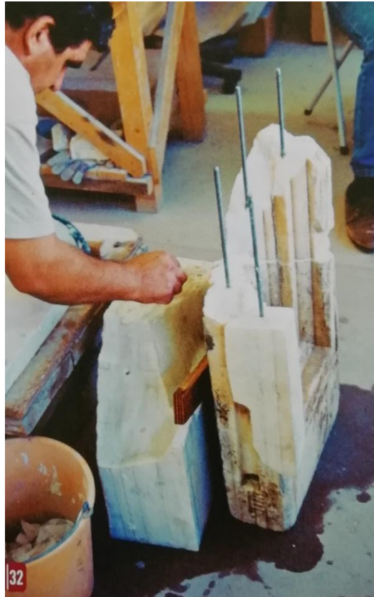
Εικ. 71: Συγκόλληση νέου συμπληρώματος σε φατνωματική πλάκα της Δυτικής Αίθουσας με ένα φάτνωμα. Φωτ.: Β. Πασχαλίδης. (ΚΙΖΗΣ Γ. ΑΠΟΚΑΤΑΣΤΑΣΗ ΜΝΗΜΕΙΩΝ ΑΝΑΒΙΩΣΗ ΙΣΤΟΡΙΚΩΝ ΚΤΙΡΙΩΝ ΣΤΗΝ ΑΤΤΙΚΗ, γ' τομος, 34.)
