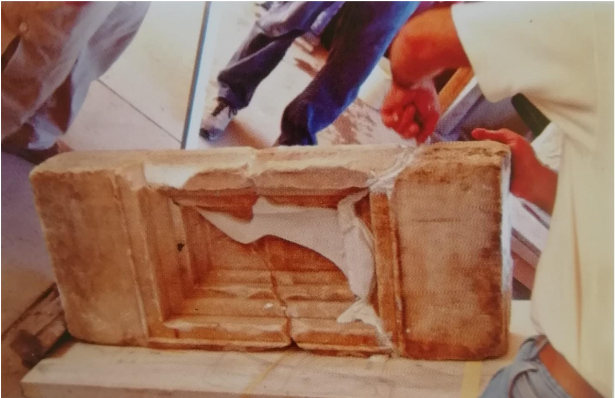
Εικ.62: Συγκόλληση νέου συμπληρώματος σε φατνωματική πλάκα της Δυτικής Αίθουσας με ένα φάτνωμα. Φωτ. Τ. Τανούλας, (ΚΙΖΗΣ Γ. ΑΠΟΚΑΤΑΣΤΑΣΗ ΜΝΗΜΕΙΩΝ ΑΝΑΒΙΩΣΗ ΙΣΤΟΡΙΚΩΝ ΚΤΙΡΙΩΝ ΣΤΗΝ ΑΤΤΙΚΗ, γ' τόμος, 26.)
