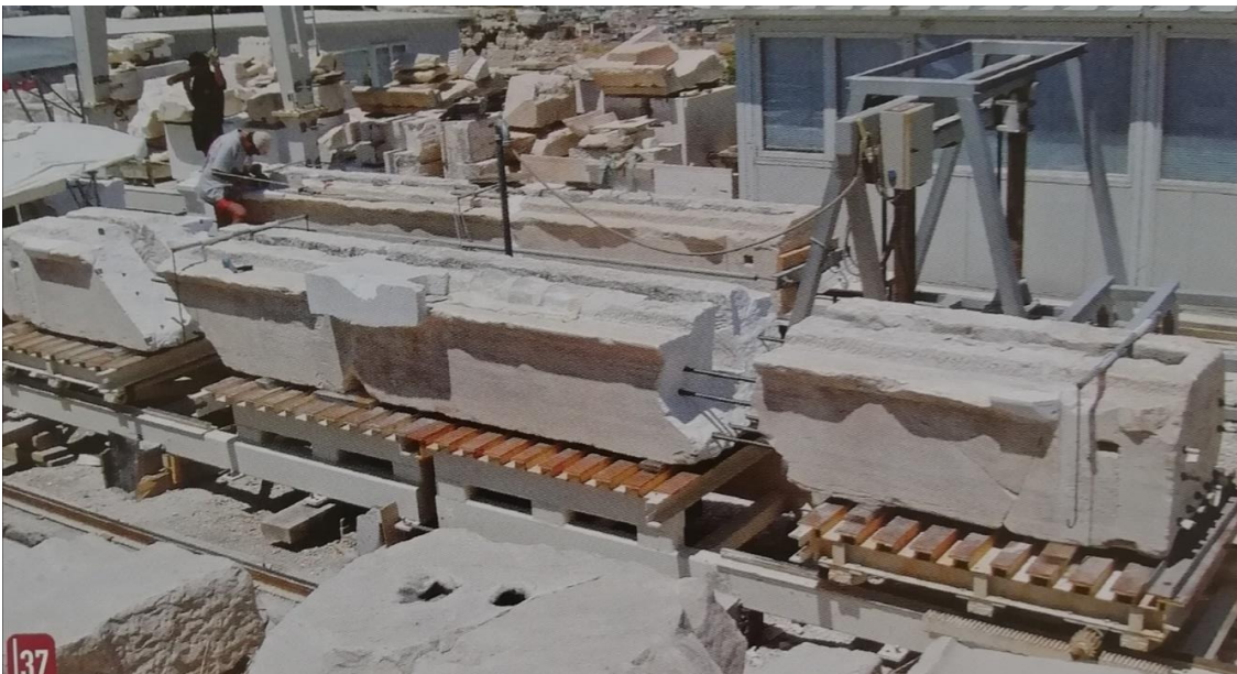
Εικ. 76: Συγκόλληση θραυσμάτων δοκού της Ανατολικής Στοάς των Προπυλαίων στην ειδική τράπεζα συγκολλήσεων. Μελέτη: Μ. Ιωαννίδου, Β. Πασχαλίδης. Φωτ. Τ. Τανούλας, (ΚΙΖΗΣ Γ. ΑΠΟΚΑΤΑΣΤΑΣΗ ΜΝΗΜΕΙΩΝ ΑΝΑΒΙΩΣΗ ΙΣΤΟΡΙΚΩΝ ΚΤΙΡΙΩΝ ΣΤΗΝ ΑΤΤΙΚΗ, γ'τομος,36.)
