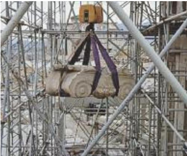
Εικ.59: Αποσυναρμολόγηση ιωνικού κιονόκρανου της κεντρικής αίθουσας και τοποθέτηση των δύο νέων ιωνικών κιονόκρανων στην κεντρική αίθουσα των Προπυλαίων. (Φυλλάδιο Αποκαταστάσεις Αρχαίων Μνημείων – Ακρόπολη,15).
