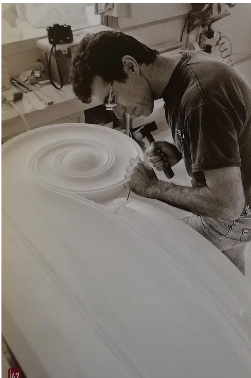
Εικ.82: Λάξευση του αντιγράφου του ιωνικού κιονοκράνου, που κατασκευάστηκε εξ ολοκλήρου από νέο μάρμαρο. Φωτ.: Ε. Πετροπούλου (ΚΙΖΗΣ Γ. ΑΠΟΚΑΤΑΣΤΑΣΗ ΜΝΗΜΕΙΩΝ ΑΝΑΒΙΩΣΗ ΙΣΤΟΡΙΚΩΝ ΚΤΙΡΙΩΝ ΣΤΗΝ ΑΤΤΙΚΗ, γ' τομος,39.)
