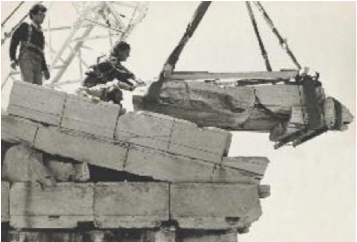
Εικ.20: Αποσυναρμολόγηση της βορειοανατολικής σίμης του Παρθενώνα με την λεοντοκεφαλή ψευδο-υδρορροής. (Φυλλάδιο Αποκαταστάσεις Αρχαίων Μνημείων – Ακρόπολη,8).
