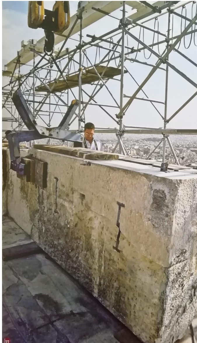
Εικ.66: Αποσυναρμολόγηση λίθου ζωφόρου της Ανατολικής Στοάς με τη χρήση ειδικής αρπαγής. Αποψη από ΝΔ .Μελέτη Σ. Οικονομόπουλος. Φωτ. Μ. Ιωαννίδου. (ΚΙΖΗΣ Γ. ΑΠΟΚΑΤΑΣΤΑΣΗ ΜΝΗΜΕΙΩΝ ΑΝΑΒΙΩΣΗ ΙΣΤΟΡΙΚΩΝ ΚΤΙΡΙΩΝ ΣΤΗΝ ΑΤΤΙΚΗ, γ'τομος,33.)
