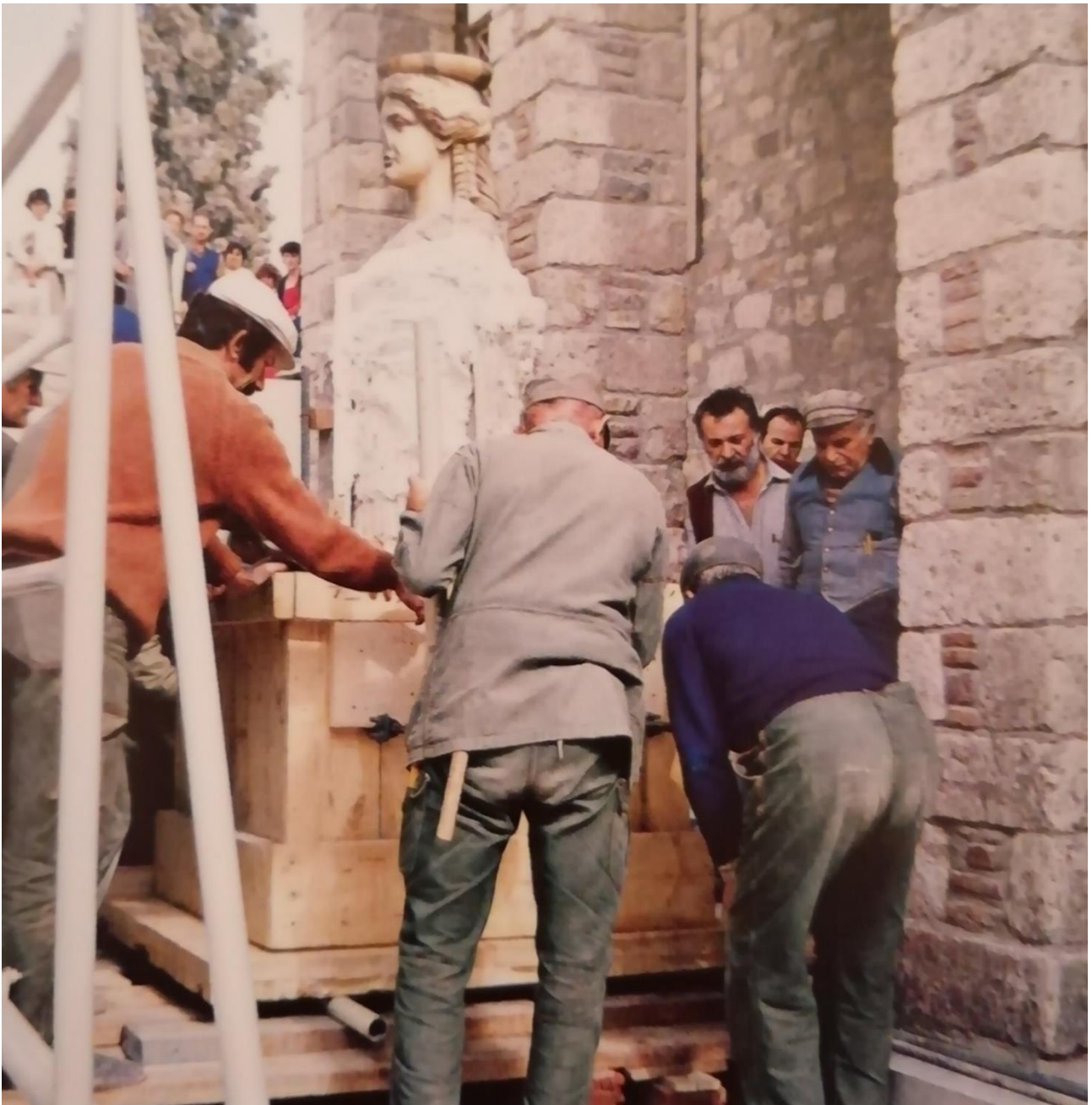
Εικ.32: Μια Καρύατιδα κατά την μεταφορά της στο Μουσείο. (ΚΙΖΗΣ Γ. ΑΠΟΚΑΤΑΣΤΑΣΗ ΜΝΗΜΕΙΩΝ ΑΝΑΒΙΩΣΗ ΙΣΤΟΡΙΚΩΝ ΚΤΙΡΙΩΝ ΣΤΗΝ ΑΤΤΙΚΗ, α'τομος,33.)
