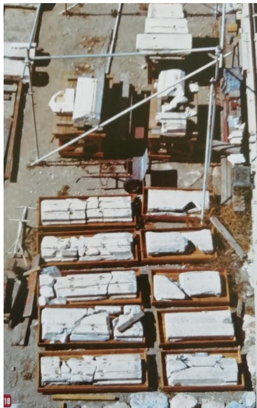
Εικ.61: Ομαδοποίηση των θραυσμάτων των φατνωματικών πλακών, κατά την έρευνα για τις ταυτίσεις. Φωτ. Τ. Τανούλας, (ΚΙΖΗΣ Γ. ΑΠΟΚΑΤΑΣΤΑΣΗ ΜΝΗΜΕΙΩΝ ΑΝΑΒΙΩΣΗ ΙΣΤΟΡΙΚΩΝ ΚΤΙΡΙΩΝ ΣΤΗΝ ΑΤΤΙΚΗ, γ'τομος,26.)
