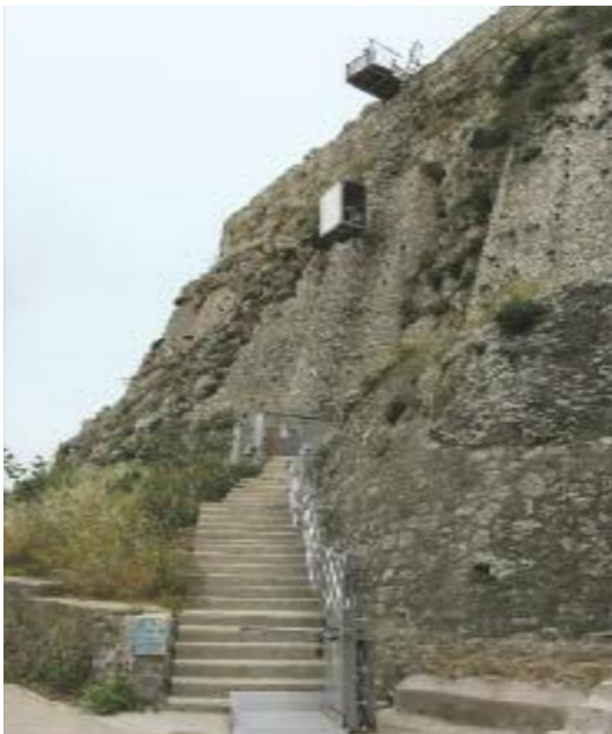
Εικ.102: Ο ανελκυστήρας για τα άτομα με ειδικές ανάγκες στην Ακρόπολη. (Φυλλάδιο Αποκαταστάσεις Αρχαίων Μνημείων – Ακρόπολη,19).
