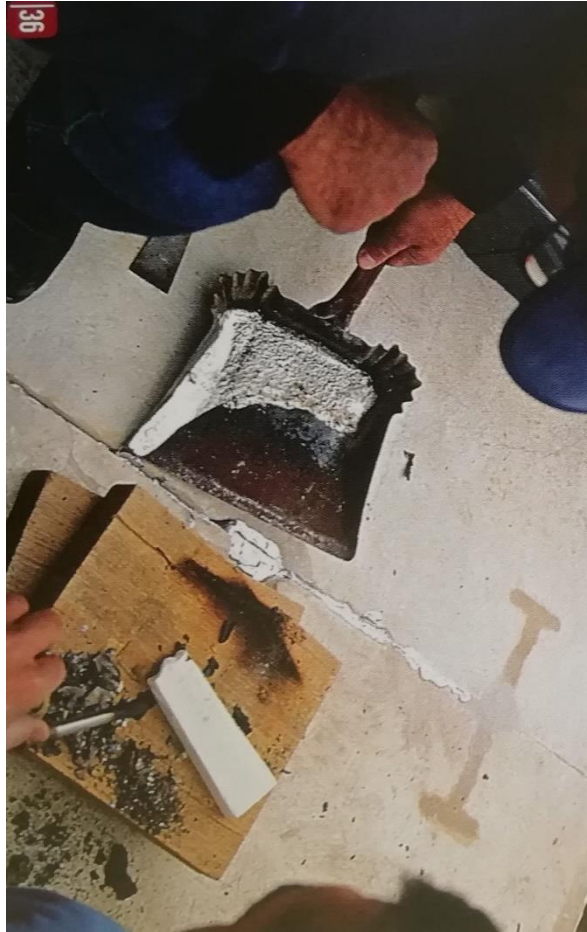
Εικ. 75: Σύνδεσμος τιτανίου τοποθετημένος σε αρχαίο τόρμο και σφραγισμένος με τσιμέντο. Η σφράγιση του αρμού με μολύβι αποτελεί ειδική περίπτωση. Άποψη από ΝΑ. Φωτ. Τ. Τανούλας, (ΚΙΖΗΣ Γ. ΑΠΟΚΑΤΑΣΤΑΣΗ ΜΝΗΜΕΙΩΝ ΑΝΑΒΙΩΣΗ ΙΣΤΟΡΙΚΩΝ ΚΤΙΡΙΩΝ ΣΤΗΝ ΑΤΤΙΚΗ, γ'τομος,35.)
