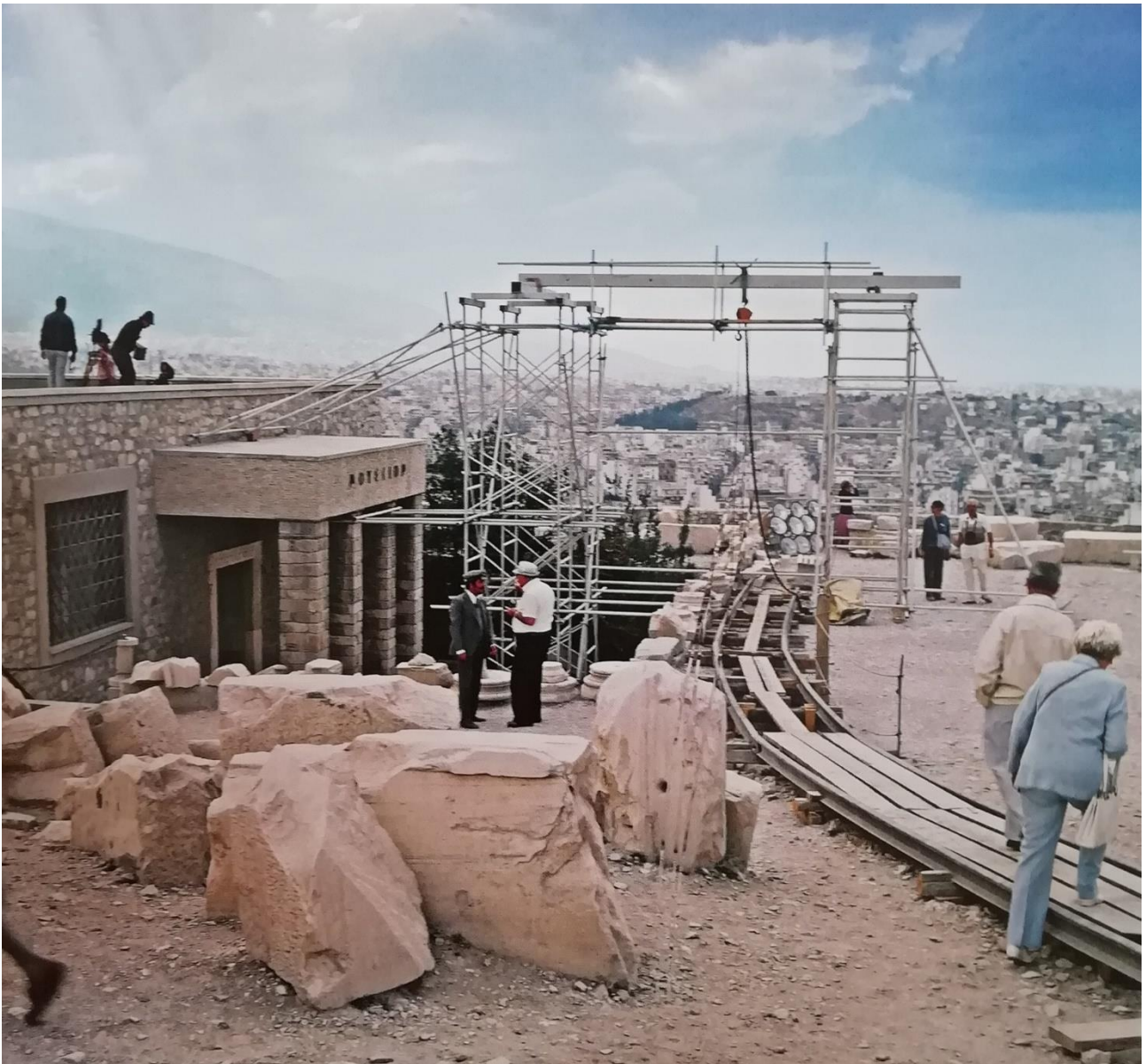
Εικ.52: Η εργοταξιακή υποδομή για τη μεταφορά των Καρυάτιδων στο Μουσείο της Ακρόπολης, (ΚΙΖΗΣ Γ. ΑΠΟΚΑΤΑΣΤΑΣΗ ΜΝΗΜΕΙΩΝ ΑΝΑΒΙΩΣΗ ΙΣΤΟΡΙΚΩΝ ΚΤΙΡΙΩΝ ΣΤΗΝ ΑΤΤΙΚΗ, α'τομος,47.)
