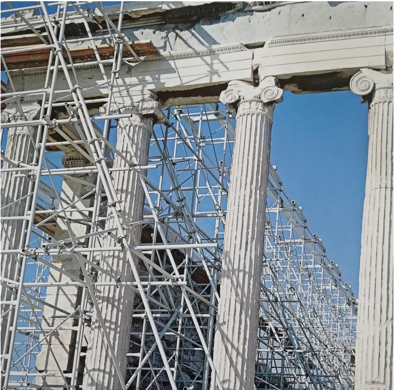
Εικ.53: Η ανατολική κιονοστοιχία κατά την διάρκεια του έργου, (ΚΙΖΗΣ Γ. ΑΠΟΚΑΤΑΣΤΑΣΗ ΜΝΗΜΕΙΩΝ ΑΝΑΒΙΩΣΗ ΙΣΤΟΡΙΚΩΝ ΚΤΙΡΙΩΝ ΣΤΗΝ ΑΤΤΙΚΗ, α΄τομος,48.)
