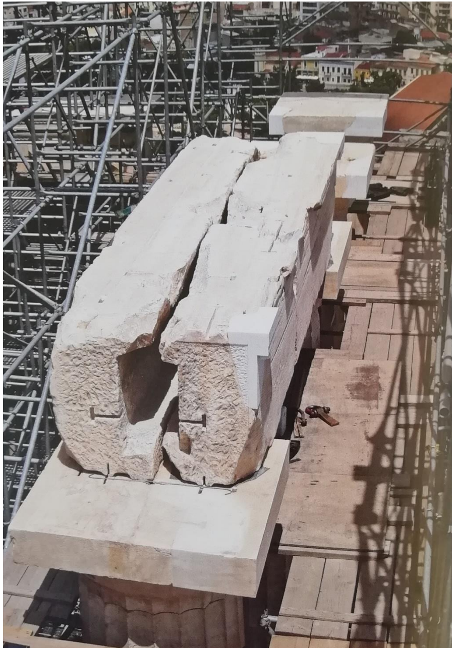
Εικ. 79: Το κεντρικό επιστόλιο της Ανατολικής Στοάς των Προπυλαίων μετά την ανατοποθέτηση του στο μνημείο. Αποψη από ΝΑ. Μελέτη – Φωτ. Β. Πασχαλίδης, (ΚΙΖΗΣ Γ. ΑΠΟΚΑΤΑΣΤΑΣΗ ΜΝΗΜΕΙΩΝ ΑΝΑΒΙΩΣΗ ΙΣΤΟΡΙΚΩΝ ΚΤΙΡΙΩΝ ΣΤΗΝ ΑΤΤΙΚΗ, γ'τομος,38.)
