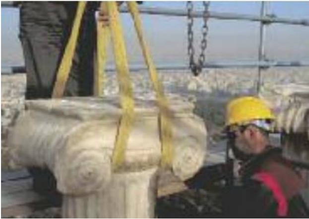
Εικ.88: Αποσυναρμολόγηση του κινοκράνου και μετακίνηση του μονολιθικού κορμού ενός κίονα του ναού της Αθηνάς Νίκης. (Φυλλάδιο Αποκαταστάσεις Αρχαίων Μνημείων – Ακρόπολη,17).
