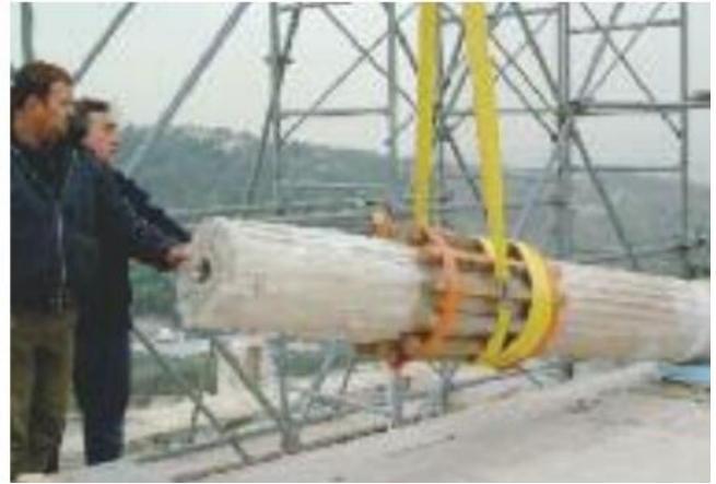
Εικ.88: Αποσυναρμολόγηση του κινοκράνου και μετακίνηση του μονολιθικού κορμού ενός κίονα του ναού της Αθηνάς Νίκης. (Φυλλάδιο Αποκαταστάσεις Αρχαίων Μνημείων – Ακρόπολη,17).
