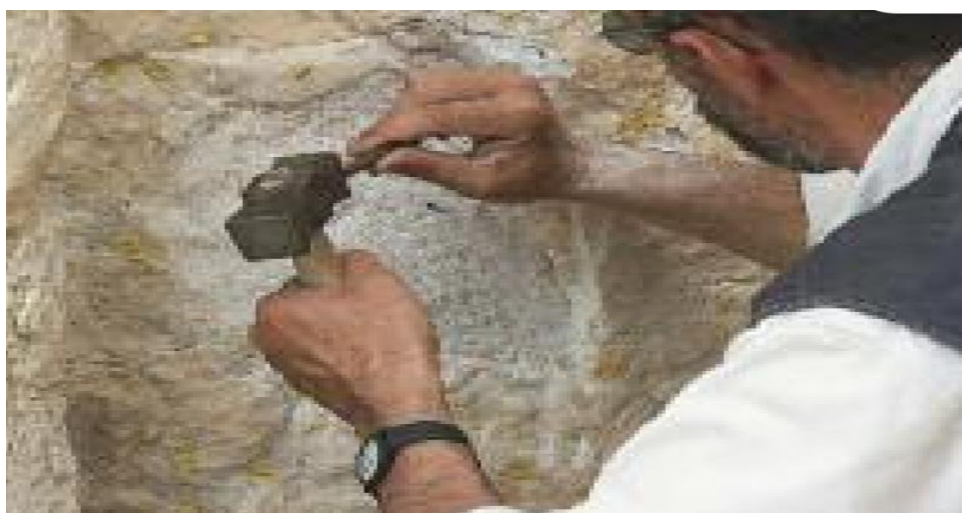
Εικ.25: Μηχανικός καθαρισμός της επιφάνειας του μαρμάρου. (Φυλλάδιο Αποκαταστάσεις Αρχαίων Μνημείων – Ακρόπολη,8).
