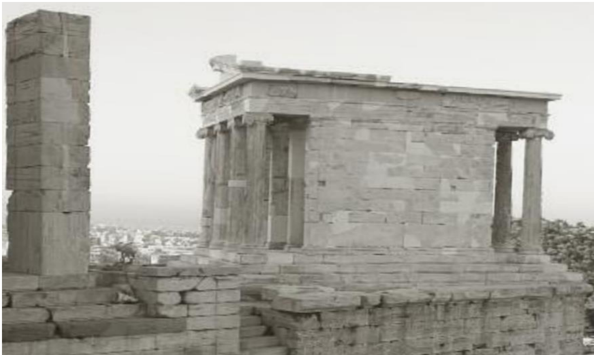
Εικ.95: Ο ναός μετά την επανασυναρμολόγησή του. (Φυλλάδιο Αποκαταστάσεις Αρχαίων Μνημείων – Ακρόπολη,18).
