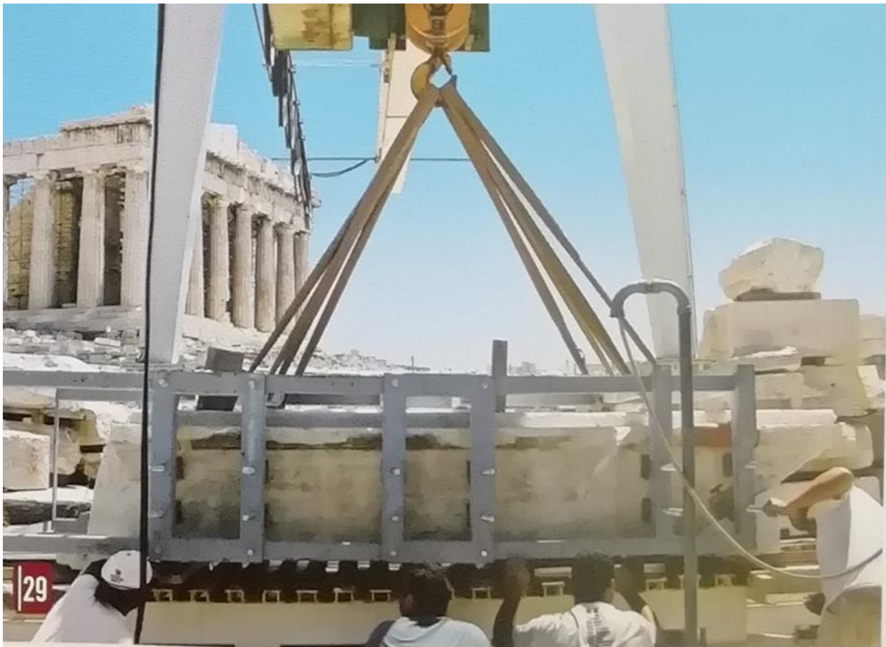
Εικ.68: Ειδικά κατασκευασμένος νάρθηκας για την ασφαλή μετακίνηση αρχιτεκτονικών μελών, Μελέτη: Β. Πασχαλίδης – Σ. Οικονομόπουλος. Φωτ. Τ. Τανούλας, (ΚΙΖΗΣ Γ. ΑΠΟΚΑΤΑΣΤΑΣΗ ΜΝΗΜΕΙΩΝ ΑΝΑΒΙΩΣΗ ΙΣΤΟΡΙΚΩΝ ΚΤΙΡΙΩΝ ΣΤΗΝ ΑΤΤΙΚΗ, γ'τομος,33.)
