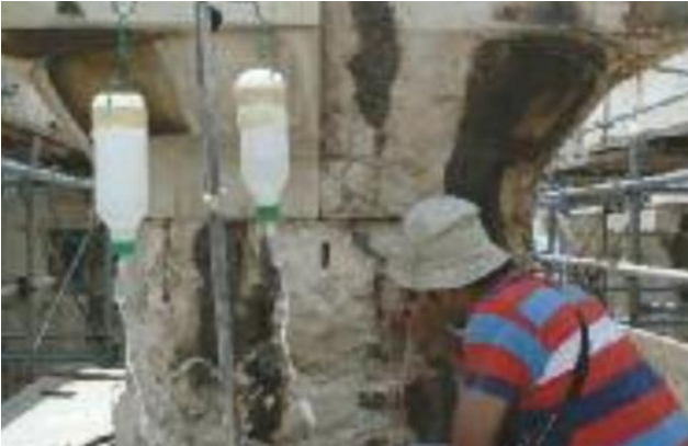
Εικ.23: Διαδικασία συγκόλλησης εσωτερικών ρηγμάτων. Σύστημα σωλήνων σε κίονα του οπισθόναου του Παρθενώνα για τη διοχέτευση ενέματος. (Φυλλάδιο Αποκαταστάσεις Αρχαίων Μνημείων – Ακρόπολη,8).
