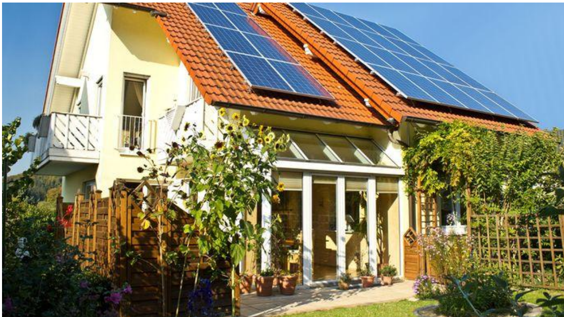
Εικόνα 3-6 Μονοκατοικία με ηλιακούς συλλέκτες στην οροφή.
