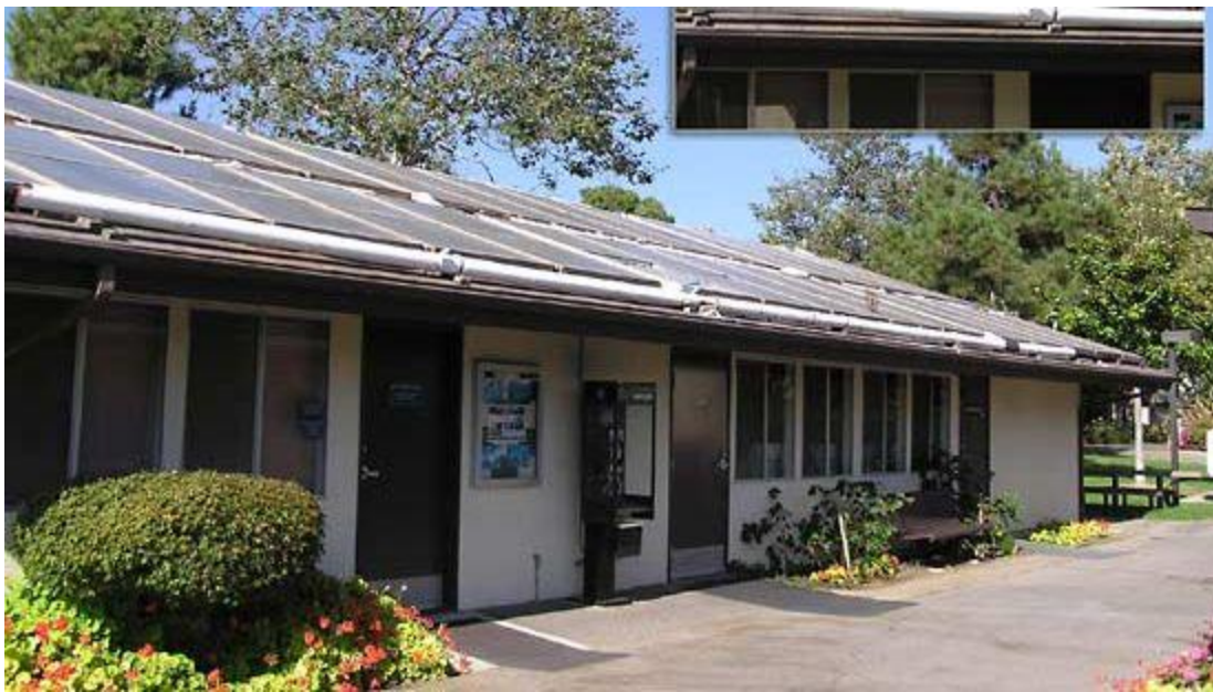
Εικόνα 3-3 Μια στέγη κτιρίου με επίπεδους συλλέκτες που απορροφούν την ηλιακή ενέργεια για τη θέρμανση του αέρα ή του νερού.
