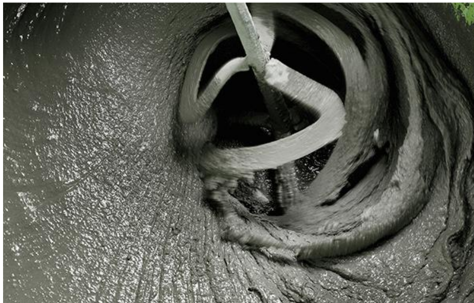
Εικόνα 4.7 Ανάδευση επιχρίσματος(σοβά) με νερό
