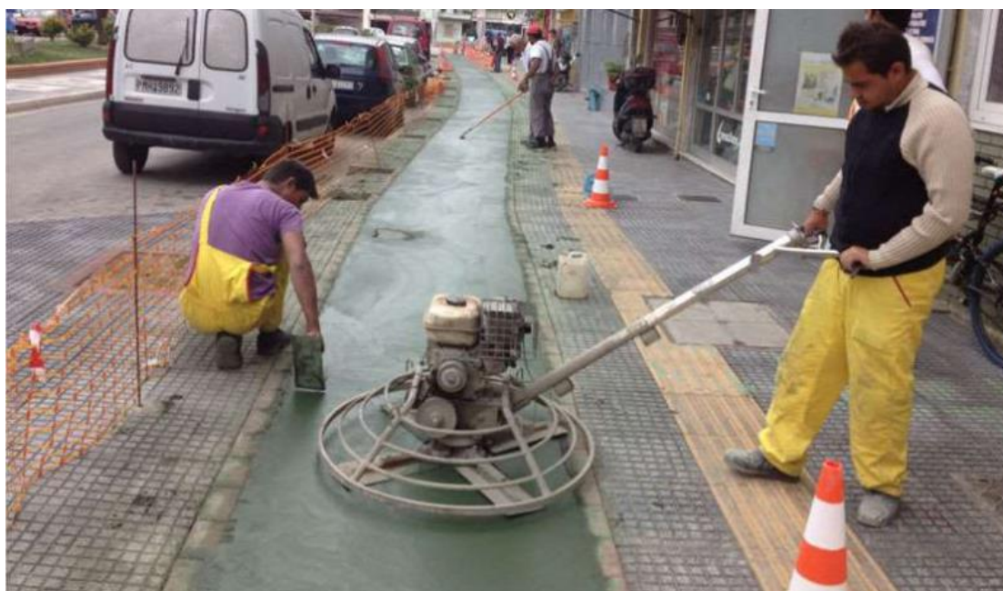
Εικόνα 2.7 Δημιουργία επίπεδης επιφάνειας - Ποδηλατόδρομος Κομοτηνής
