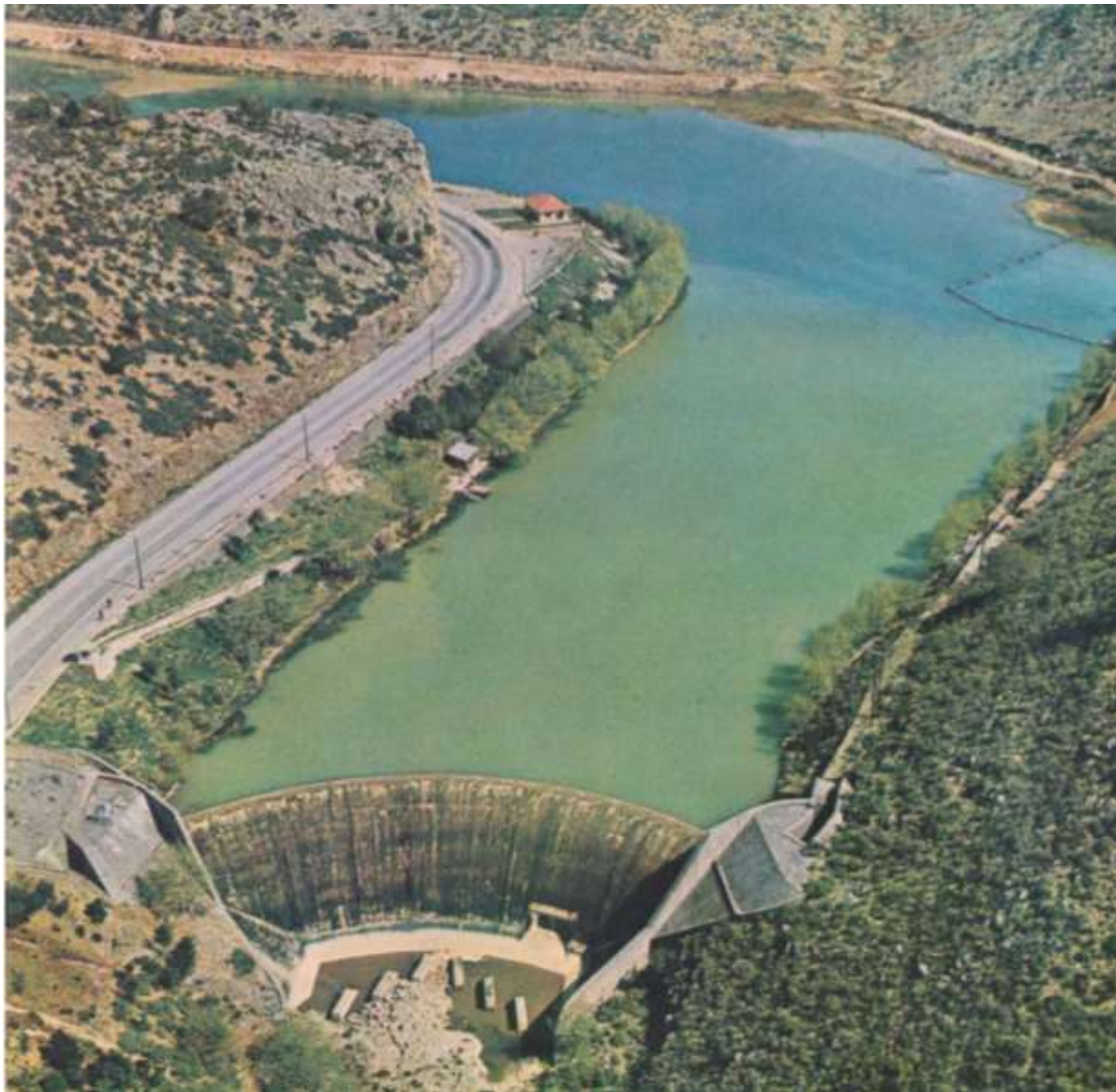
Εικόνα 3.1: Φράγμα Λούρου, Πρέβεζα (πηγή: Ελληνική Επιτροπή Μεγάλων Φραγμάτων)
