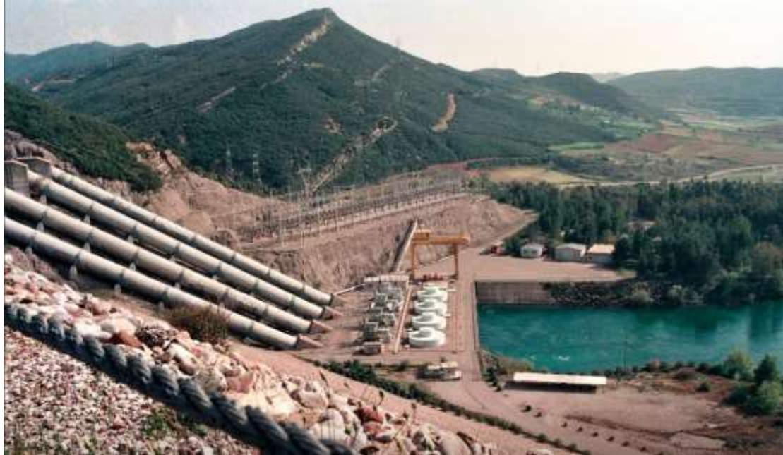
Εικόνα 9.1: Υδροηλεκτρικός Σταθμός Καστρακίου (πηγή: Mapio.net )
