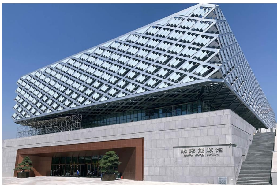
Εικόνα 4.6: Εξωτερική όψη κτηρίου της εταιρίας Future Energy Pavilion στην πόλη Ντατόνγκ της Κίνας. Όλα τα τζαμιά αποτελούν φωτοβολταϊκά CdTe (33).
