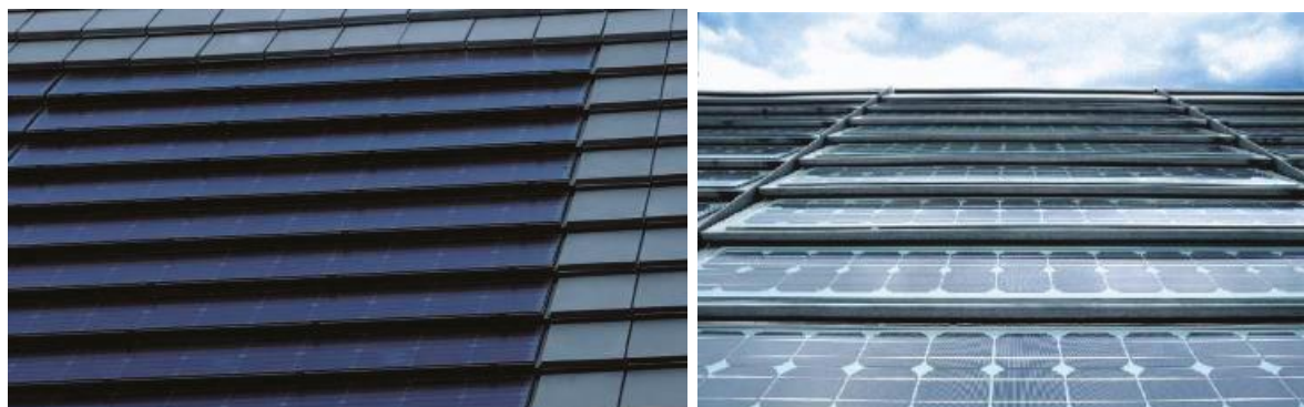
Εικόνα 6.4: Φωτοβολταϊκές μονάδες ενσωματωμένες σε μέρη στέγης (44).
