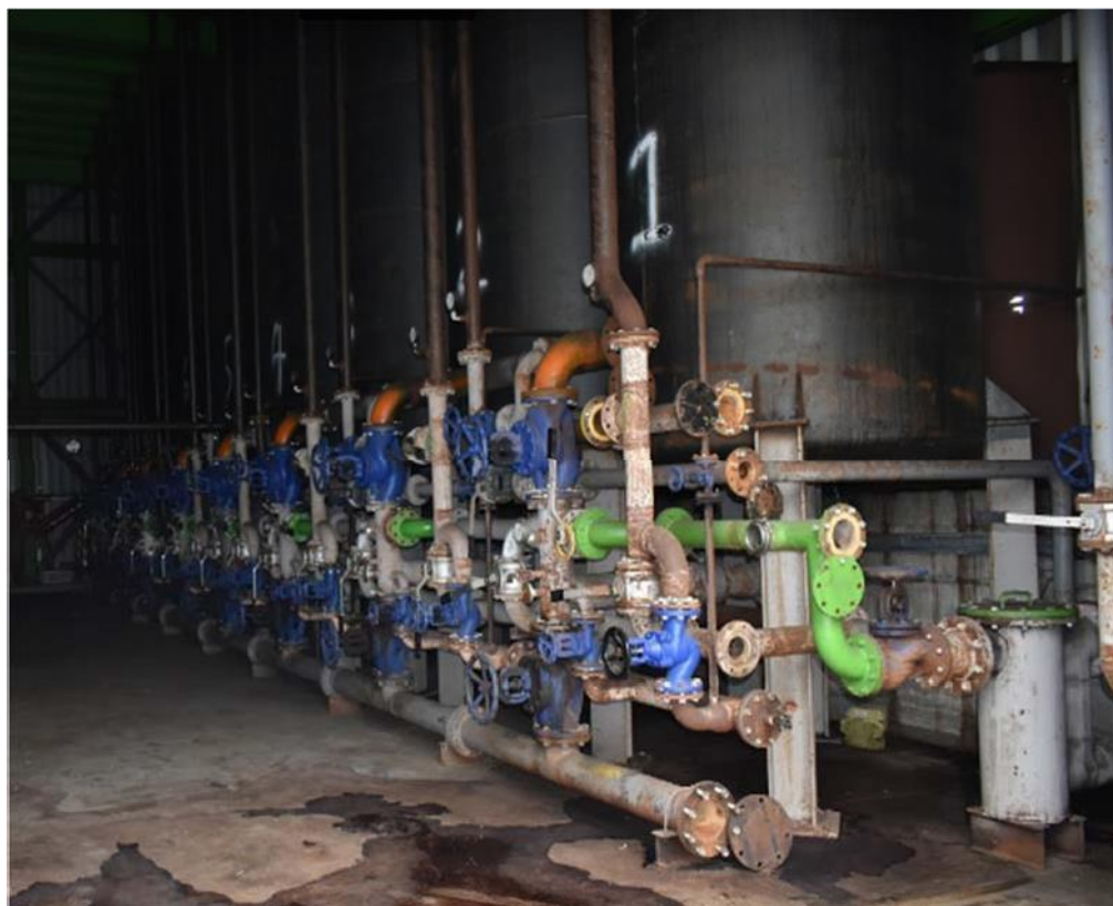
Εικόνα 1.9: Εκχυλιστήρες διατεταγμένοι σε σειρά
