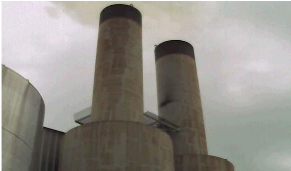
Εικόνα 1.12: Άνω τμήμα κυκλωνιστή
