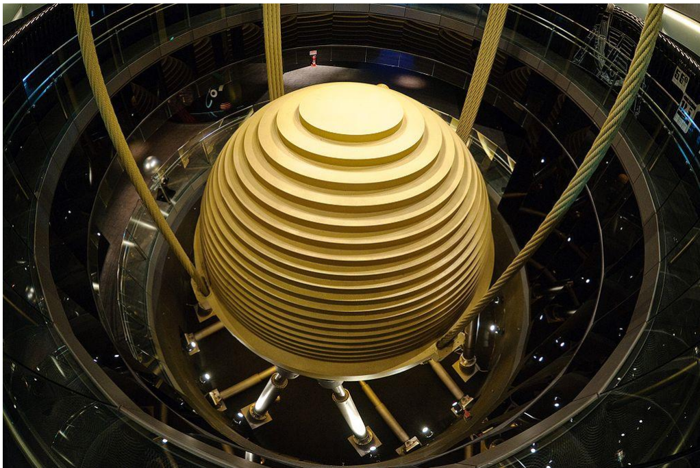
Εικ. 56 Αποσβεστήρας συντονισμένης μάζας, Ταπει 101
