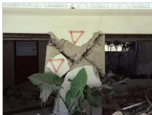
Εικ. 29 Διατμητικές αστοχίες τοιχωμάτων που επιφέρουν μεγάλες παραμορφώσεις
