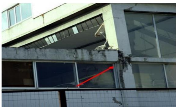
Εικ. 22 a. Εμβολισμός γειτονικών κτιρίων τα οποία δεν φέρουν αντισεισμικό αρμό, b. Εμβολισμός γειτονικών κτιρίων τα οποία δεν φέρουν αντισεισμικό αρμό και υπάρχει διαφορά στάθμης των ορόφων μεταξύ τους. (Βλάβες σε δομικά και μη δομικά στοιχεία από σεισμό)
