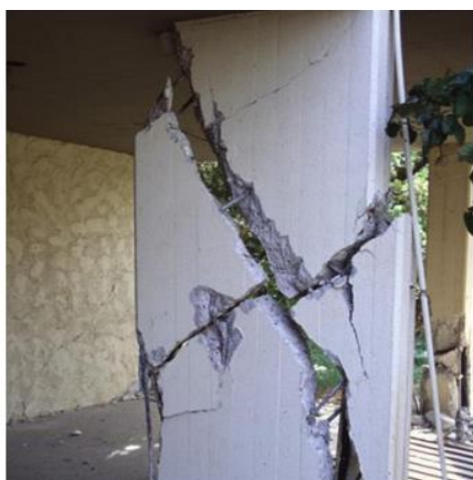
Εικ. 29 Διατμητικές αστοχίες τοιχωμάτων που επιφέρουν μεγάλες παραμορφώσεις
