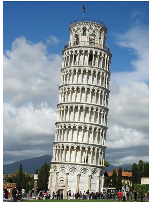
Εικ. 26 Πύργος της Πίζας
