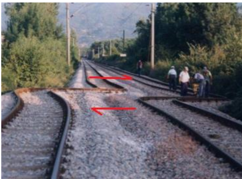
Εικ. 8 Παράδειγμα ρήγματος οριζόντιας ολίσθησης, Τουρκία 1988
