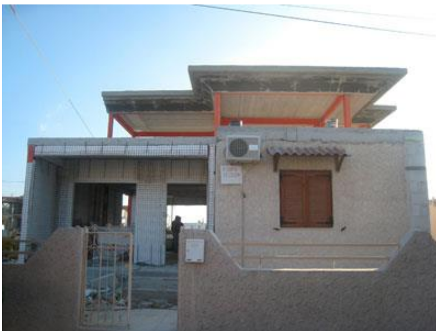
Εικ. 23 Οριζόντια και καθ' ύψος προσθήκη και ενίσχυση υπάρχοντος κτιρίου, Κινέτα
