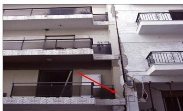
Εικ. 22 a. Εμβολισμός γειτονικών κτιρίων τα οποία δεν φέρουν αντισεισμικό αρμό, b. Εμβολισμός γειτονικών κτιρίων τα οποία δεν φέρουν αντισεισμικό αρμό και υπάρχει διαφορά στάθμης των ορόφων μεταξύ τους. (Βλάβες σε δομικά και μη δομικά στοιχεία από σεισμό)
