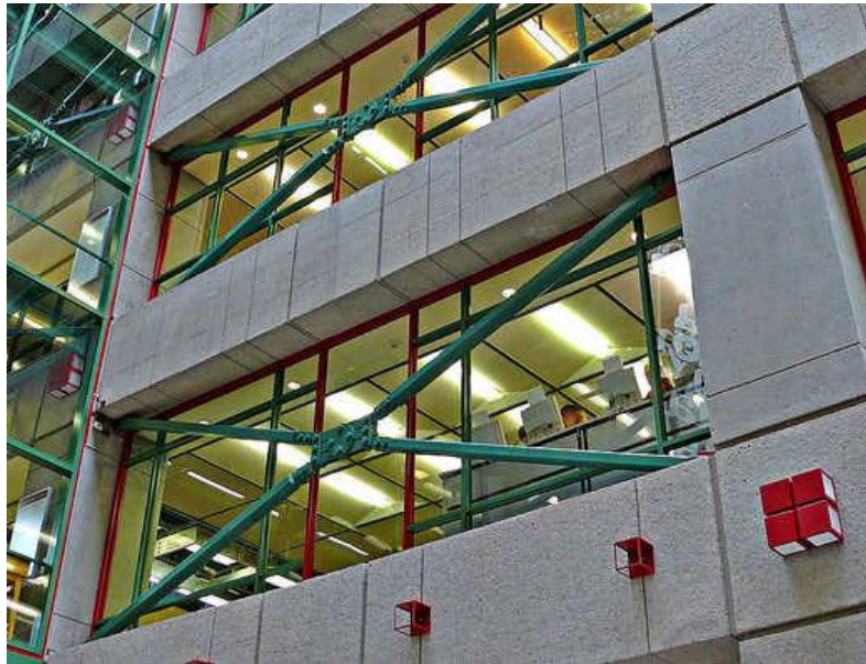
Εικ. 50 Αποσβεστήρας τριβής σε υφιστάμενο κτίριο
