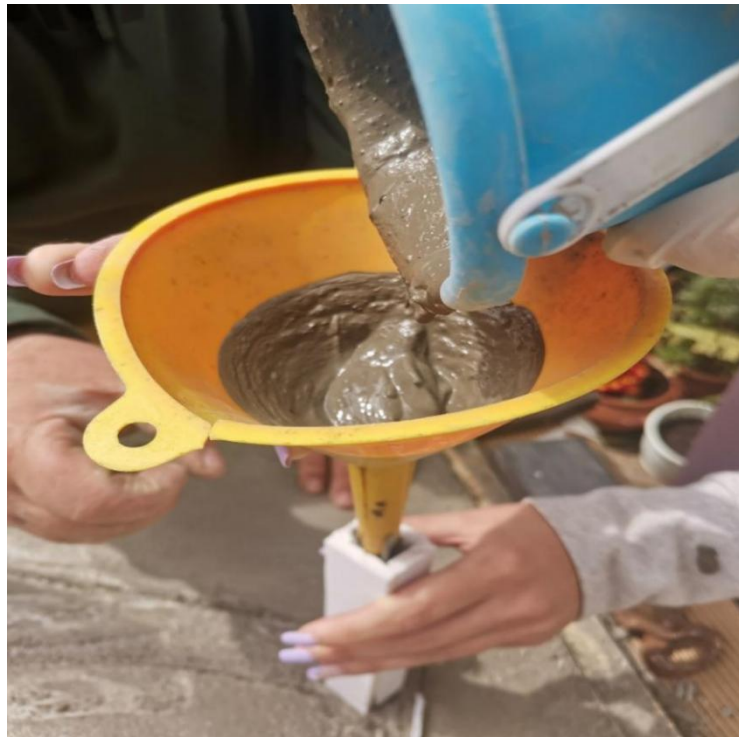
Εικόνα 22: Έκχυση σκυροδέματος στα καλούπια των υποστρωμάτων.
