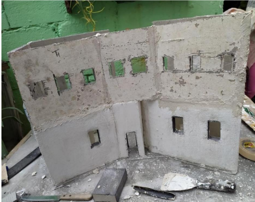
Εικόνα 28: Τοίχοι ορόφου από τσιμεντοσανίδα, πρόσοψη.
