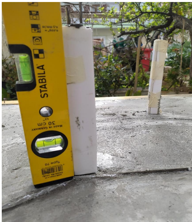
Εικόνα 23: Έλεγχος με το αλφάδι για την ορθότητα των υποστυλωμάτων.
