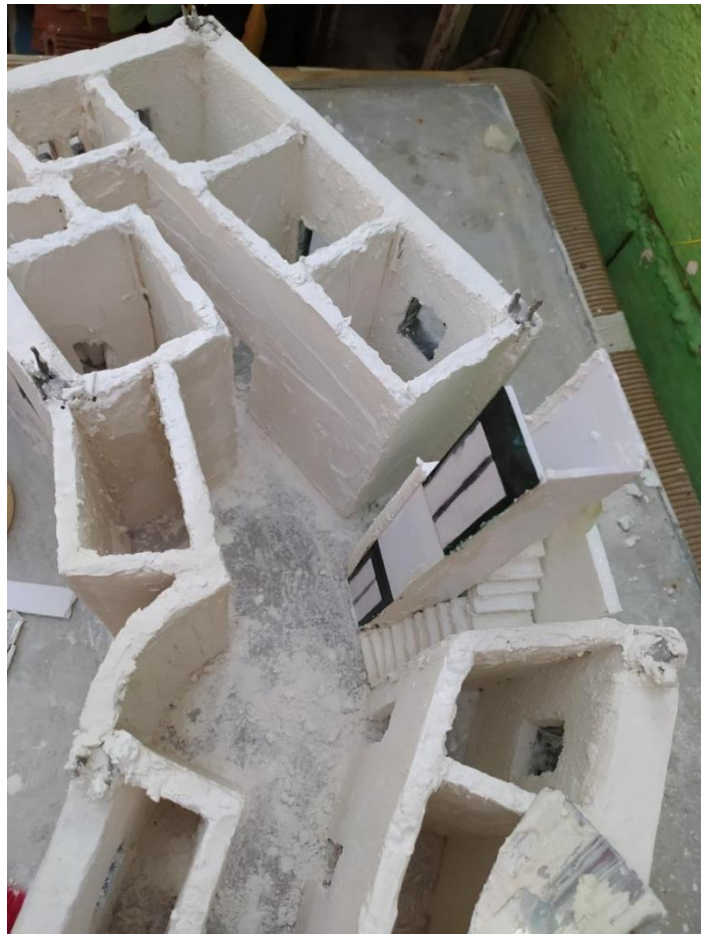
Εικόνα 27: Σοβατισμένοι εσωτερικοί τοίχοι ισογείου.
