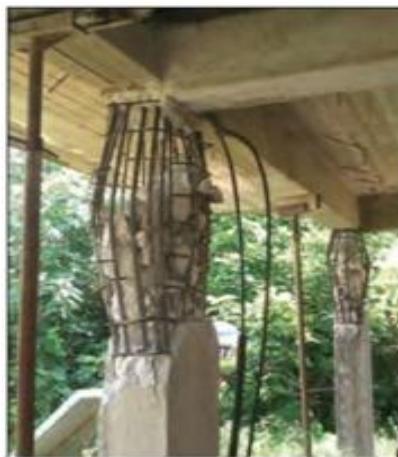
Εικόνα 11: Λυγισμός διαμήκους.
