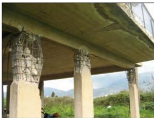
Εικόνα 12: Ισχυρές δοκοί-ασθενή υποστυλώματα.
