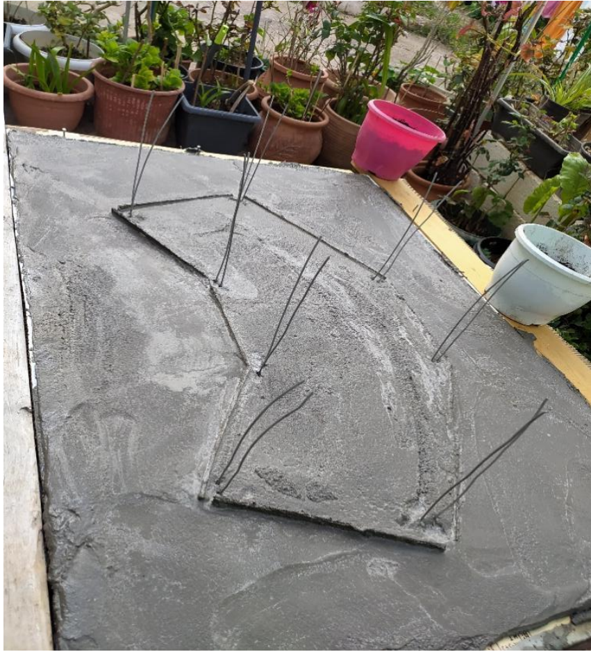
Εικόνα 21: Ορισμός θέσεων υποστρωμάτων με σύρμα.
