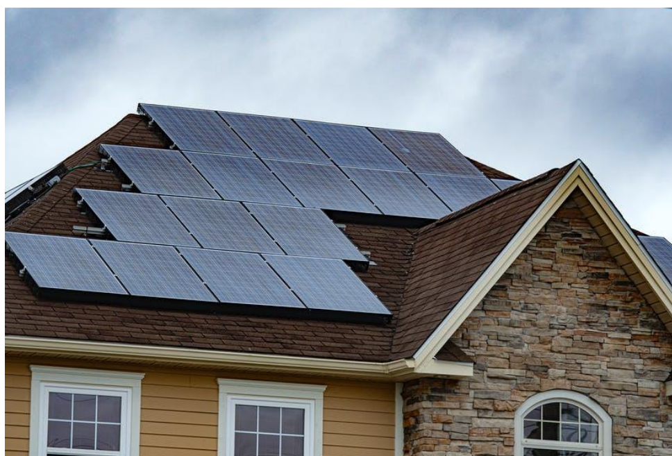
Εικόνα 3-1 ΦΒ πάνελ σε στέγη
