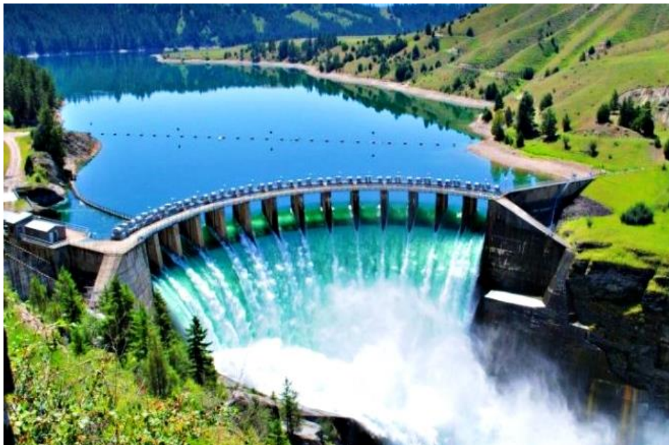
Εικόνα 3-2 Φράγμα υδροηλεκτρικού σταθμού
