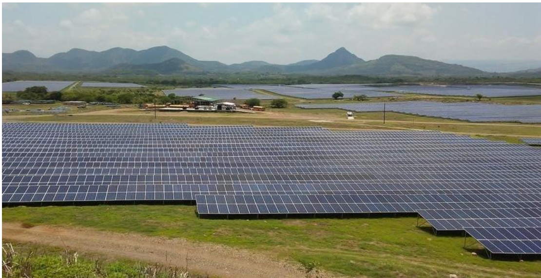
Εικόνα 1.1 Μεγάλης κλίμακας ΦΒ πάρκο 9 MWp που βρίσκεται κοντά στην πόλη της Καρδίτσας, ( https://balkangreenenergynews.com/9-mwp-solar-park-greeces-first-1500-dc-system-put-into-commercial-operation/ )
