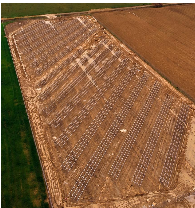
Εικόνα 4.2 Τα τραπέζια πάνω στα οποία θα τοποθετηθούν τα πάνελ ( https://evagsolar.gr/%CE%B2%CE%AC%CF%83%CE%B5%CE%B9%CF%82%CF%83%CF%84%CE%AE%CF%81%CE%B9%CE%BE%CE%B7%CF%82%CF%86%CF%89%CF%84%CE%BF%CE%B2%CE%BF%CE%BB%CF%84%CE%B1%CF%8A%CE%BA%CF%8E%CE%BD/ )
