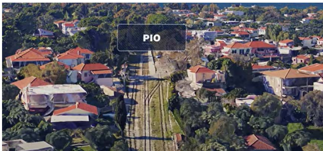
Εικόνα 59. Θέση στάση "Ρίο".[31]
