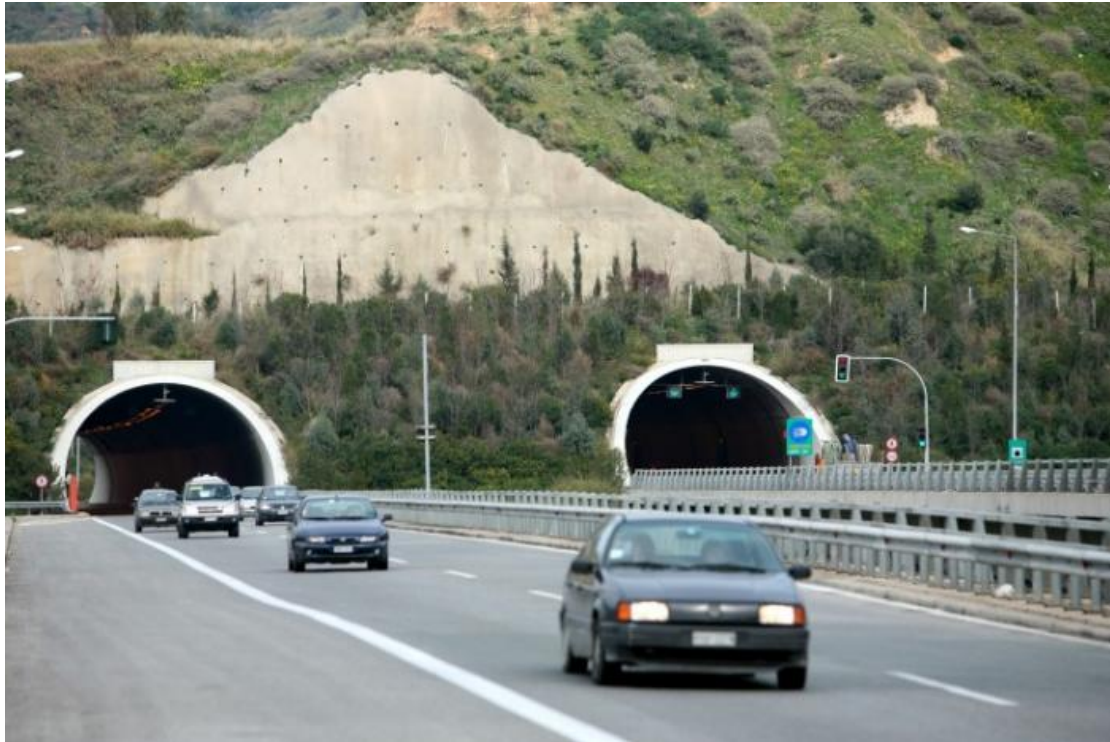
Εικόνα 13. Όψη σηράγγων οδού. (google maps)
