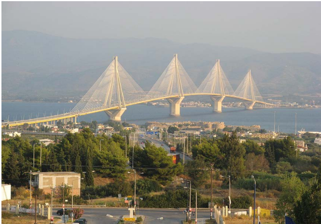
Εικόνα 9. Γέφυρα Ρίου - Αντίρριου. (google maps)
