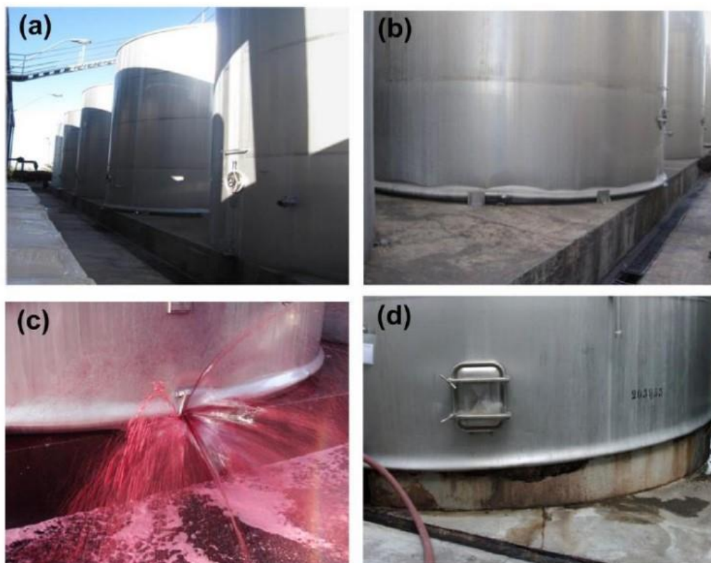
Εικόνα 1.2 Λυγισμός του κελύφους στην βάση της δεξαμενής (elephantfoot) (González et al., 2013)
