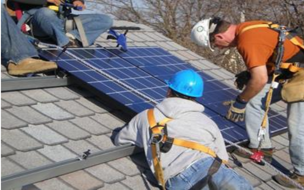
Εικόνα 23: Εγκατάσταση Φωτοβολταϊκών Συστημάτων
