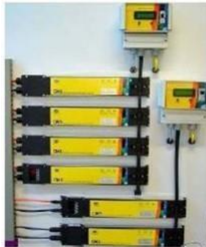
Εικόνα 4.1.4 Αντιστροφείς για ενσωμάτωση σε Φ/Β πάνελ
