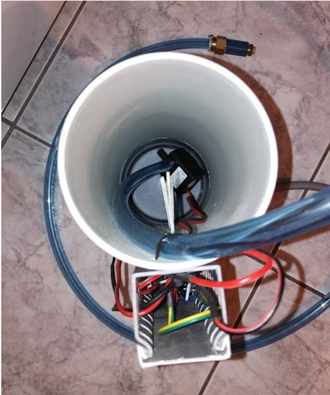
Εικόνα 12: Το εσωτερικό της δεξαμενής.
