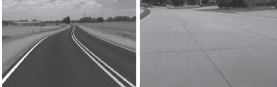
Εικόνα 1 Εύκαμπτο (αριστερά) και δύσκαμπτο (δεξιά) οδόστρωμα
