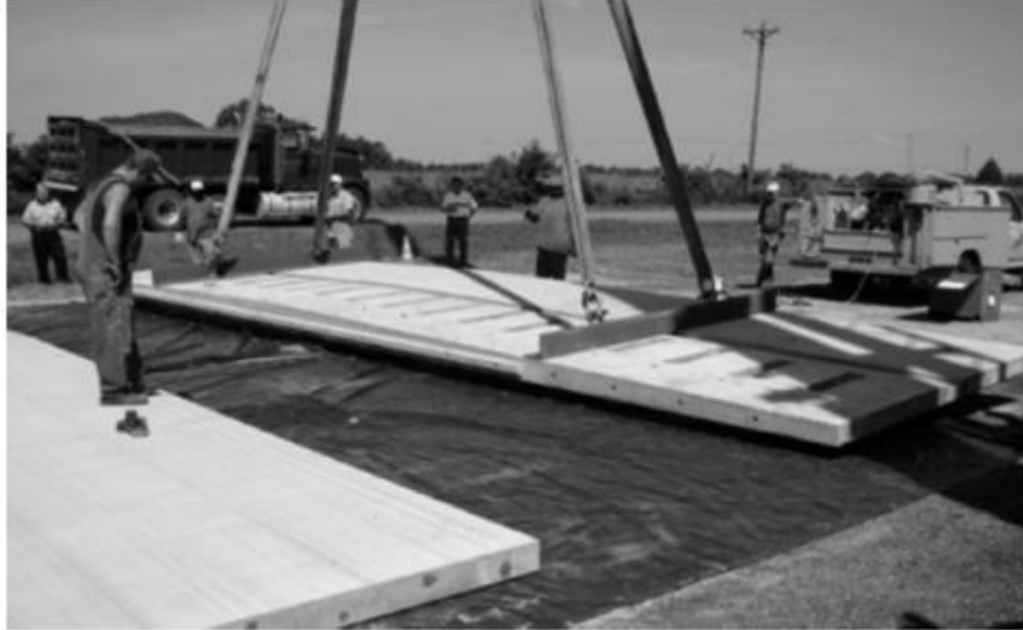
Εικόνα 8 Πάνελ προεντεταμένου σκυροδέματος που τοποθετείται πάνω από βάση
