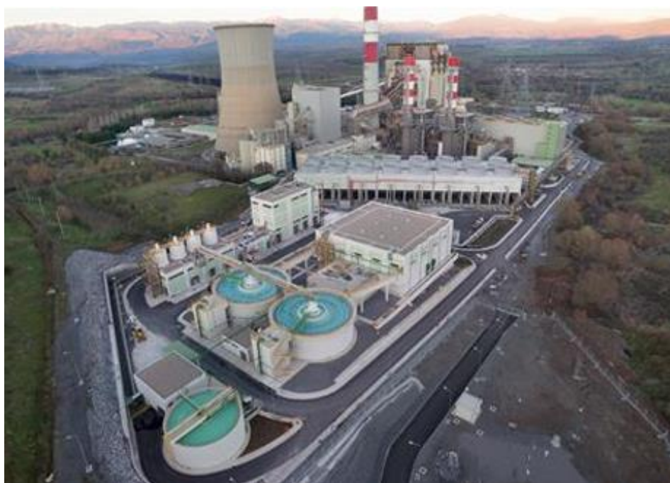
Εικόνα 4.4: Μονάδα 5 Φυσικού Αερίου του ΑΗΣ Μεγαλόπολης.
