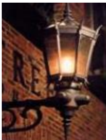
Εικόνα 1.1: Φωτισμός δρόμου με φυσικό αέριο.
