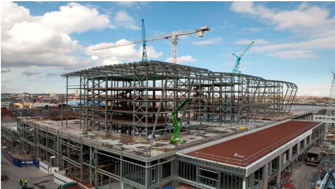
Εικόνα 1 Χαλύβδινη κατασκευή με συνδέσμους (braced steel frame)
