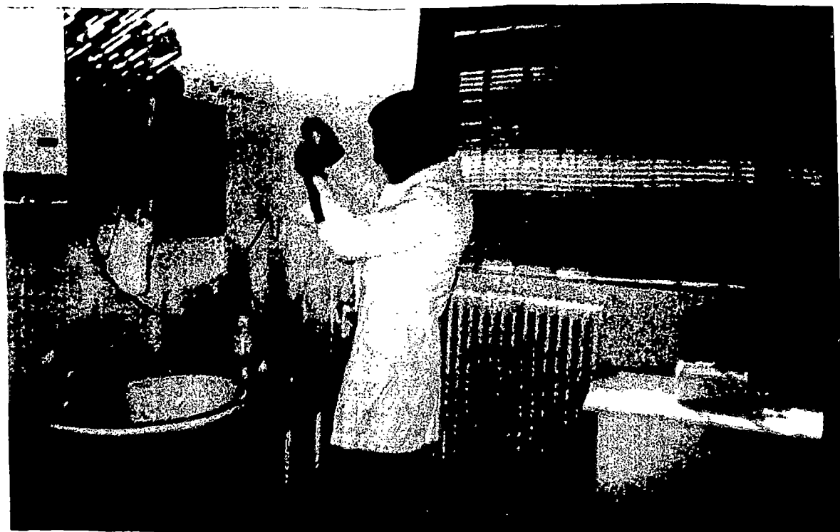
Εικ.17. Επεξεργασία των δειγμάτων του νερού με την βοήθεια του φασματοφωτομέτρου HACK DR/2000.
