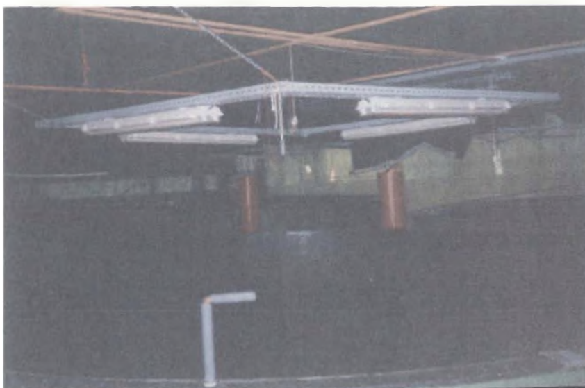
Εικ.4.4. Μόνιμη κατασκευή φωτισμού πάνω από το μεσόκοσμο. Στο βάθος διακρίνονται τα μαύρα φύλλα μαζεμένα στην οροφή.
