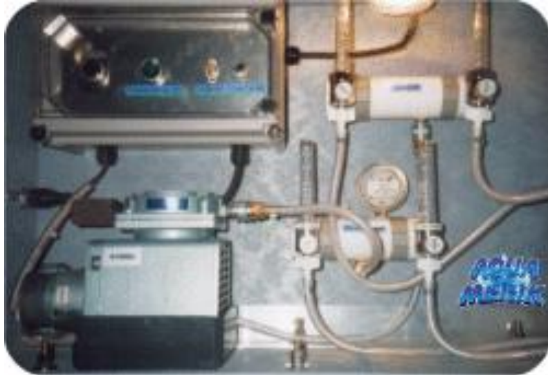
Εικ. 3.8. Καταγραφικό σύστημα ποιότητας νερού στο φορτηγό μεταφοράς ( www.aquamerik.com ).
