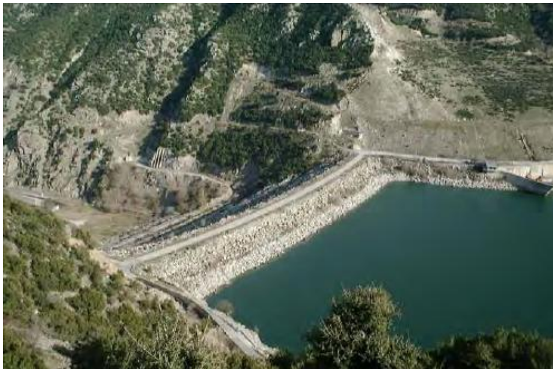
Εικόνα 33 Ο υδροηλεκτρικός σταθμός Πολυφύτου
