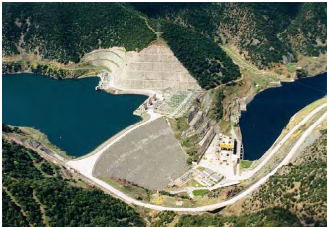
Εικόνα 34 Ο υδροηλεκτρικός σταθμός Σφηκιάς
