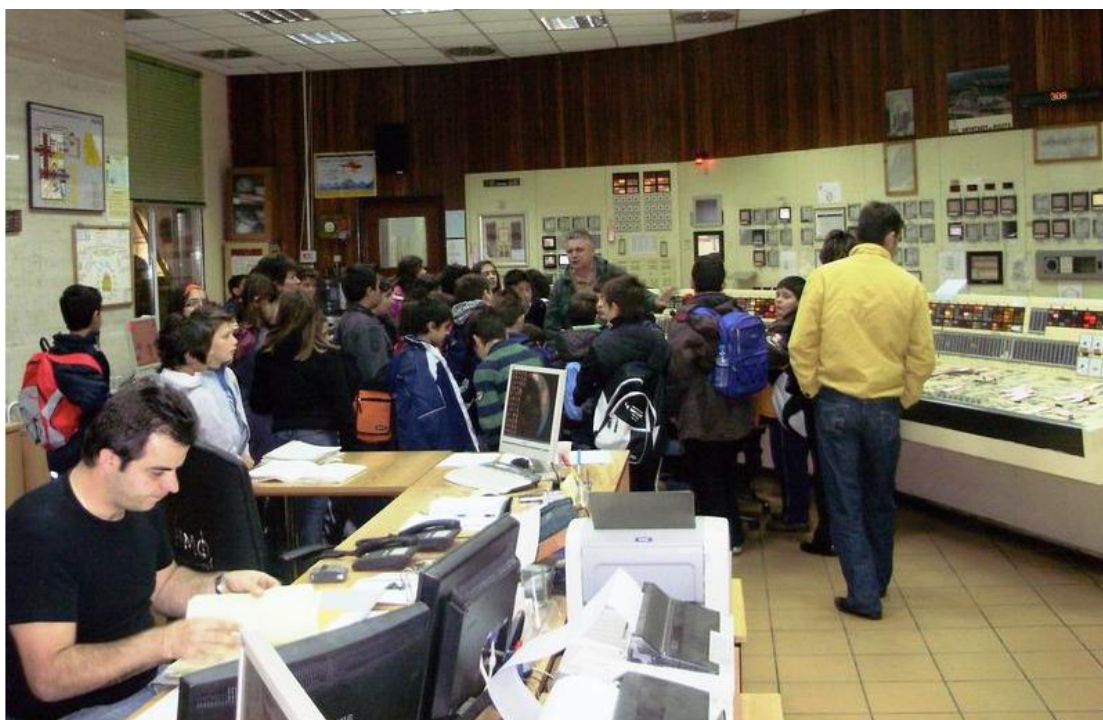
Εικόνα 39 Το κέντρο λειτουργίας του υδροηλεκτρικού σταθμού του Άγρα (dim-rizou.pel.sch.gr)
