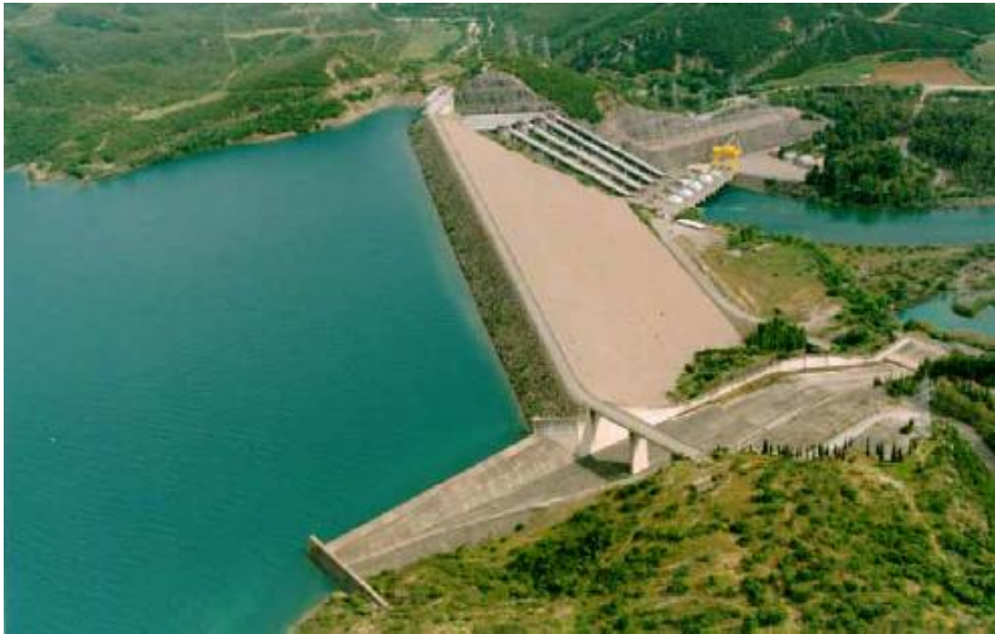
Εικόνα 29 Ο υδροηλεκτρικός σταθμός Καστρακίου, με φράγμα ύψους 96 μέτρων ο οποίος λειτουργεί από το 1969
