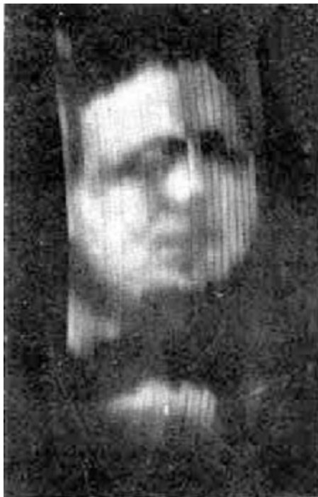
Εικόνα 1.4: Δείγμα εικόνας που μεταδόθηκε μέσω της συσκευής του Μπερντ (πηγή: www.slideshare.net )
