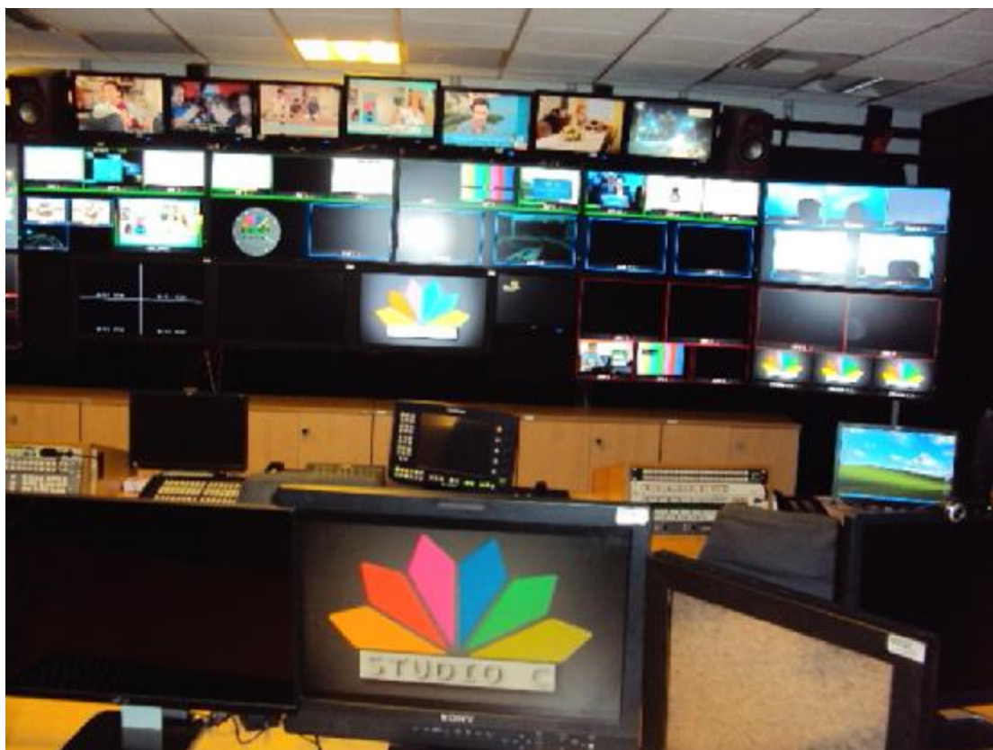
Εικόνα 4.6: Το master control του Star channel (Αίθουσα ελέγχου παραγωγής)
