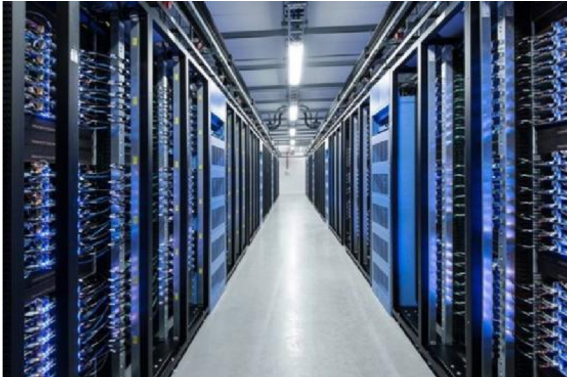
Εικόνα 4.3: Οι servers του τηλεοπτικού καναλιού Star (Πηγή: www.coindex.com )
