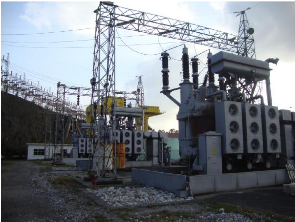
5.19 Μετασχηματιστής ισχύος στον ΥΗΣ Καστρακίου
