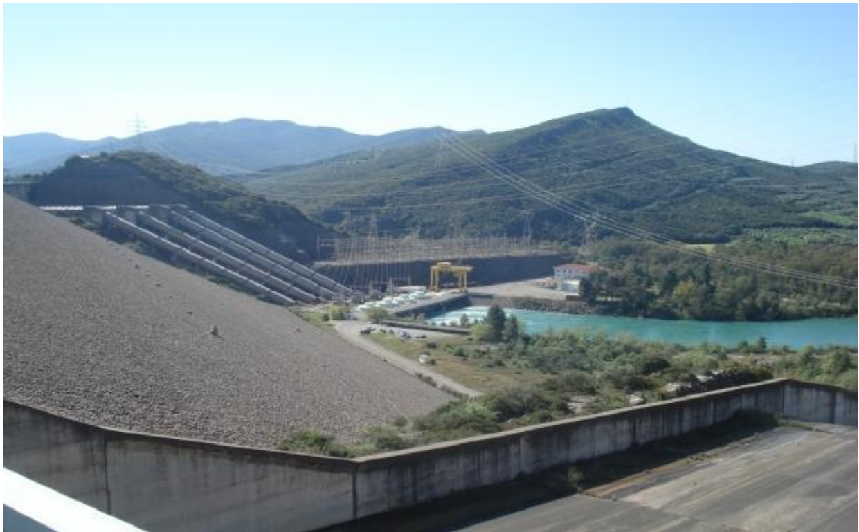
Εικόνα 2.6: Λιθόριπτο φράγμα στο Καστράκι Αιτωλοακαρνανίας
