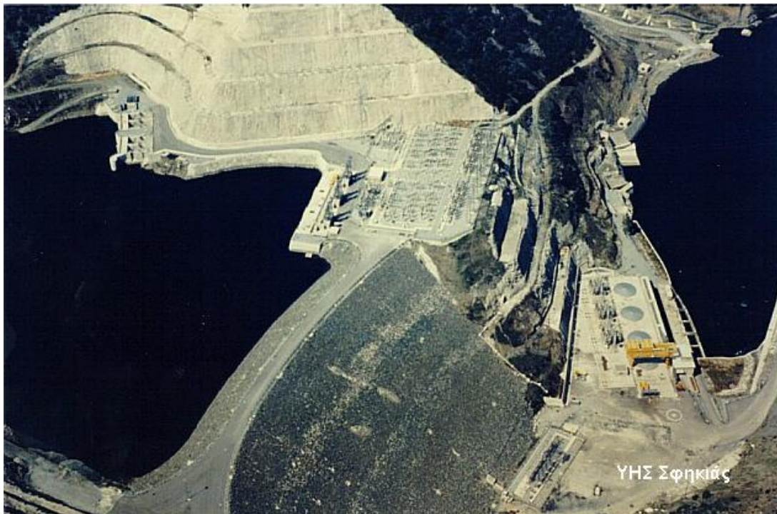
Εικόνα 2.7: Το χωμάτινο φράγμα του ΥΗΣ Σφηκιάς
