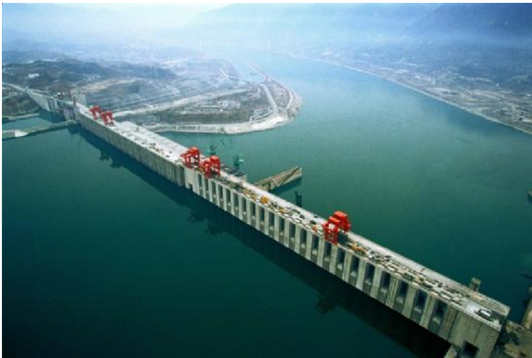
Εικόνα 1.2: Υδροηλεκτρικός σταθμός στην Κίνα.
