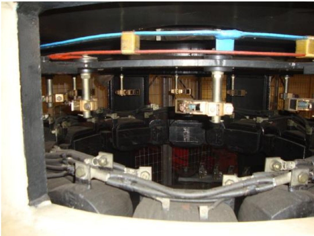
5.17 Στάτης της διέγερσης της διεγέρτριας και οι θήκες των ψηκτρών
