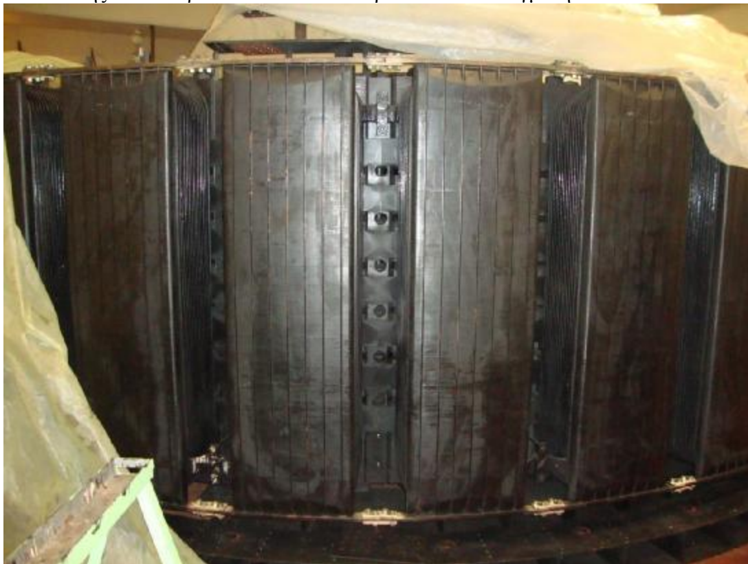
5.8 Πυρήνας των πόλων μαζί με τα τυλίγματα. Αμορτισέρ περιέλιξης συγκολλημένα στους πόλους. (πάνω και κάτω). Ανεμιστήρας του ρότορα. (κάτω). Καστράκι, έτος 2015
