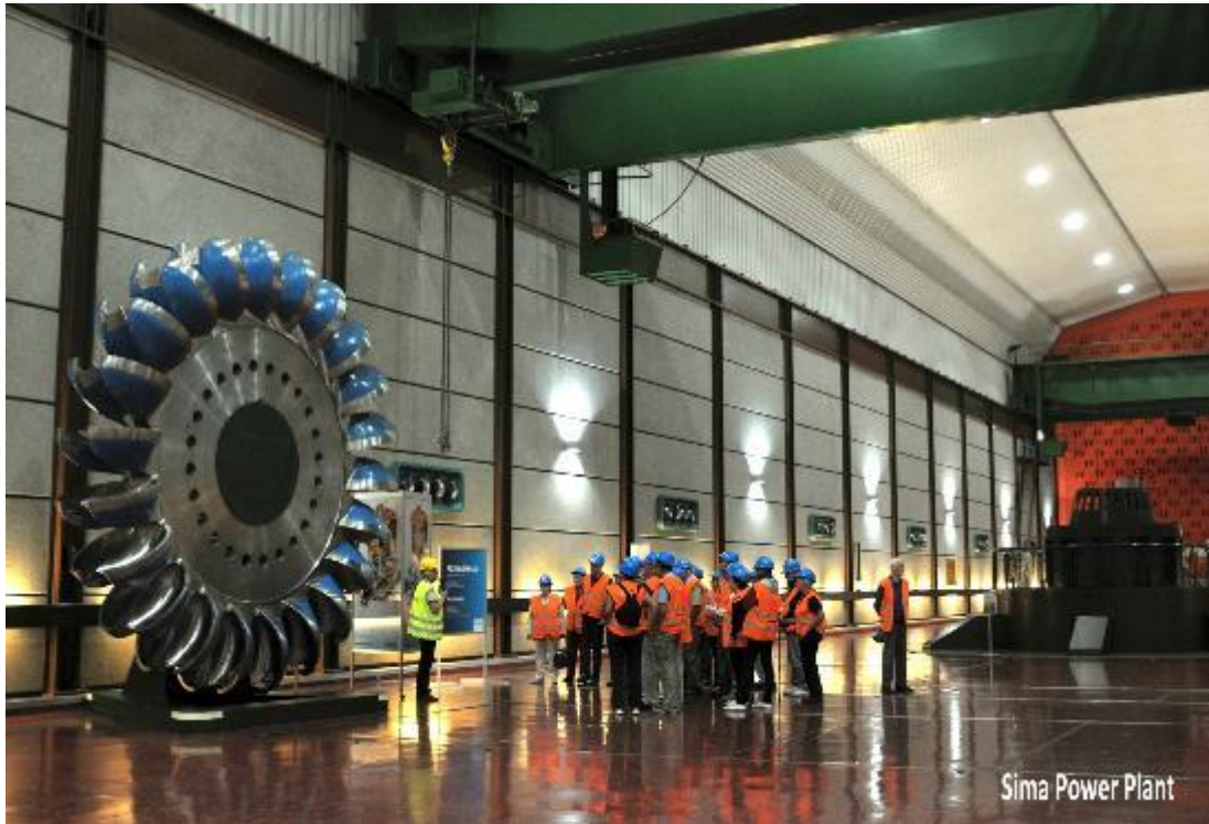
Εικόνα 20 : Το εργοστάσιο της Sima στη Νορβηγία
