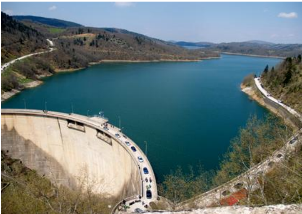
Εικόνα 1.4: Τοξωτό φράγμα στον Ταυρωπό ποταμό.
