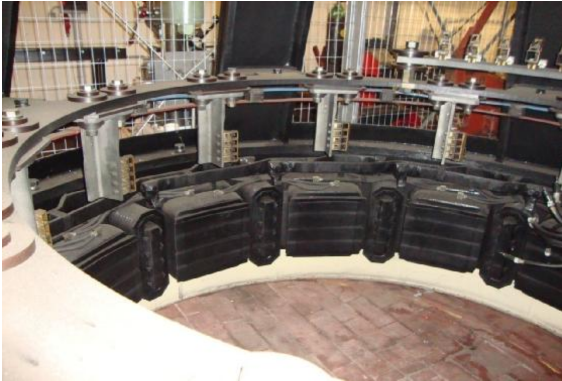
5.16 Στάτης της διέγερσης και οι θήκες των ψηκτρών
