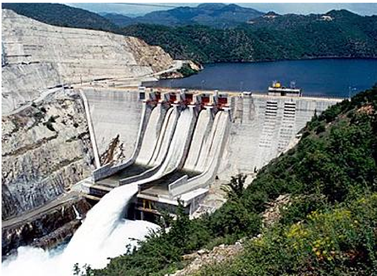
Εικόνα 2.3: ΥΗΣ Πλατανόβρυσης, κτίστηκε από κυλινδρούμενο σκυρόδεμα αποτελούμενο από ένα μέρος τσιμέντου και τρία μέρη τέφρας προερχόμενης από το ΘΗΣ της Πτολεμαΐδας.
