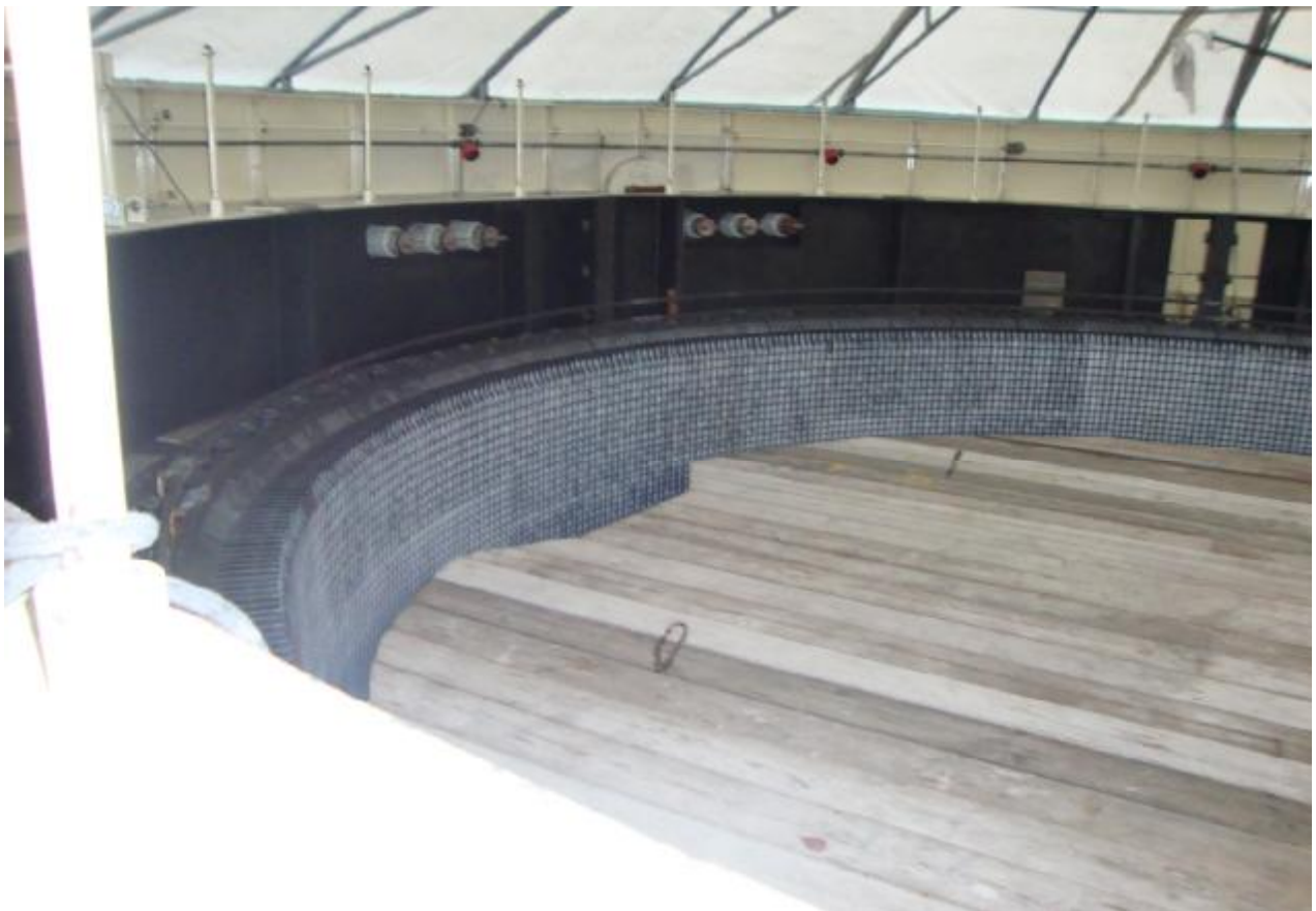
5.7 Επισκευή του πυρήνα του στάτη στο ΥΗΣ Καστρακίου. Έτος 2015
