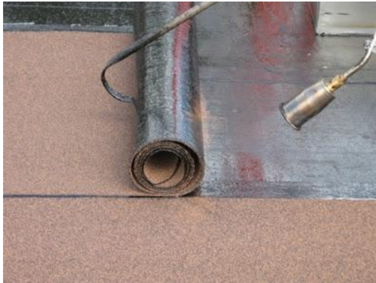
Εικόνα 13: Επικολλημένου ασφαλτοπάνου με επικάλυψη φύλλο αλουμινίου
