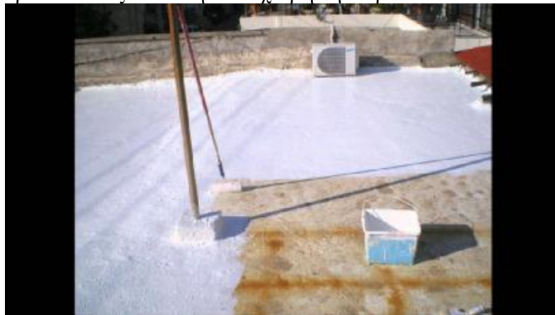
Εικόνα 3: Υγρομόνωση με επαλειφόμενο στεγανωτικό
