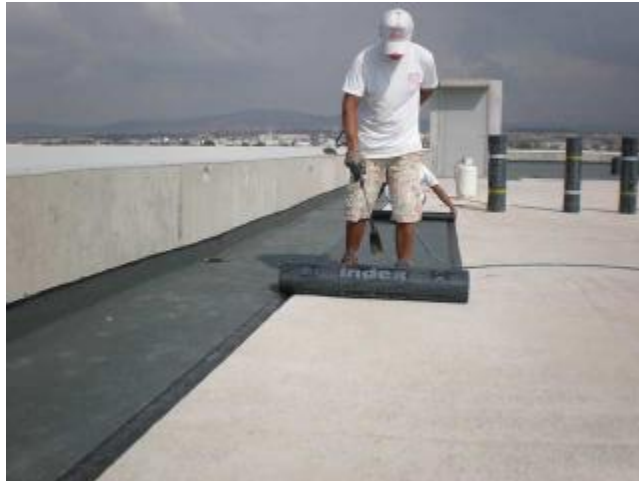
Εικόνα 2: Υγρομόνωση με ασφαλτόπανο
