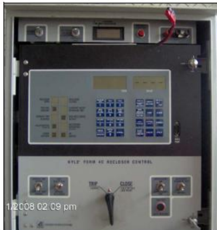
Εικόνα 11: Πίνακες ελέγχου του Δ/ΑΕ ΚVΦΜΕ
