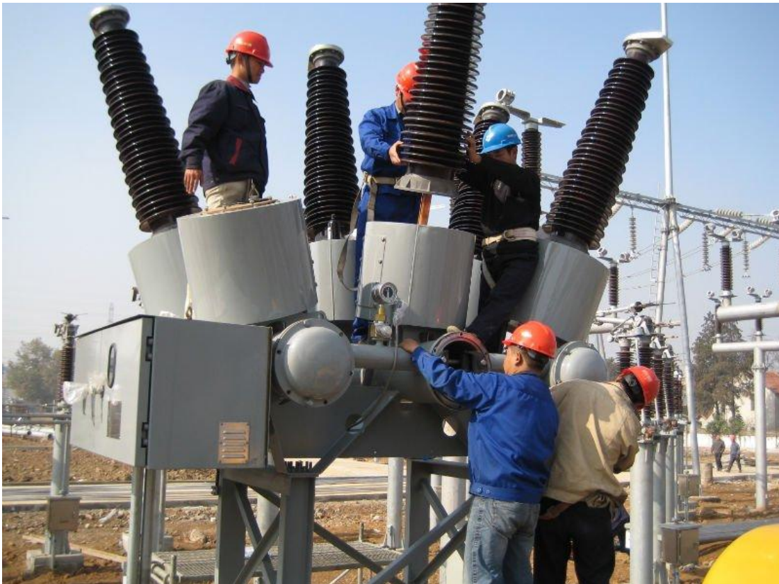
Εικόνα 17: Αυτόματοι Διακόπτες εξαφθοριούχου θείου SF 6
