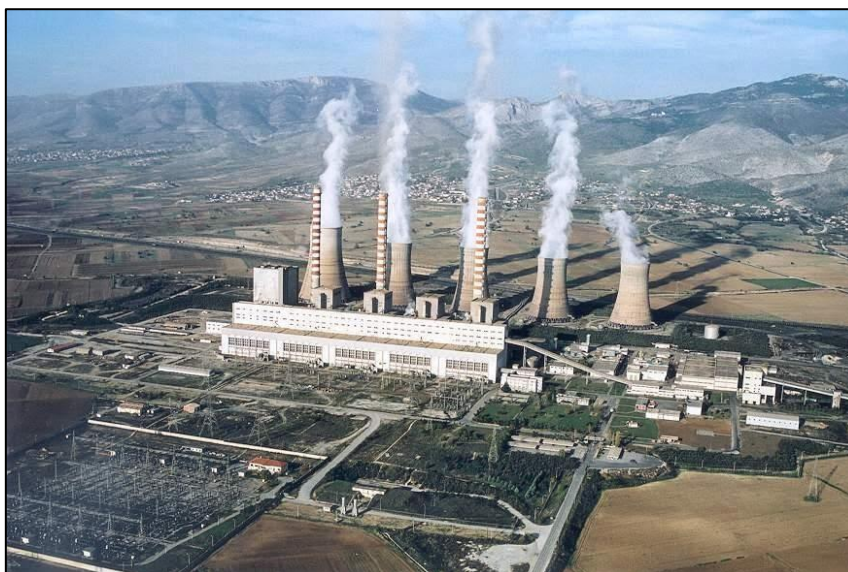
Εικόνα Ν.ο. 2 θερμοηλεκτρικός σταθμός
