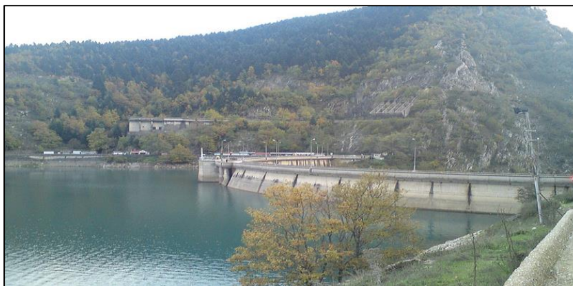
Εικόνα Ν.ο. 3 Υδροηλεκτρικό φράγμα στη λίμνη Πλαστήρα
