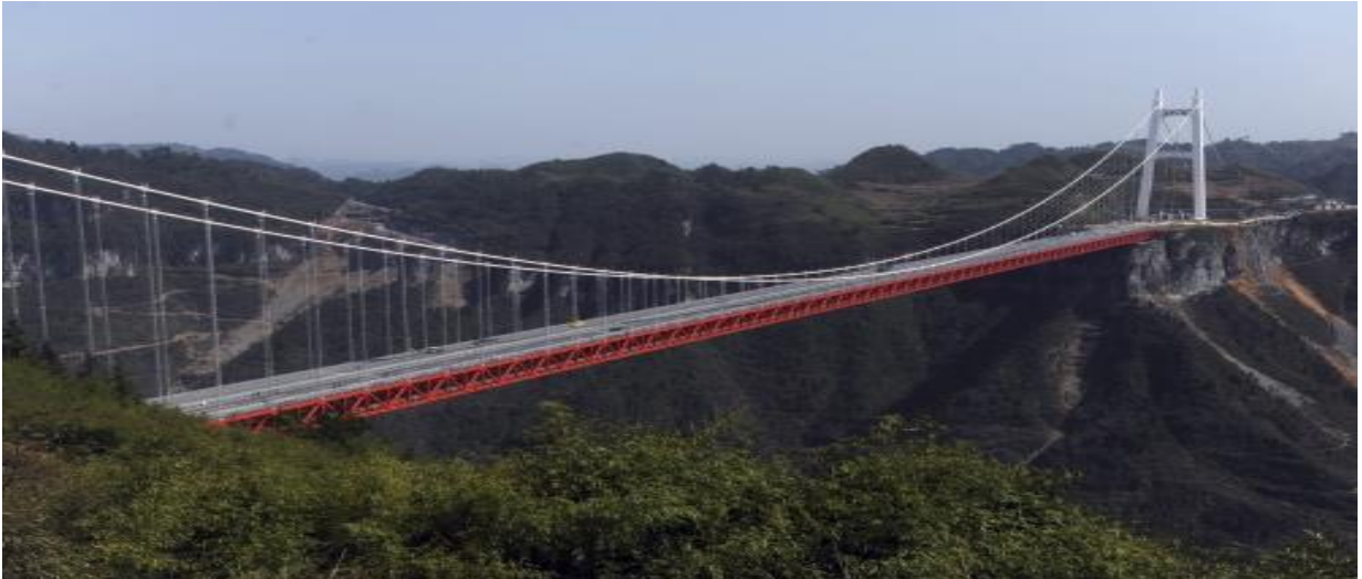
Σχήμα 1.1 : Γέφυρα «Aizhai Extra Large Suspension Bridge» στην Κίνα.
