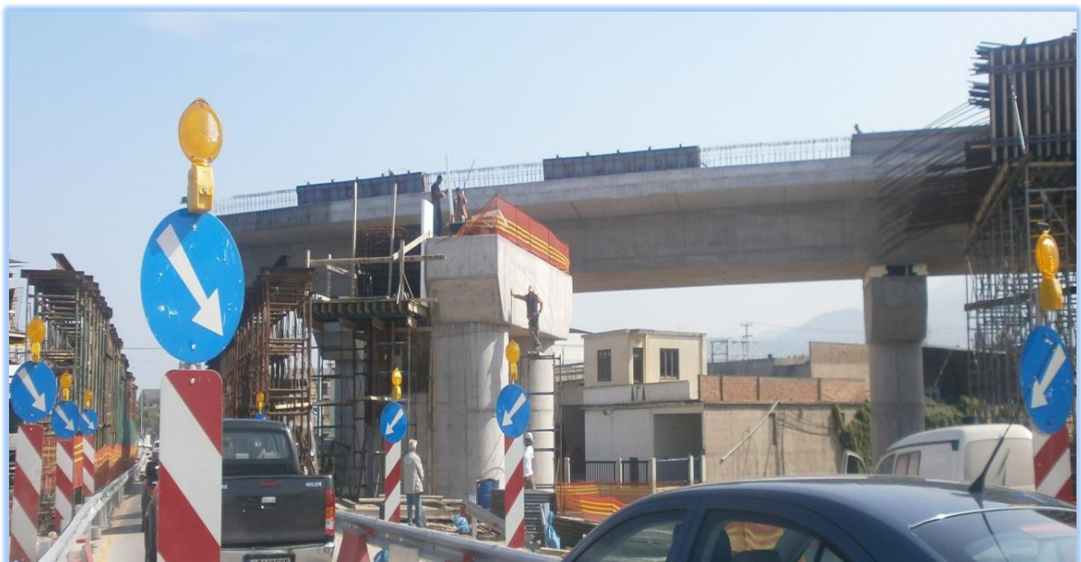
ΦΩΤ. 6.13: ΝΑ όψη του βάθρου M10.Δ, κατά τη φάση κατασκευής, που είναι κοινό με τις γέφυρες T4 και T16.
