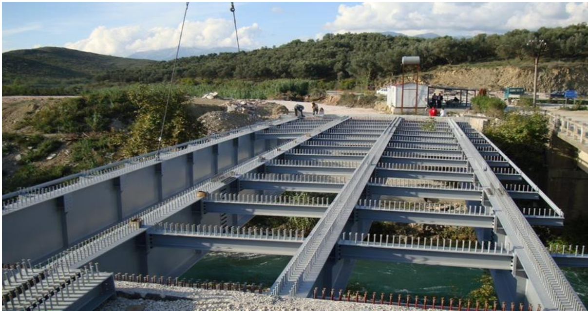
Σχήμα 1.15: Υπόδειγμα σιδηρής γέφυρας.
