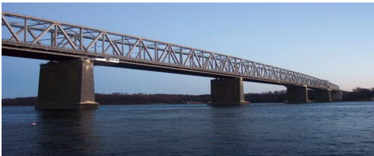
Σχήμα 1.10: Υπόδειγμα δικτυωτής γέφυρας.
