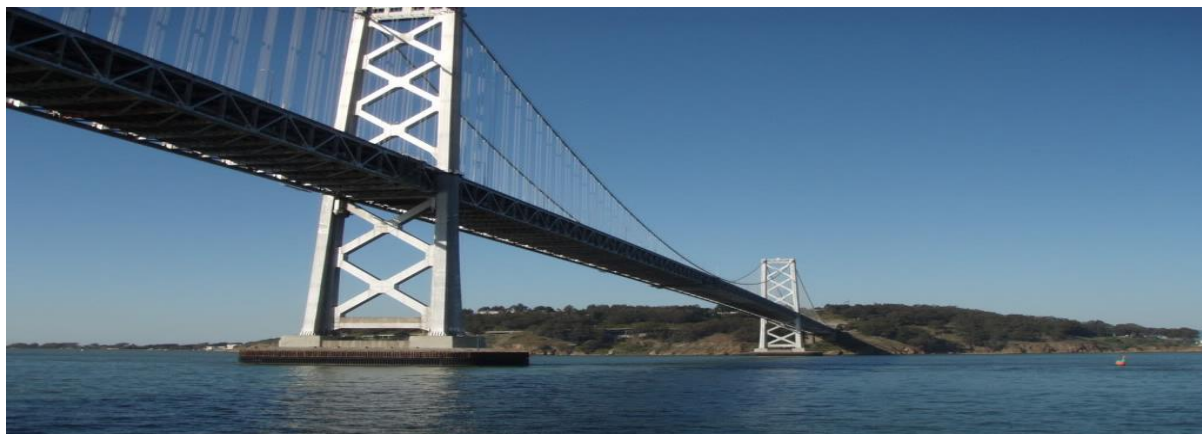
Σχήμα 1.13: Γέφυρα «SAN FRANCISCO-OAKLAND BAY BRIDGE».
