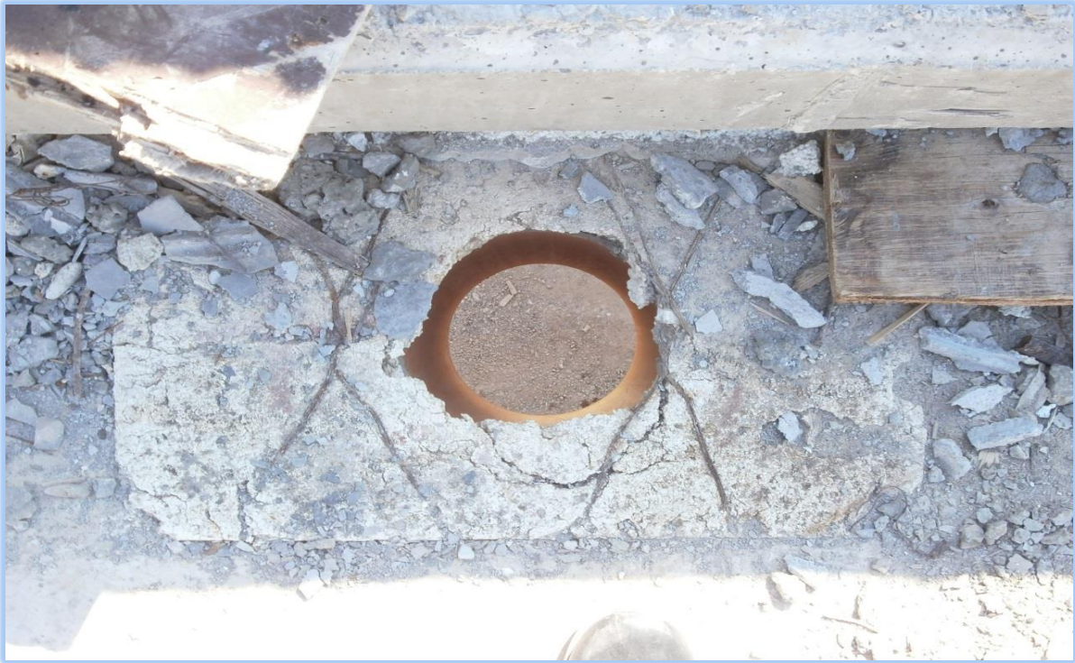
ΦΩΤ. 6.26: Λεπτομέρεια αγωγού παροχέτευσης όμβριων υδάτων.
