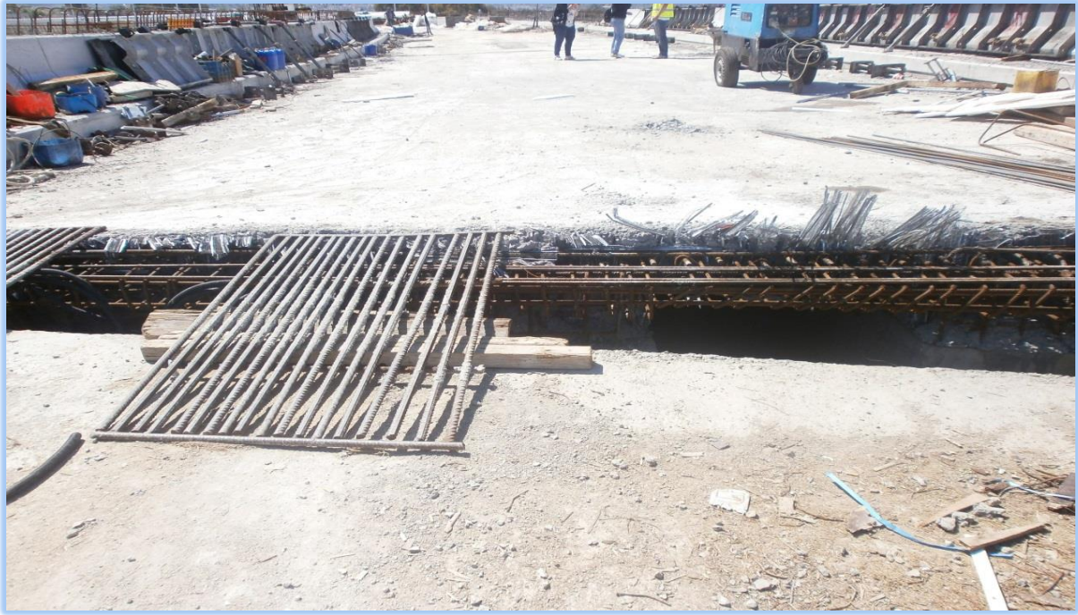
ΦΩΤ. 6.22: Λεπτομέρεια του αρμού μεταξύ της γέφυρας T3 και T2 μετά την ολοκλήρωση σκυροδέτησης του καταστρώματος.
