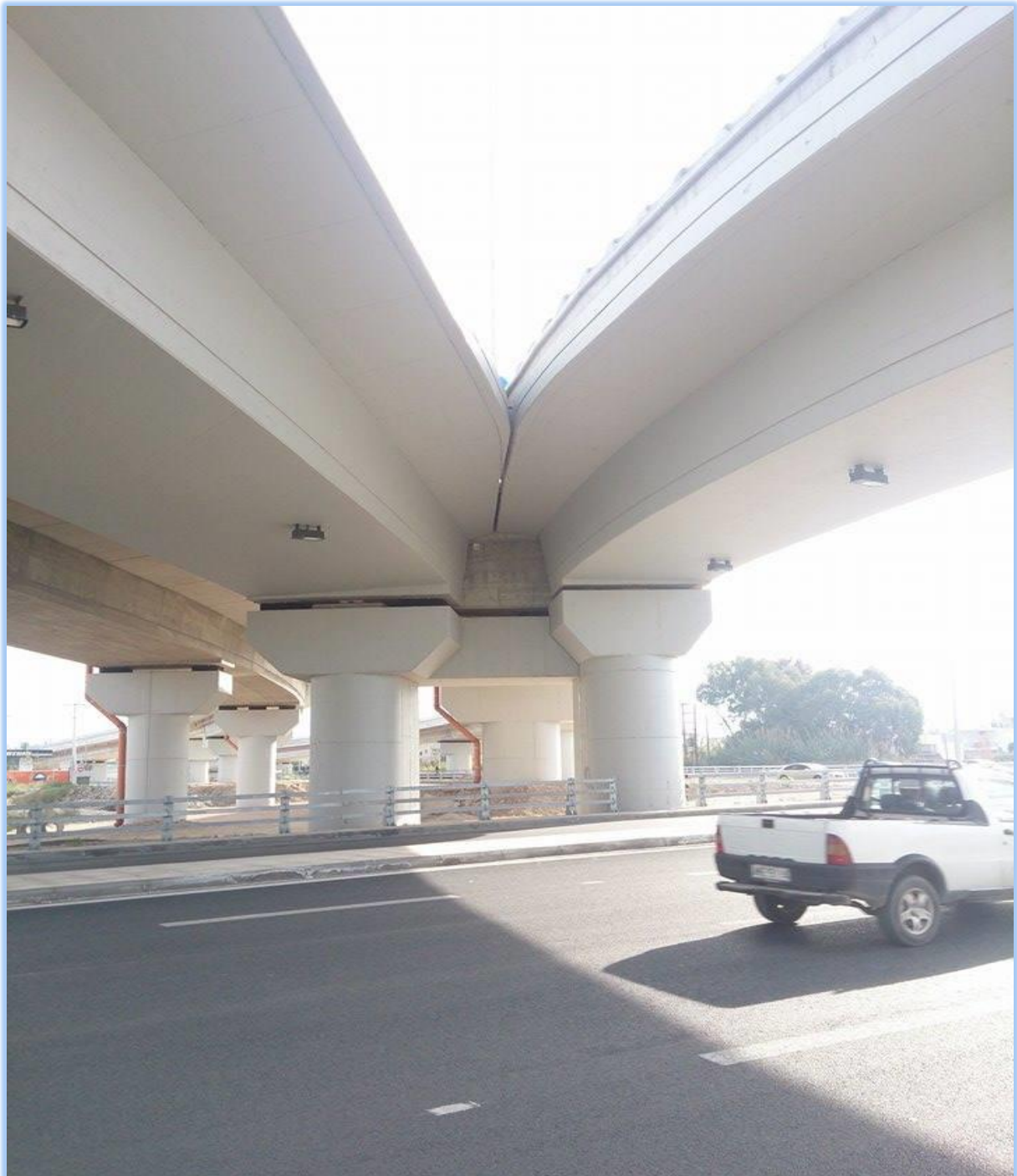
ΦΩΤ. 6.30: Σε 1 ο πλάνο διακρίνεται η Βόρεια όψη του βάθρου M10 και τμήματος του καταστρώματος της γεφυρας T3, δεξιά η γέφυρα T16 του κλάδου Δ και αριστερά σε 2 ο πλάνο η γέφυρα T8 της αριστερής Παραγλαύκιας Αρτηρίας Πατρών, μετά την ολοκλήρωση του έργου.
