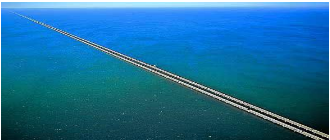
Σχήμα 1.3: Γέφυρα « Lake Pontchartrain Causeway» στη νότια Λουιζιάνα στις Ηνωμένες Πολιτείες.
