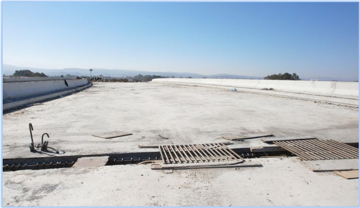
ΦΩΤ. 6.24: Γενική άποψη του καταστρώματος μετά την ολοκλήρωση των εργασιών σκυροδέτησης, διακρίνεται ο αρμός μεταξύ της γέφυρας T2 και T3.
