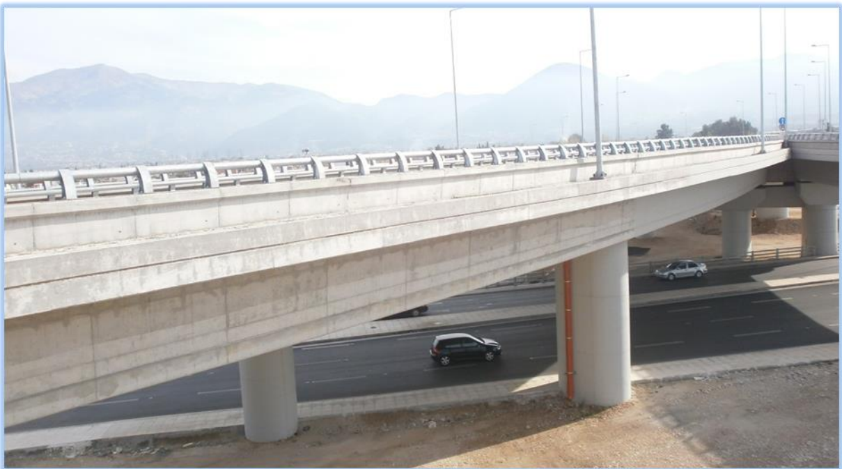
ΦΩΤ. 6.27: Γενική όψη της γέφυρας T3 (δύο ανοιγμάτων), μετά την ολοκλήρωση του έργου.
