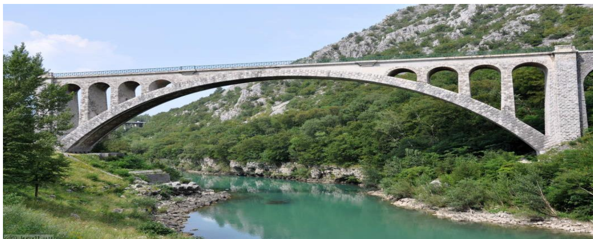
Σχήμα 1.14: Γέφυρα «Solkan Bridge» στη Σλοβενία.
