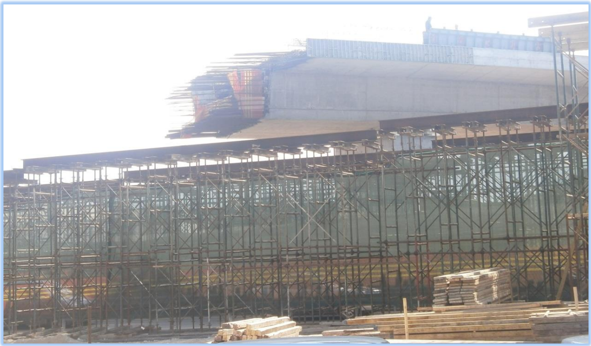
ΦΩΤ. 6.12: Τμήμα γέφυρας T3 κατά τη φάση σκυροδέτησης του καταστρώματος του 2 ου ανοίγματος.
