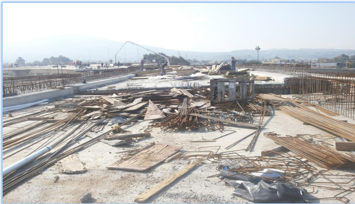
ΦΩΤ. 6.23: Άποψη του καταστρώματος της γέφυρας T3 κατά τις τελικές εργασίες κατασκευής του.
