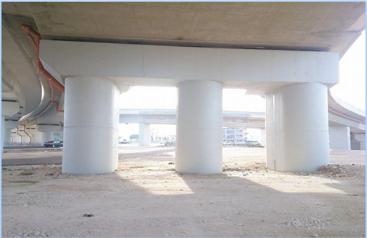
ΦΩΤ. 6.28: Γενική άποψη του βάθρου M8 μετά την ολοκλήρωση του έργου του Ανισόπεδου Κόμβου.
