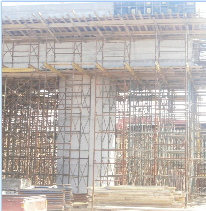
ΦΩΤ. 6.5: Άποψη του βάθρου M9, διακρίνεται η μονολιθική σύνδεση με το κατάστρωμα.
