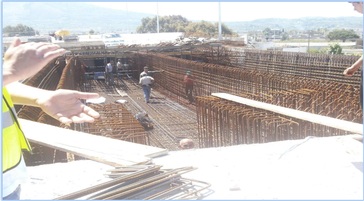
ΦΩΤ. 6.6: Διάταξη οπλισμού της κιβωτιοειδούς διατομής του 1 ου ανοίγματος της γέφυρας T3, πριν τη σκυροδέτηση.
