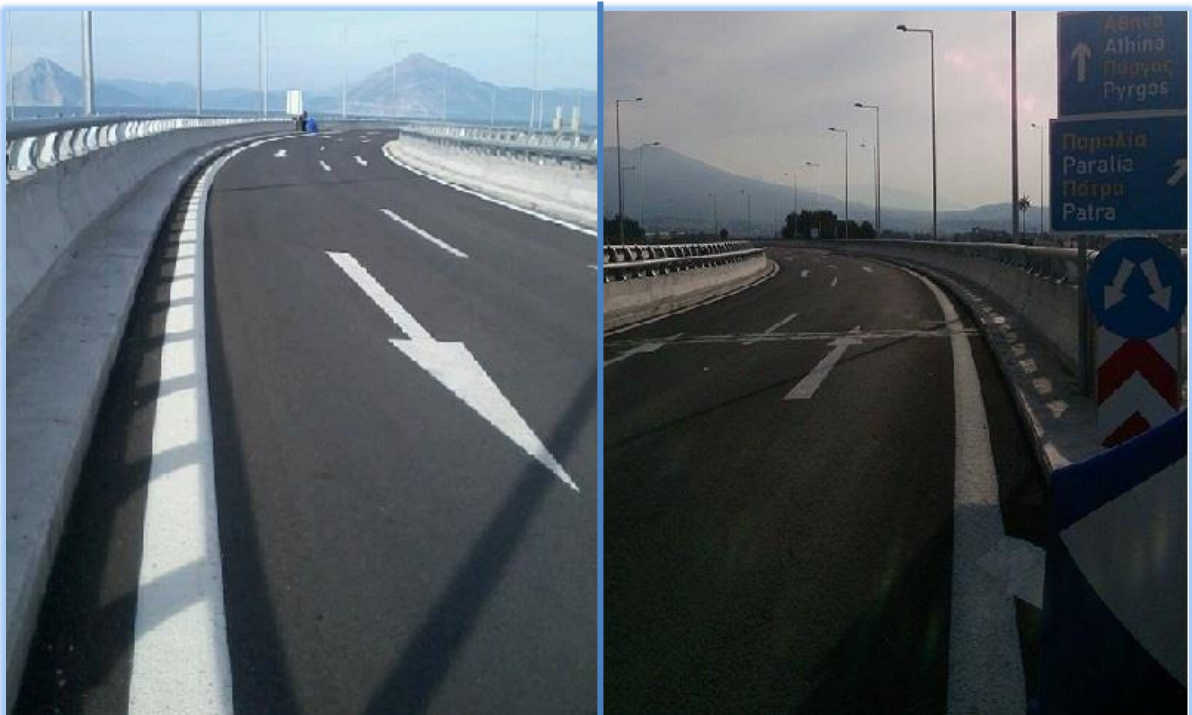
ΦΩΤ. 6.37: Αριστερά το τεχνικό T3 στην κατεύθυνση από το βάθρο M10.Δ προς το M8.Δ, ενώ δεξιά είναι το τεχνικό T3 στην κατεύθυνση από το βάθρο M8.Δ προς το M10.Δ .
