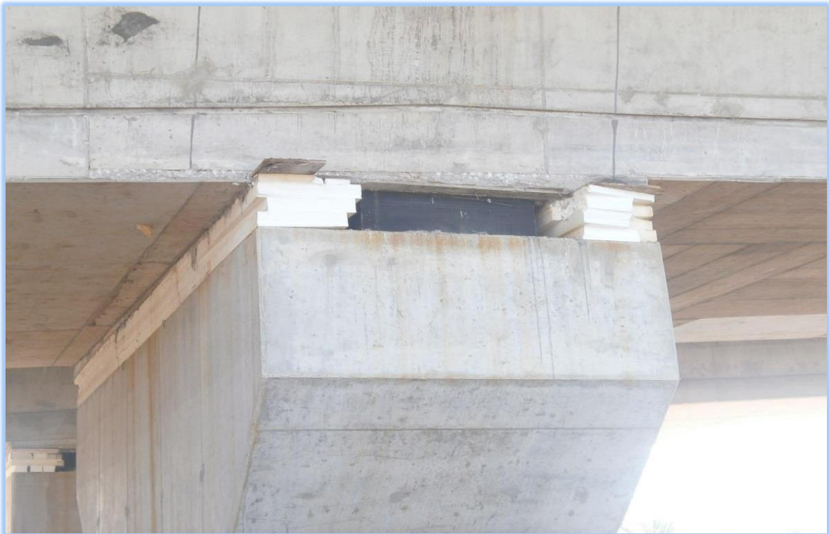
ΦΩΤ. 6.20: Λεπτομέρεια κεφαλής του βάθρου Μ6 (της γέφυρας Τ7), όπου διακρίνονται τα εφόδρανα πριν την αφαίρεση των υποστηριγμάτων τους.
