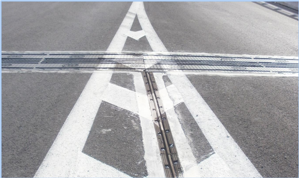
ΦΩΤ. 6.36: Διαχωριστικοί αρμοί μετά την ολοκλήρωση του έργου, στην συμβολή των γεφυρών T3 (αριστερά), T16 (δεξιά) και T4 (μετά τον οριζόντιο αρμό).
