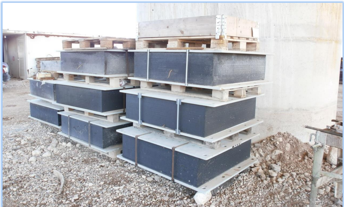
ΦΩΤ. 6.19: Τα εφέδρανα που χρησιμοποιήθηκαν στο σύνολο του έργου του Ανισόπεδου κόμβου.
