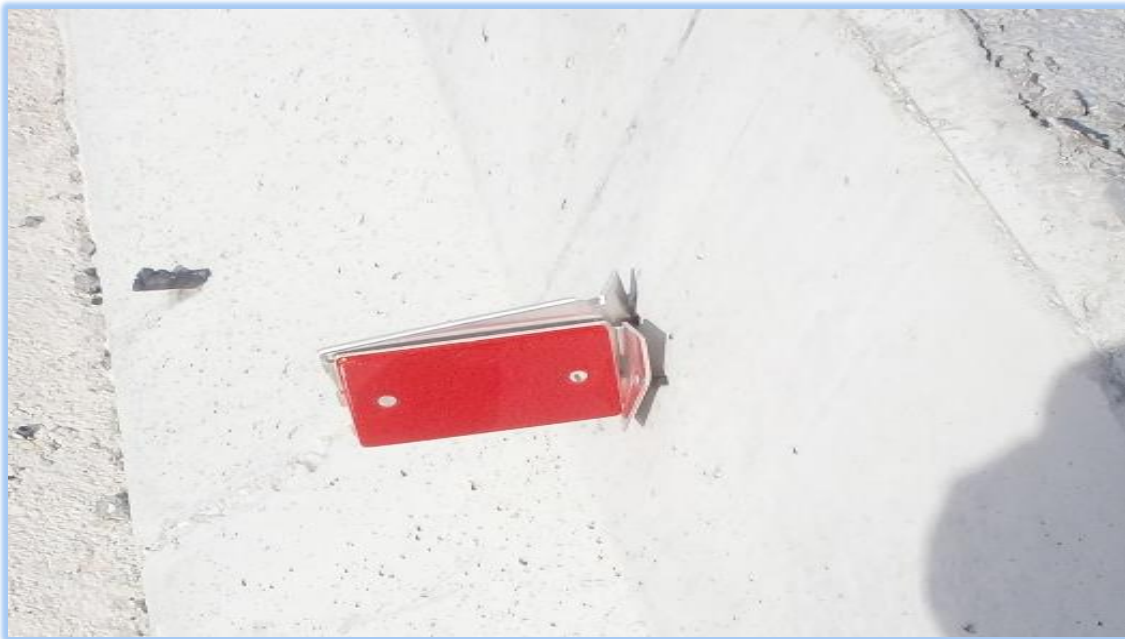
ΦΩΤ. 6.41: Νυχτερινή σήμανση.
