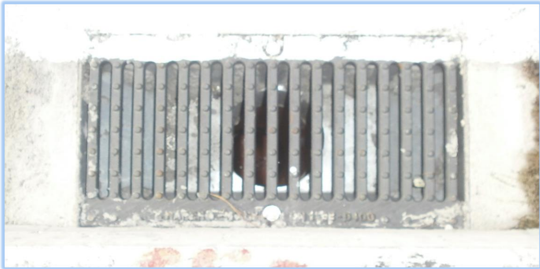
ΦΩΤ. 6.40: Αγωγός υδροδότησης όμβριων υδάτων, με την τοποθέτηση εσχάρας, μετά την ολοκλήρωση του έργου.
