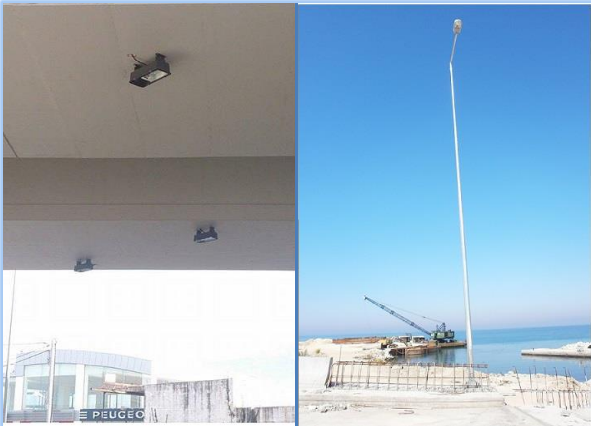
ΦΩΤ. 6.38: Λάμπες ηλεκτροφωτισμού κάτωθεν και άνωθεν της γέφυρας T3.
