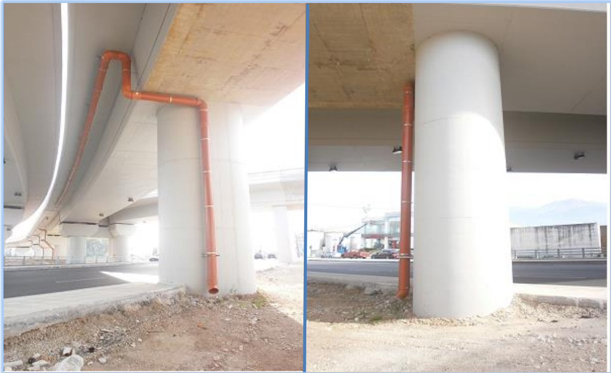
ΦΩΤ.6.32: Βάθρο Μ9, δυτική όψη (αριστερά) και ανατολική όψη στα (δεξιά).
