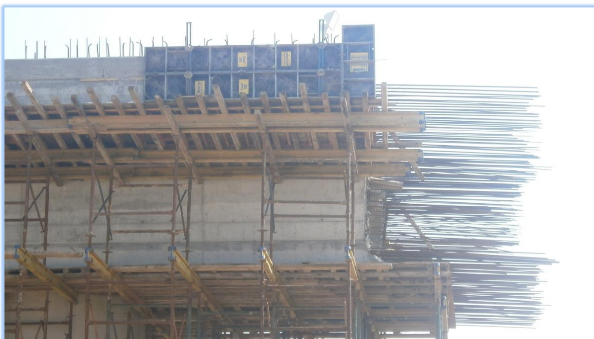
ΦΩΤ. 6.11: Αναμονές οπλισμού στο άκρο του 1 ου ανοίγματος της γέφυρας T3, άνωθεν του μεσόβαθρου M9.
