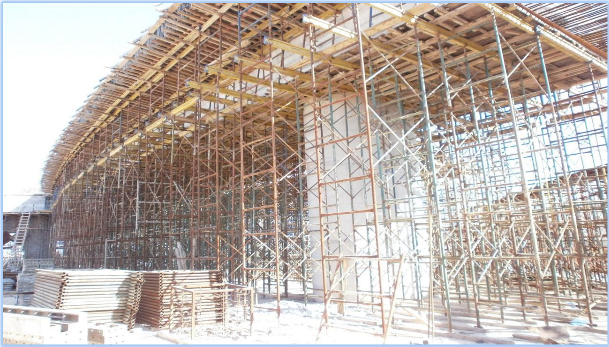
ΦΩΤ. 6.4: Νότια όψη του 1 ου ανοίγματος της γέφυρας T3, στη φάση ξυλοτύπων στη θέση του μεσόβαθρου M9-διακρίνεται η πυκνή διάταξη ικριωμάτων.
