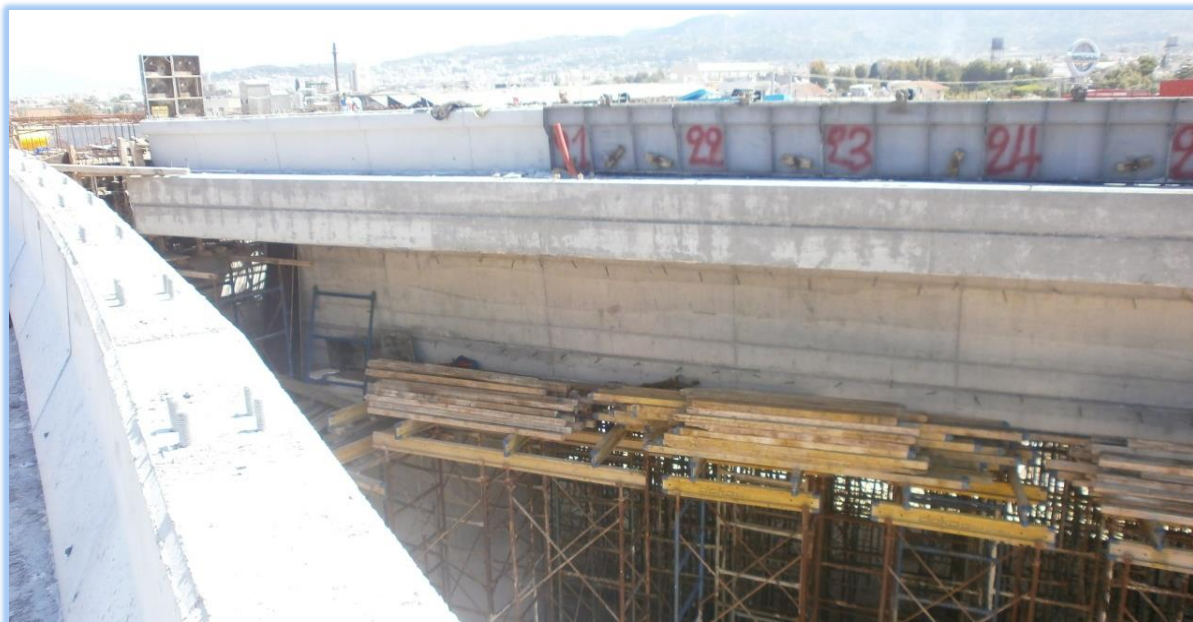
ΦΩΤ. 6.10: Παρούσα γέφυρα T3 μετά την αφαίρεση τμήματος ξυλοτύπων της ανωδομής και των πεζοδρομίων (σε 1 ο πλάνο φαίνεται η Ανατολική όψη του κλάδου Γ - γέφυρας T17) .
