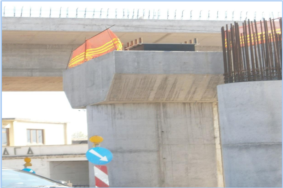
ΦΩΤ. 6.14: Το ακρόβαθρο M10 κατά την αρχική φάση τοποθέτησης ελαστομεταλλικών εφεδράνων.
