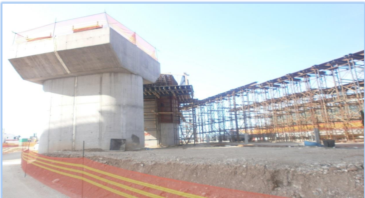
ΦΩΤ. 6.15: Νότια όψη του βάθρου M10.
