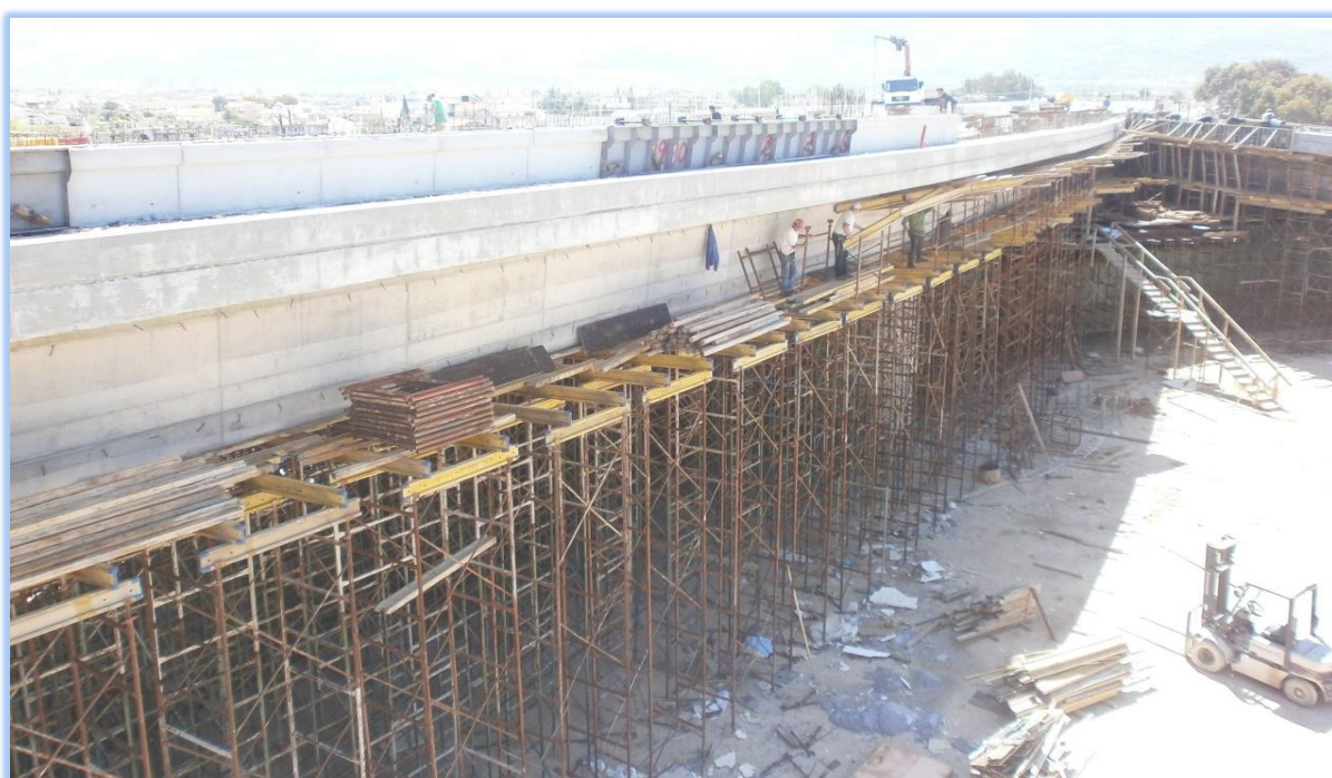
ΦΩΤ. 6.9: Ανατολική όψη της γέφυρας T3, μετά την αφαίρεση τμήματος ξυλοτύπων της ανωδομής και των πεζοδρομίων – διακρίνεται στο βάθος το σημείο ένωσης των 2 γεφυρών T3 και T16 (κλάδου Δ).
