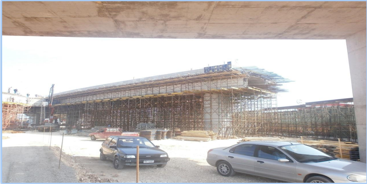
ΦΩΤ. 6.2: Γενική όψη του 1 ου ανοίγματος της γέφυρας T3-διακρίνονται οι αναμονές οπλισμού για την κατασκευή του 2 ου ανοίγματος.
