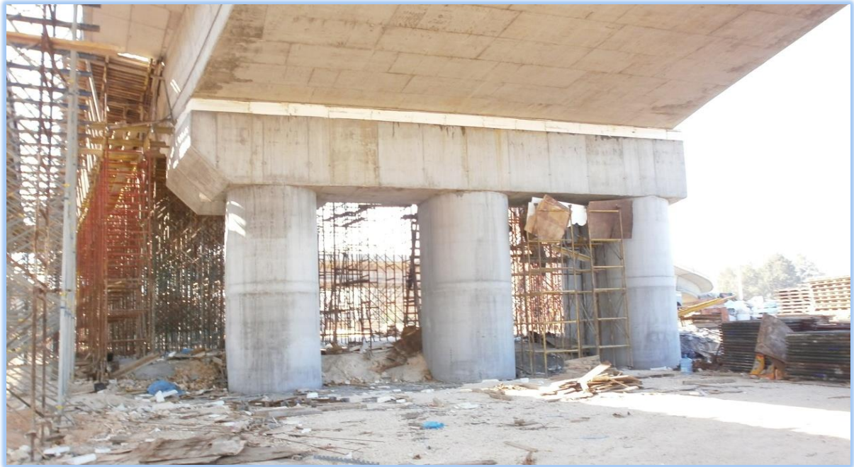
ΦΩΤ. 6.16: Βόρεια όψη του μεσοβάθρου M8 (αποτελείται από τρεις στύλους οι οποίοι έχουν ορθογωνική διατομή με το ένα άκρο ημικυκλικό με εξωτερικές διαστάσεις (3m x 2.5m) κατά τη φάση κατασκευής της γέφυρας T3 (Γέφυρα Δεξιάς Παραγλαυκίας Αρτηρίας) και της γέφυρας T17 (κλάδου Γ).
