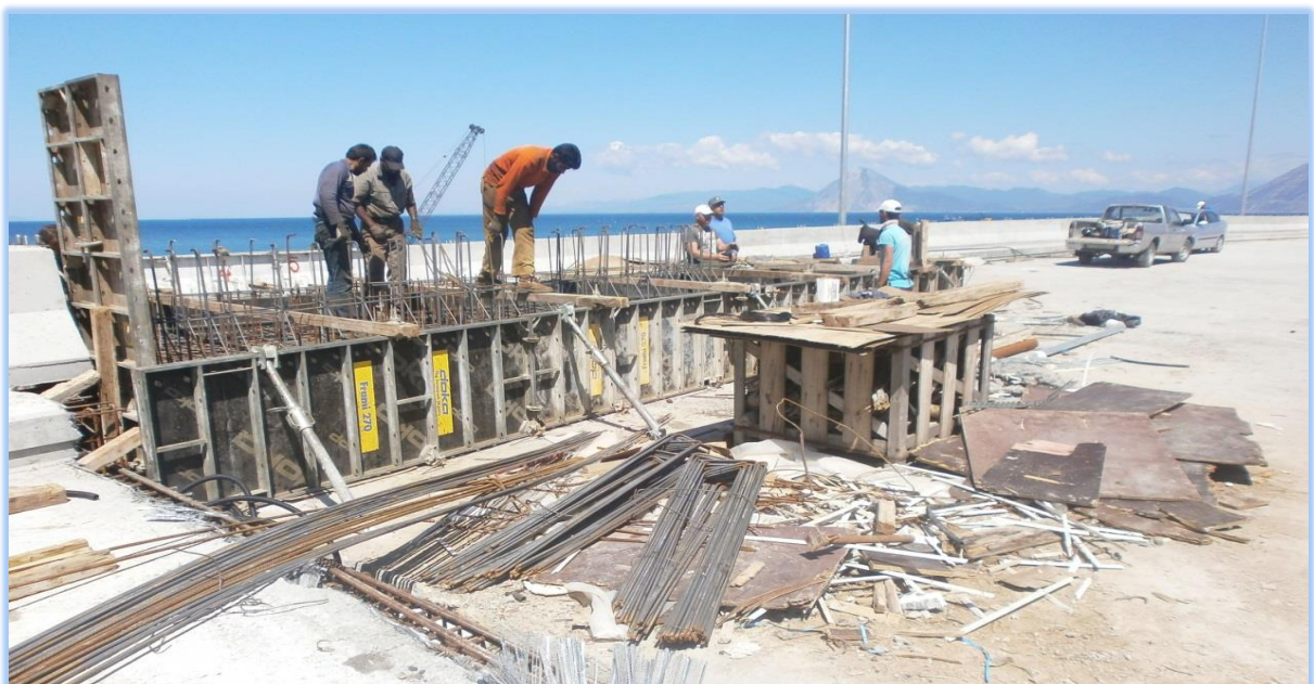
ΦΩΤ. 6.21: Κατασκευή του ενδιάμεσου στηθαίου ασφαλείας, στο κατάστρωμα, της γέφυρας Τ17 (κλάδου Γ), πλησίον της γέφυρας Τ3.
