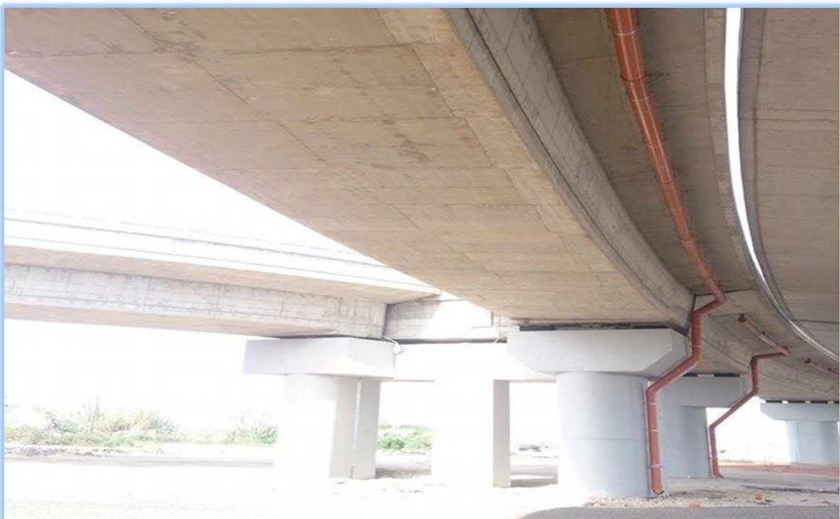
ΦΩΤ. 6.29: Νότια όψη βάθρου M8 και τμήματος του καταστρώματος μετά την ολοκλήρωση του έργου (δεξιά μόλις διακρίνεται η γέφυρα T8 της αριστερής παραγλαύκιας αρτηρίας, ενώ αριστερά φαίνεται τμήμα της γέφυρας T17 του κλάδου Γ).
