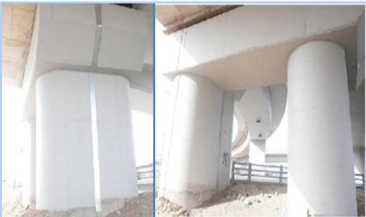
ΦΩΤ. 6.39: Αριστερά φαίνεται η ΝΔ όψη του βάθρου M10, ενώ δεξιά φαίνεται η νότια όψη του βάθρου M10.
