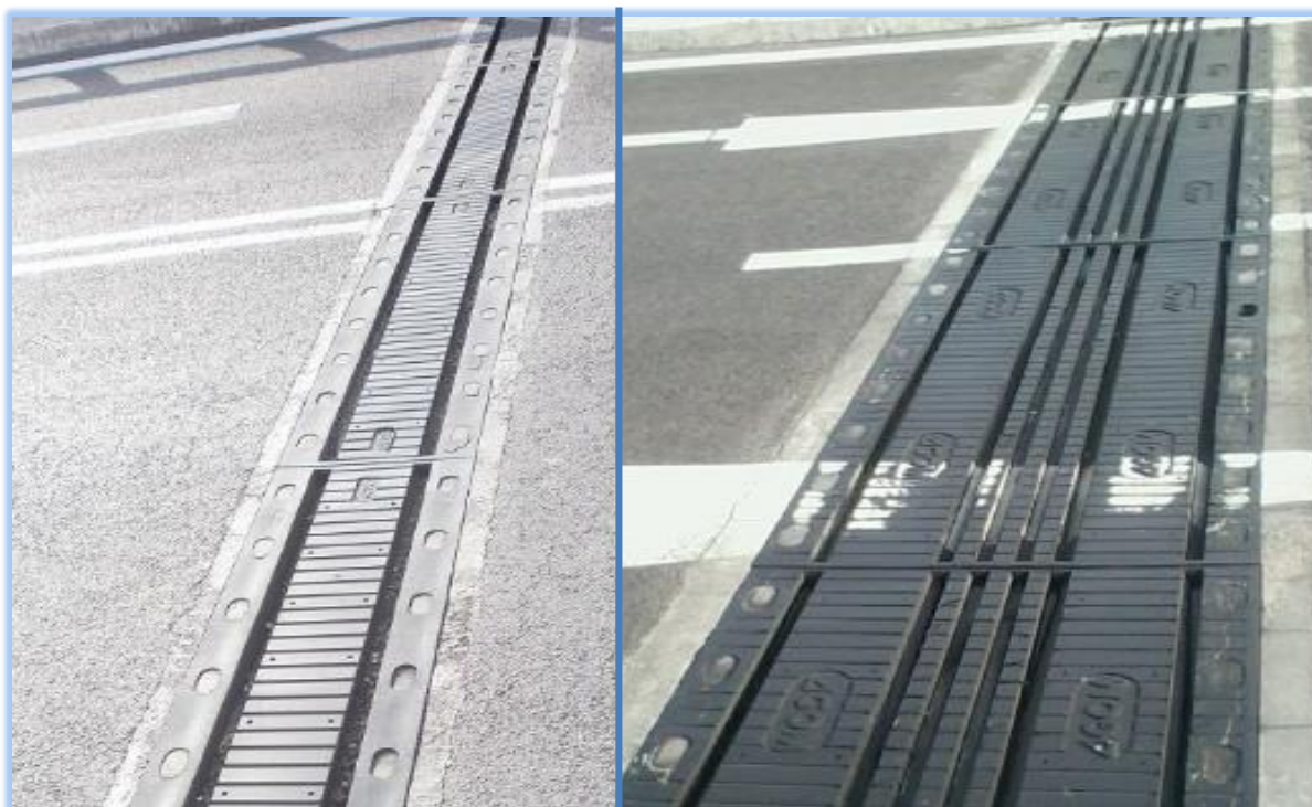
ΦΩΤ. 6.35: Διαχωριστικοί αρμοί μετά την ολοκλήρωση του έργου, αριστερά είναι στη θέση μεταξύ του τεχνικού T2&T3 ενώ στα δεξιά μεταξύ του τεχνικού T3&T4.
