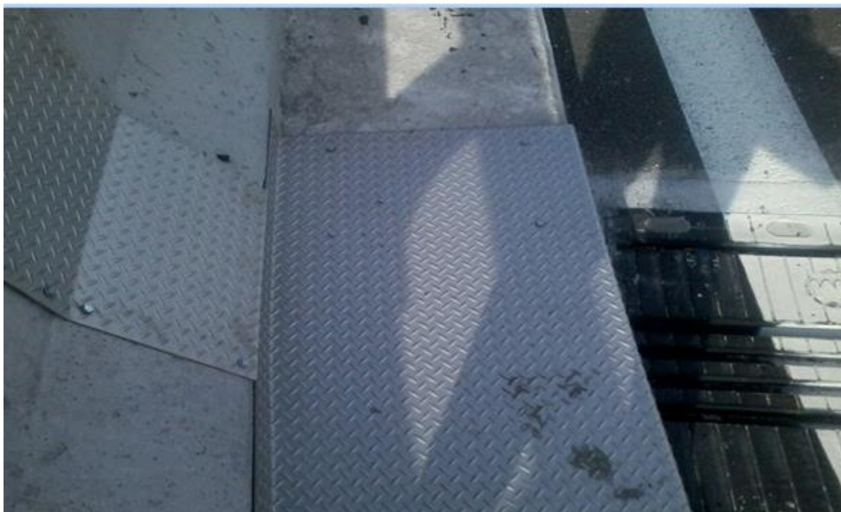
ΦΩΤ. 6.34: Λεπτομέρεια άκρης αρμού επι του πεζοδρομίου της γέφυρας T3.
