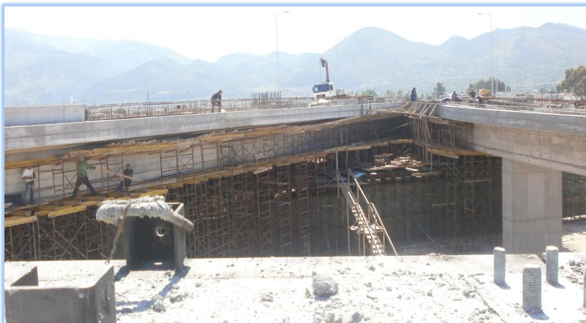
ΦΩΤ. 6.8: Ανατολική όψη της γέφυρας T3 (αριστερά) κατά την κατασκευή της ένωσης της με τη γέφυρα T16 (δεξιά).
