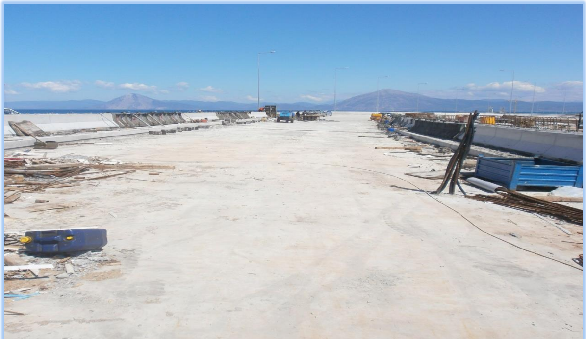
ΦΩΤ. 6.25: Γενική άποψη του καταστρώματος μετά την ολοκλήρωση των εργασιών σκυροδέτησης, από τη γέφυρα T3 προς την T2.
