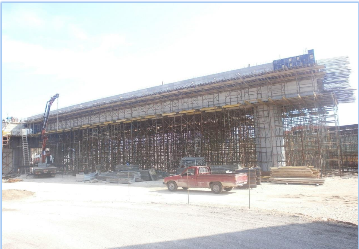
ΦΩΤ. 6.3: Ανατολική όψη του 1 ου ανοίγματος της γέφυρας T3, όπου διακρίνεται το σύστημα ικριωμάτων που χρησιμοποιήθηκαν για την κατασκευή.
