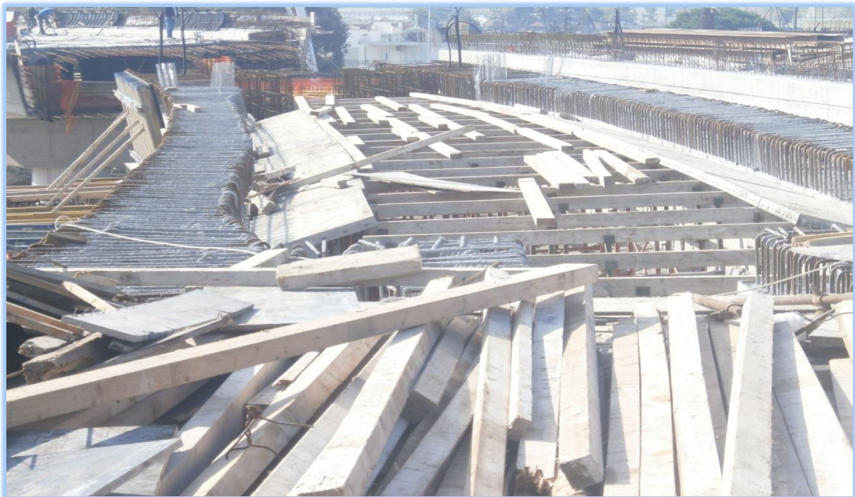
ΦΩΤ. 6.7: Άποψη του καταστρώματος του 1 ου ανοίγματος μετά τη σκυροδέτηση των τοιχωμάτων της κιβωτιοειδούς διατομής.
