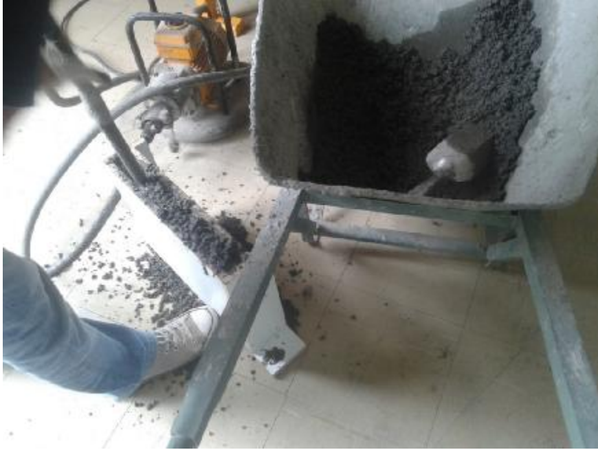
Συμπύκνωση με δονητή στο τέλος της σκυροδέτησης
