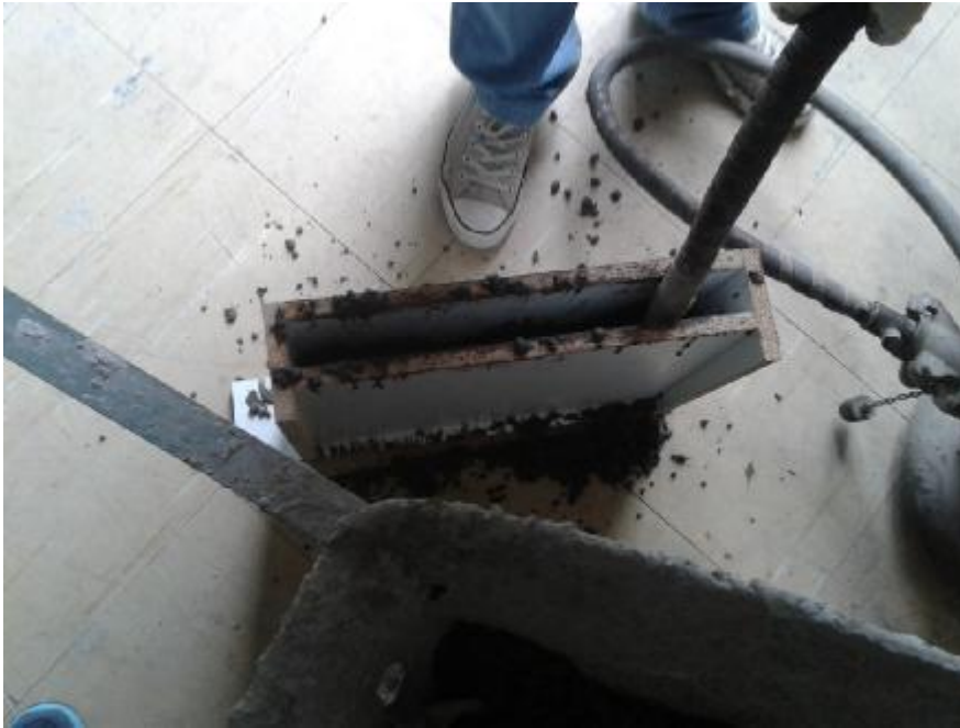
Συμπύκνωση πρώτης στρώσης σκυροδέτησης με δονητή
