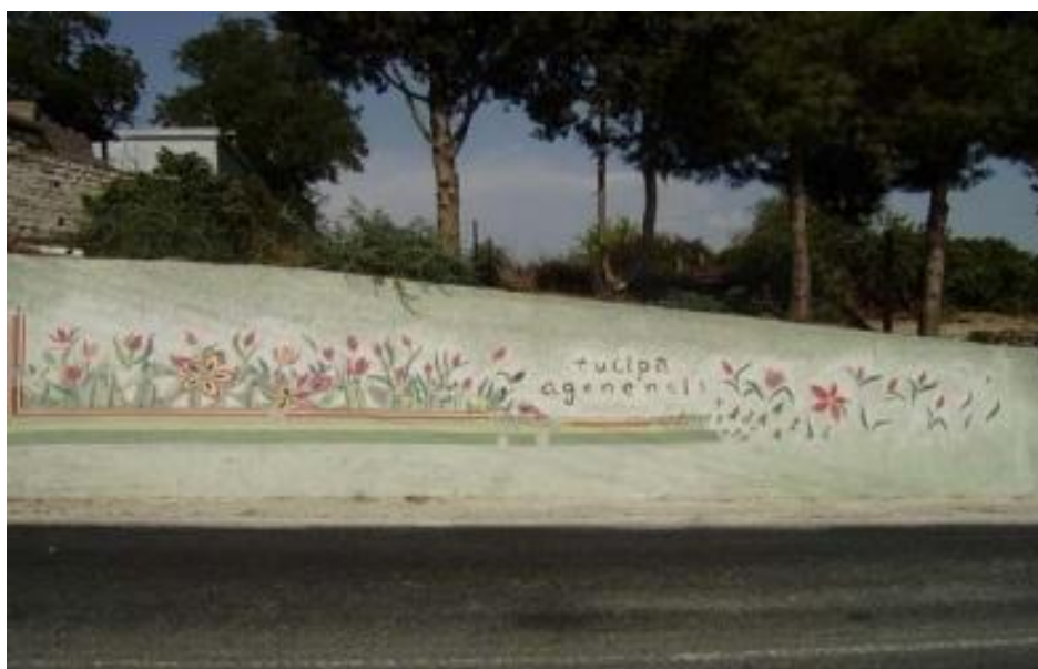
Τοίχος αντιστήριξης από άοπλο σκυρόδεμα
