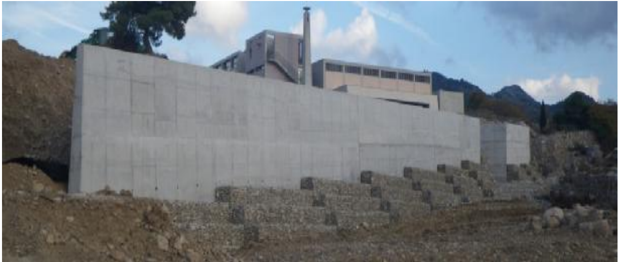
Επιτυχημένη στήριξη πρανών με τοίχο αντιστήριξης
