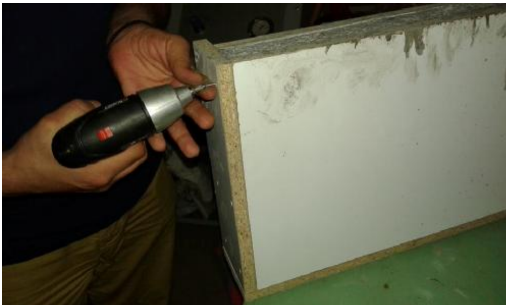
Ξεκαλούπωμα τοίχου (αρχικό στάδιο)
