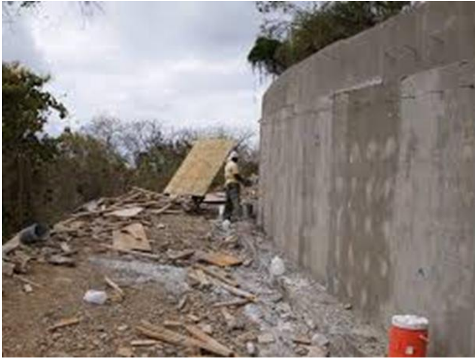
Τοίχος αντιστήριξης από οπλισμένο σκυρόδεμα
