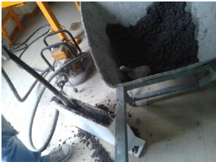
Συμπύκνωση με δονητή στο μέσον της σκυροδέτησης
