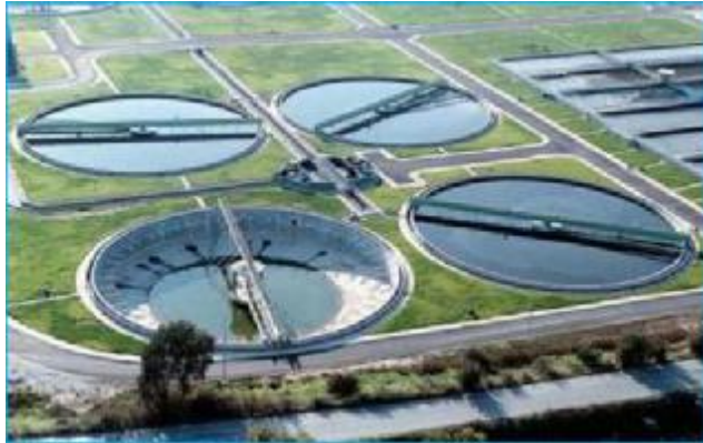
Εικόνα 2- 3 : Αποψη κυκλικών δεξαμενών καθίζησης
