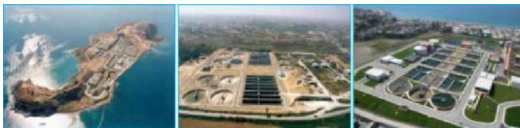
Εικόνα 2- 1 :Εγκαταστάσεις βιολογικού καθαρισμού σε Ψυτάλλεια –Θεσσαλονίκη-Πάτρα
