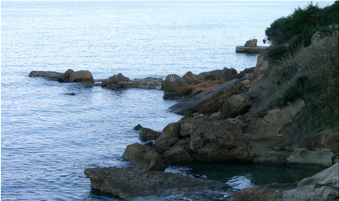
Εικόνα 28. Εξέλιξη Διάβρωσης-Προστασία ακτής με εκτοξευμένο σκυρόδεμα και έργα ογκολίθων (Δυτική Αχαΐα) (Χ. Κατόπουλος, 2010)
