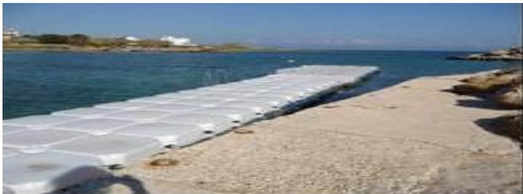
Εικόνα 32. Πλωτή αποβάθρα δίπλα από ντόκο από σκυρόδεμα. (Ξ.Ι. Λοϊζίδου, 2011).
