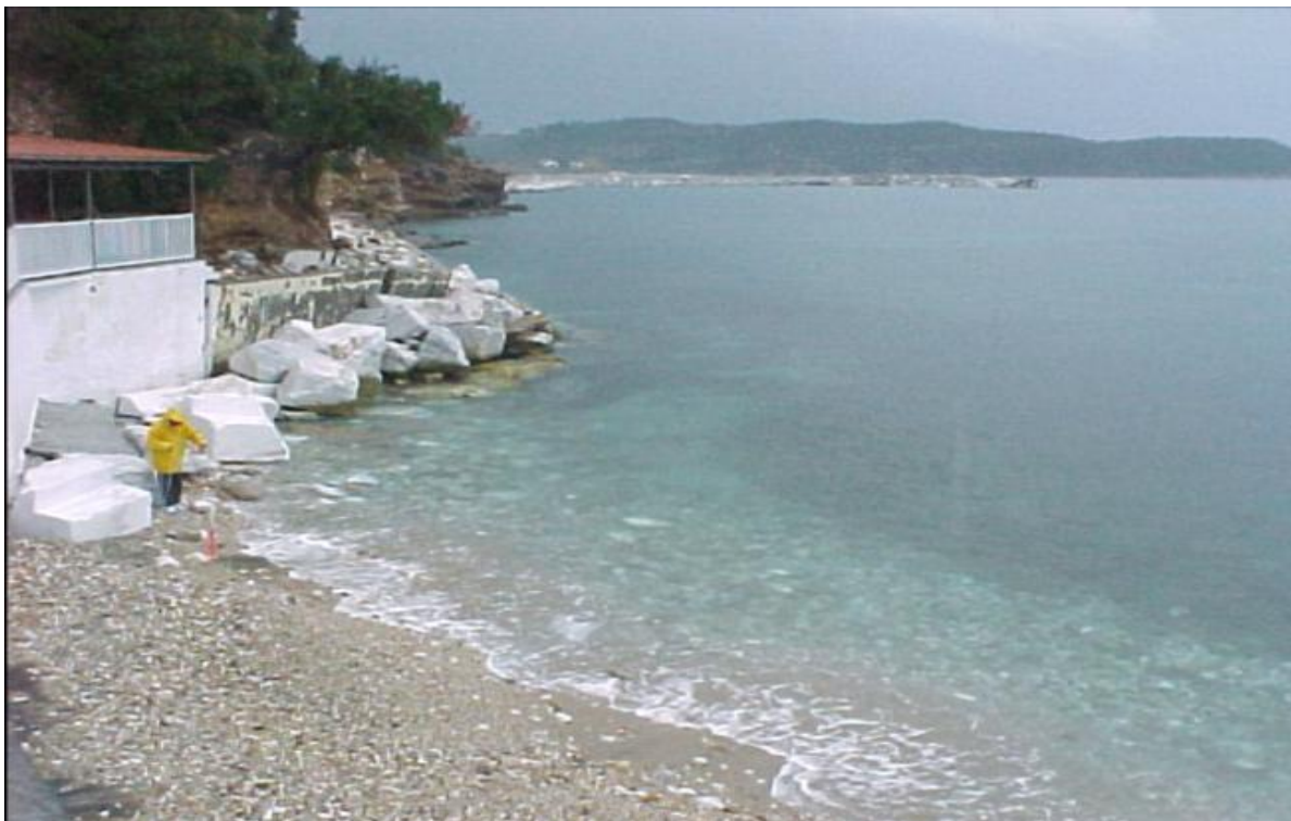
Εικόνα 29. Εξέλιξη Διάβρωσης-Προστασία ακτής Ξενοδοχείου με Τοίχιο Σκυροδέματος και ογκολίθους (Ν. Θάσος). (Χ. Κατόπουλος, 2010)
