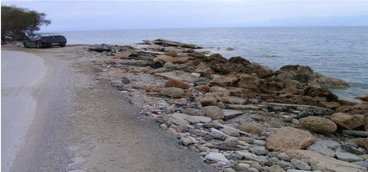
Εικόνα 26. Εξέλιξη Διάβρωσης – Προστασία με Λιθορριπές και Ογκολίθους (Ακτή Βέλου Ν. Κορινθίας). (Χ. Καπόπουλος, 2010)
