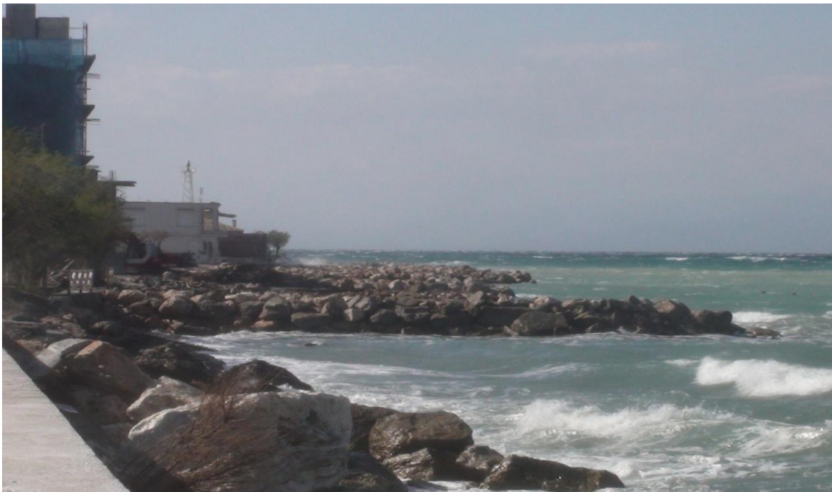
Εικόνα 31. Σκληρά Έργα προστασίας ακτής με Ογκόλιθους (Ακτή Λυκοποριάς Κορινθίας 2008). (Χ. Καπόπουλος, 2010)
