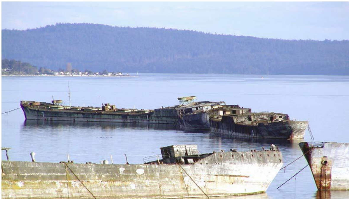
Εικόνα 5. Χρήση πλοίων από σκυρόδεμα ως πλωτοί κυματοθραύστες (Πηγή: www.concreteships.org )
