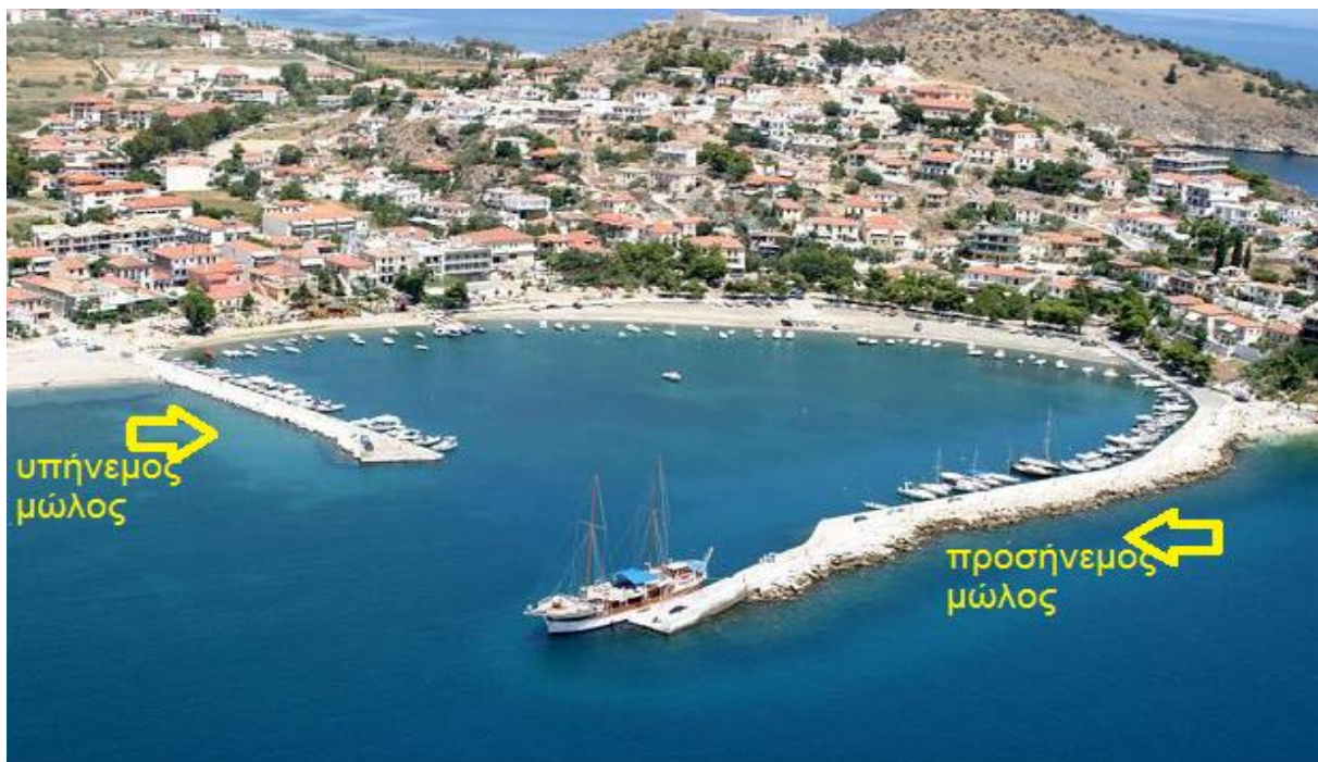
Εικόνα 2. Απεικόνιση προσήνεμου και υπήνεμου μετώπου μώλου στο λιμένα Παραλίου Άστρους. ( www.astrosnews.gr )
