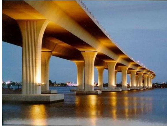
Εικόνα 2.11 – ΚΙΒΩΤΙΟΕΙΔΕΙΣ ΓΕΦΥΡΑ.
