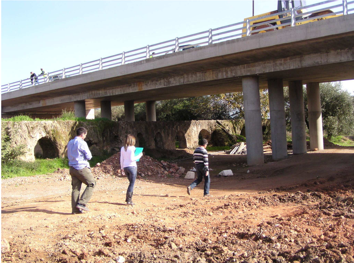
Εικόνα 7.16 - ΑΝΑΤΟΛΙΚΗ ΘΨΗ ΤΟΥ ΕΡΓΟΥ ΜΕΤΑ ΤΗΝ ΟΛΟΚΛΗΡΩΣΗ ΤΗΣ ΚΑΤΑΣΚΕΥΗΣ.
