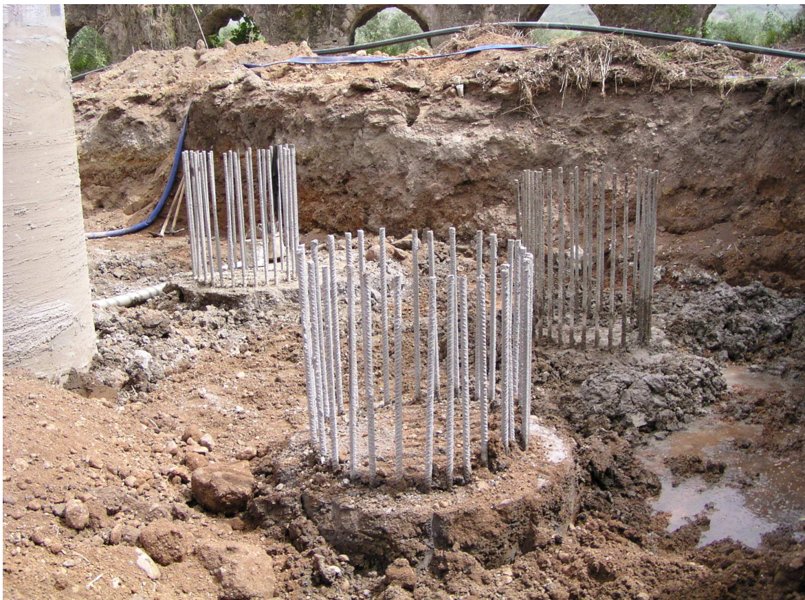
Εικόνα 7.7 – ΛΕΠΤΟΜΕΡΕΙΑ ΤΩΝ ΟΠΛΙΣΜΩΝ (ΑΝΑΜΟΝΩΝ) ΣΤΗΝ ΚΕΦΑΛΗ ΦΡΕΑΤΟΠΑΣΣΑΛΟΥ ΜΕΤΑ ΤΗΝ ΟΛΟΚΛΗΡΩΣΗ ΤΗΣ ΣΚΥΡΟΔΕΤΗΣΗΣ ΤΟΥ.
