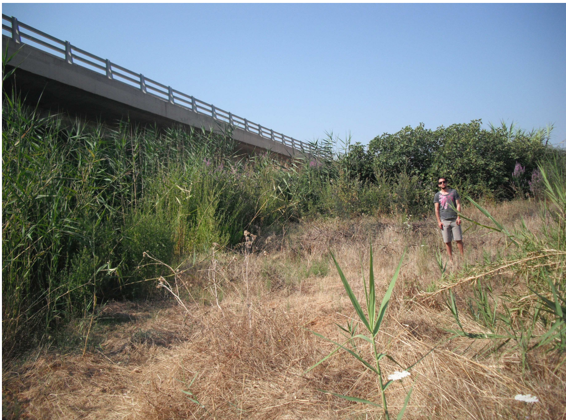
Εικόνα 7.19 – Η ΠΕΡΙΟΧΗ ΤΟΥ ΕΡΓΟΥ ΦΩΤΟΓΡΑΦΗΜΕΝΗ ΑΠΟ ΤΟ ΣΠΟΥΔΑΣΤΗ ΓΑΤΗ ΔΗΜΗΤΡΙΟ ΤΟΝ ΙΟΥΝΙΟ ΤΟΥ 2014 - ΔΙΑΚΡΙΝΕΤΑΙ ΤΜΗΜΑ ΤΟΥ ΚΑΤΑΣΤΡΩΜΑΤΟΣ.
