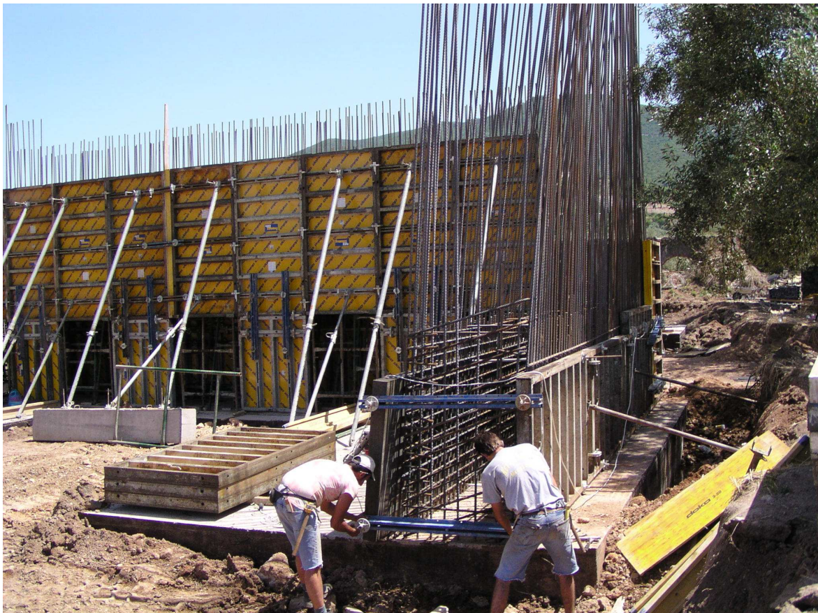
Εικόνα 7.11 – ΕΡΓΑΣΙΕΣ ΤΟΠΟΘΕΤΗΣΗΣ ΟΠΛΙΣΜΟΥ ΣΕ ΤΟΙΧΟ ΑΝΤΕΠΙΣΤΡΟΦΗΣ ΑΚΡΟΒΑΘΡΟΥ ΤΗΣ ΓΕΦΥΡΑΣ.
