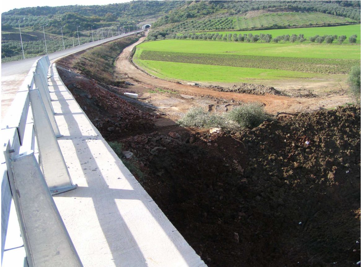
Εικόνα 7.18 – ΑΠΟΨΗ ΤΩΝ ΕΥΡΥΤΕΡΩΝ ΕΡΓΩΝ ΥΠΟΔΟΜΗΣ ΣΤΗΝ ΠΕΡΙΟΧΗ ΤΗΣ ΓΕΦΥΡΑΣ ΦΩΤΟΓΡΑΦΗΜΕΝΩΝ ΑΠΟ ΤΟ ΚΑΤΑΣΤΡΩΜΑ ΤΗΣ ΜΕΤΑ ΤΗΝ ΟΛΟΚΛΗΡΩΣΗ ΤΩΝ ΕΡΓΑΣΙΩΝ.
