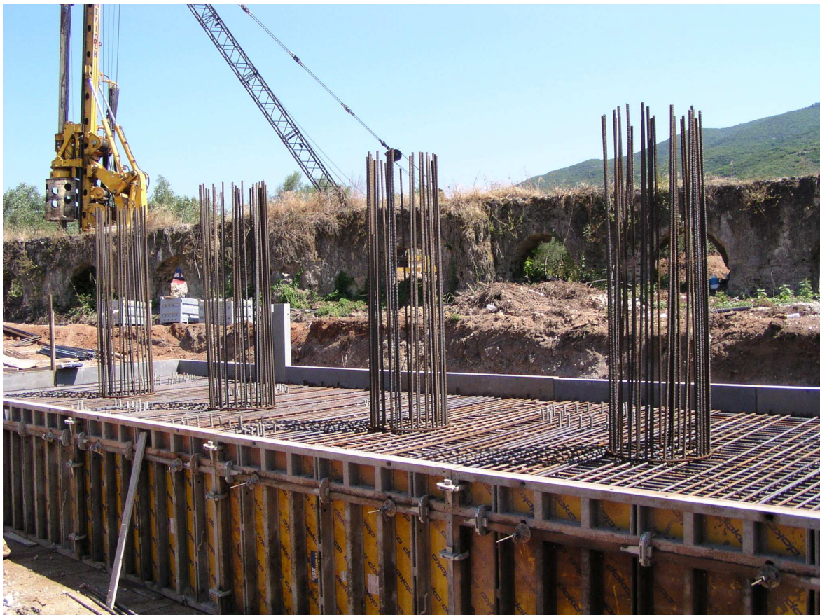
Εικόνα 7.9 – ΑΠΟΨΗ ΤΟΥ ΜΕΣΟΒΑΘΡΟΥ ΠΡΙΝ ΤΗ ΣΚΥΡΟΔΕΤΗΣΗ ΤΟΥ ΚΕΦΑΛΟΔΕΣΜΟΥ ΣΤΗ ΒΑΣΗ ΤΟΥ.
