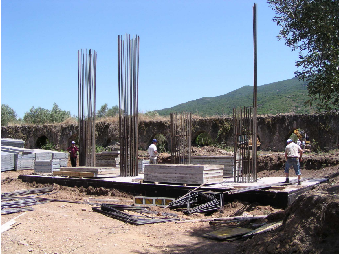
Εικόνα 7.10 – ΤΟΠΟΘΕΤΗΣΗ ΤΩΝ ΟΠΛΙΣΜΩΝ ΤΩΝ ΣΤΥΛΩΝ ΤΟΥ ΜΕΣΟΒΑΘΡΟΥ ΜΕΤΑ ΤΗΝ ΟΛΟΚΛΗΡΩΣΗ ΤΗΣ ΚΑΤΑΣΚΕΥΗΣ ΤΗΣ ΘΕΜΕΛΙΩΣΗΣ ΤΟΥ.
