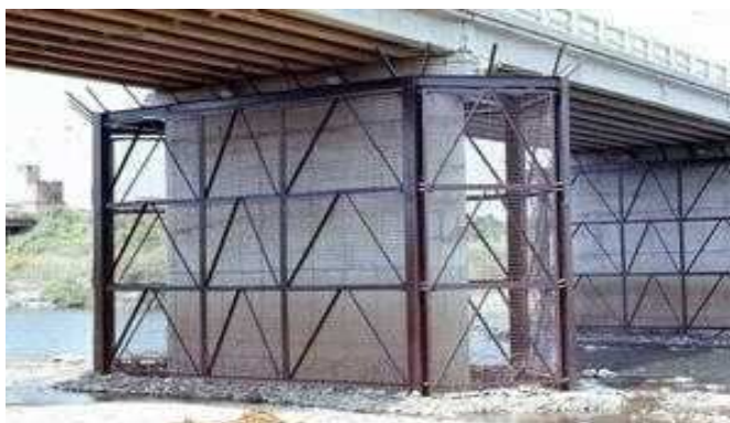
Εικόνα 2.4 – ΜΕΣΟΒΑΘΡΑ ΜΟΡΦΗΣ ΤΟΙΧΩΝ.
