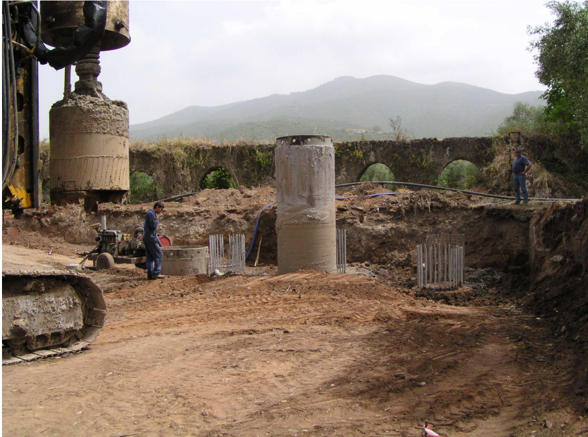
Εικόνα 7.6 – ΕΡΓΑΣΙΕΣ ΚΑΤΑΣΚΕΥΗΣ ΤΩΝ ΦΡΕΑΤΟΠΑΣΣΑΛΩΝ.
