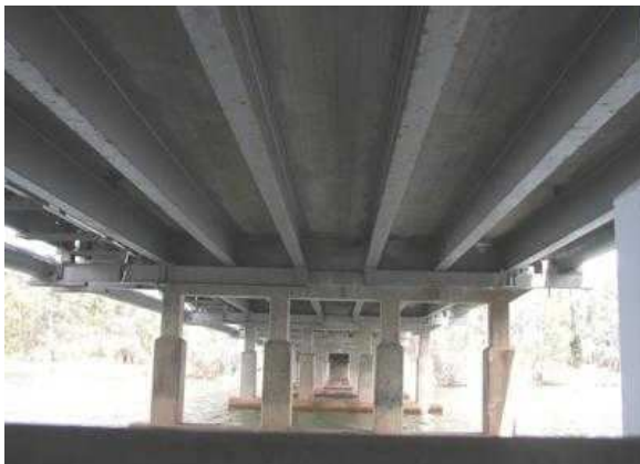
Εικόνα 2.10 – ΓΕΦΥΡΑ ΜΕ ΠΛΑΚΑ ΕΔΡΑΖΟΜΕΝΗ ΣΕ ΔΟΚΟΥΣ.
