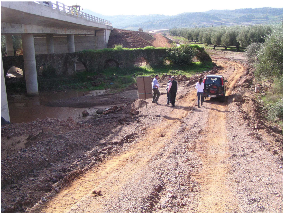
Εικόνα 7.17 - ΑΝΑΤΟΛΙΚΗ ΘΨΗ ΤΟΥ ΕΡΓΟΥ ΜΕΤΑ ΤΗΝ ΟΛΟΚΛΗΡΩΣΗ ΤΗΣ ΚΑΤΑΣΚΕΥΗΣ - ΔΙΑΚΡΙΝΕΤΑΙ Η ΔΙΑΤΗΡΟΥΜΕΝΗ ΡΩΜΑΪΚΗ ΓΕΦΥΡΑ.
