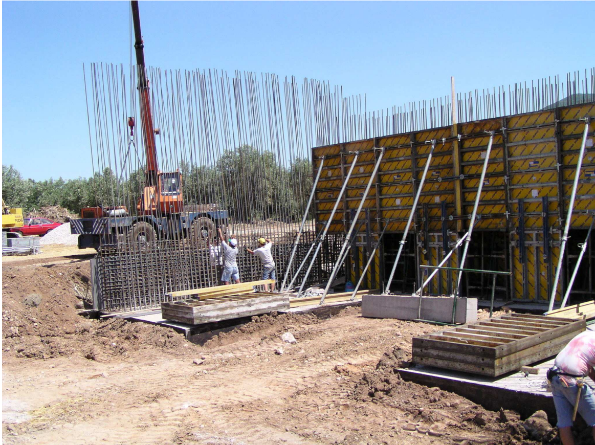
Εικόνα 7.14 – ΤΟΠΟΘΕΤΗΣΗ ΟΠΛΙΣΜΟΥ ΣΕ ΤΟΙΧΟ ΑΝΤΕΠΙΣΤΡΟΦΗΣ ΑΚΡΟΒΑΘΡΟΥ.
