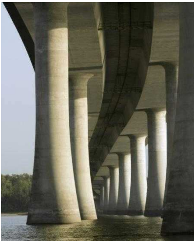
Εικόνα 2.5 – ΜΕΣΟΒΑΘΡΑ ΜΟΡΦΗΣ ΚΟΛΩΝΑΣ.
