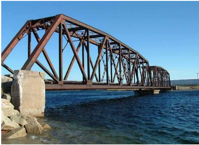
Εικόνα 2.15 – ΓΕΦΥΡΑ ΜΟΡΦΗΣ ΔΙΚΤΥΩΜΑΤΟΣ.
