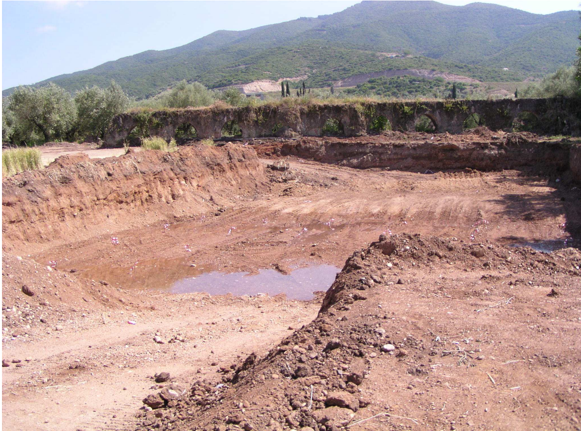
Εικόνα 7.2 – ΤΟ ΕΡΓΟΤΑΞΙΟ ΚΑΤΑ ΤΗΝ ΑΡΧΙΚΗ ΦΑΣΗ ΕΚΣΚΑΦΩΝ ΚΑΙ ΠΡΟΕΤΟΙΜΑΣΙΕΣ ΤΟΥ ΕΔΑΦΟΥΣ ΓΙΑ ΤΗΝ ΚΑΤΑΣΚΕΥΗ ΤΩΝ ΘΕΜΕΛΙΩΣΕΩΝ ΤΩΝ ΒΑΘΡΩΝ ΤΗΣ ΓΕΦΥΡΑΣ.
