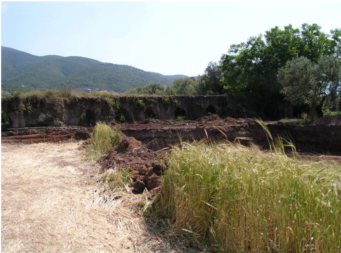
Εικόνα 7.3 – ΑΠΟΨΗ ΤΗΣ ΡΩΜΑΪΚΗΣ ΔΙΑΤΗΡΗΤΕΑΣ ΓΕΦΥΡΑΣ ΣΤΟ ΧΩΡΟ ΤΟΥ ΕΡΓΟΤΑΞΙΟΥ ΠΡΙΝ ΤΗΝ ΕΝΑΡΞΗ ΤΩΝ ΕΡΓΑΣΙΩΝ ΑΝΕΓΕΡΣΗΣ ΤΗΣ ΝΕΑΣ ΓΕΦΥΡΑΣ.
