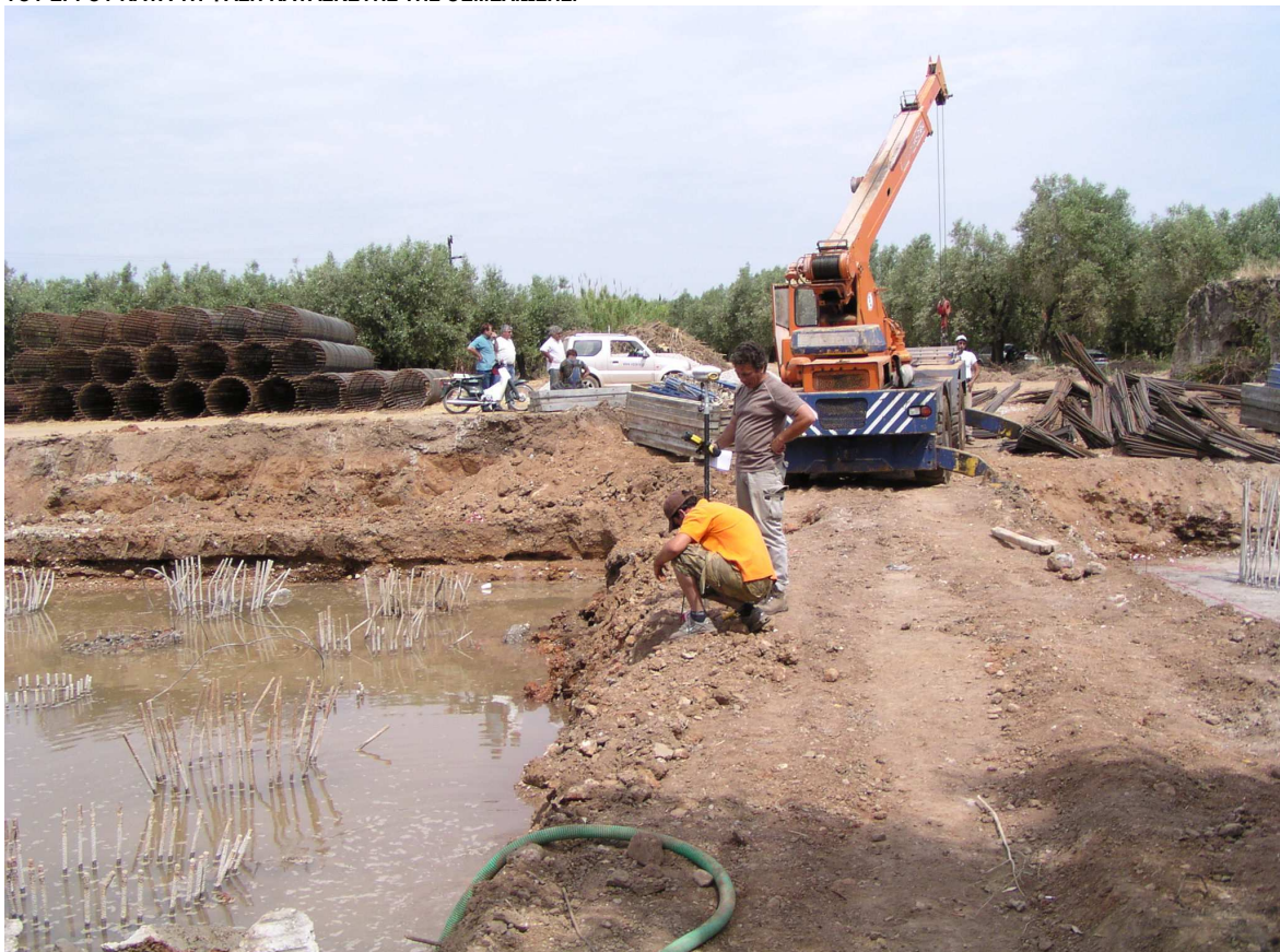
Εικόνα 7.5 – ΤΜΗΜΑ ΠΛΗΜΜΥΡΙΣΜΕΝΟΥ ΚΕΦΑΛΟΔΕΣΜΟΥ ΚΑΤΑ ΤΗ ΦΑΣΗ ΚΑΤΑΣΚΕΥΗΣ ΤΟΥ ΕΡΓΟΥ – ΔΙΑΚΡΙΝΟΝΤΑΙ ΟΙ ΟΠΛΙΣΜΟΙ ΠΟΥ ΣΥΓΚΕΝΤΡΩΝΟΝΤΑΙ ΣΤΟ ΕΡΓΟΤΑΞΙΟ ΓΙΑ ΤΗΝ ΕΠΟΜΕΝΗ ΦΑΣΗ.
