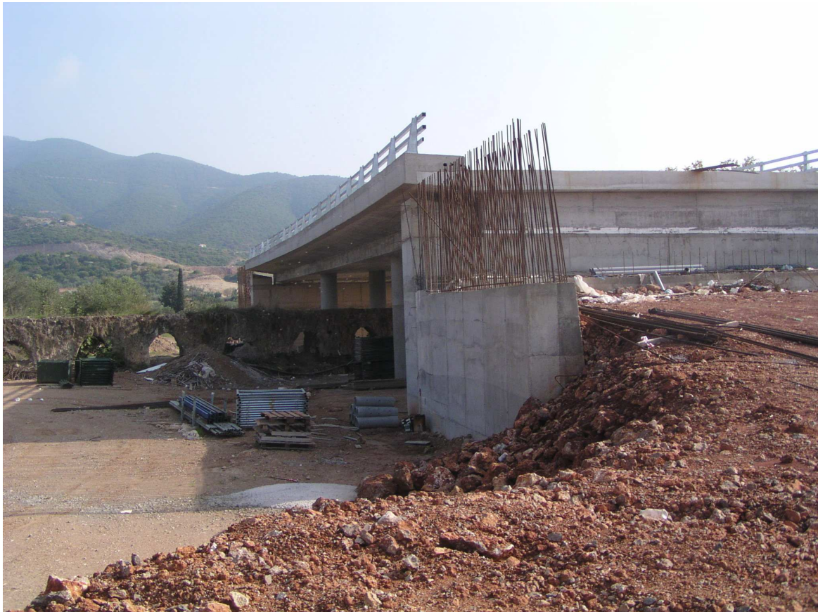
Εικόνα 7.15 – ΤΟΙΧΟΣ ΑΝΤΕΠΙΣΤΡΟΦΗΣ ΜΕΤΑ ΤΗ ΣΚΥΡΟΔΕΤΗΣΗ ΤΟΥ & ΤΗ ΜΕΡΙΚΗ ΚΑΤΑΣΚΕΥΗ ΤΟΥ ΕΠΙΧΩΜΑΤΟΣ.
