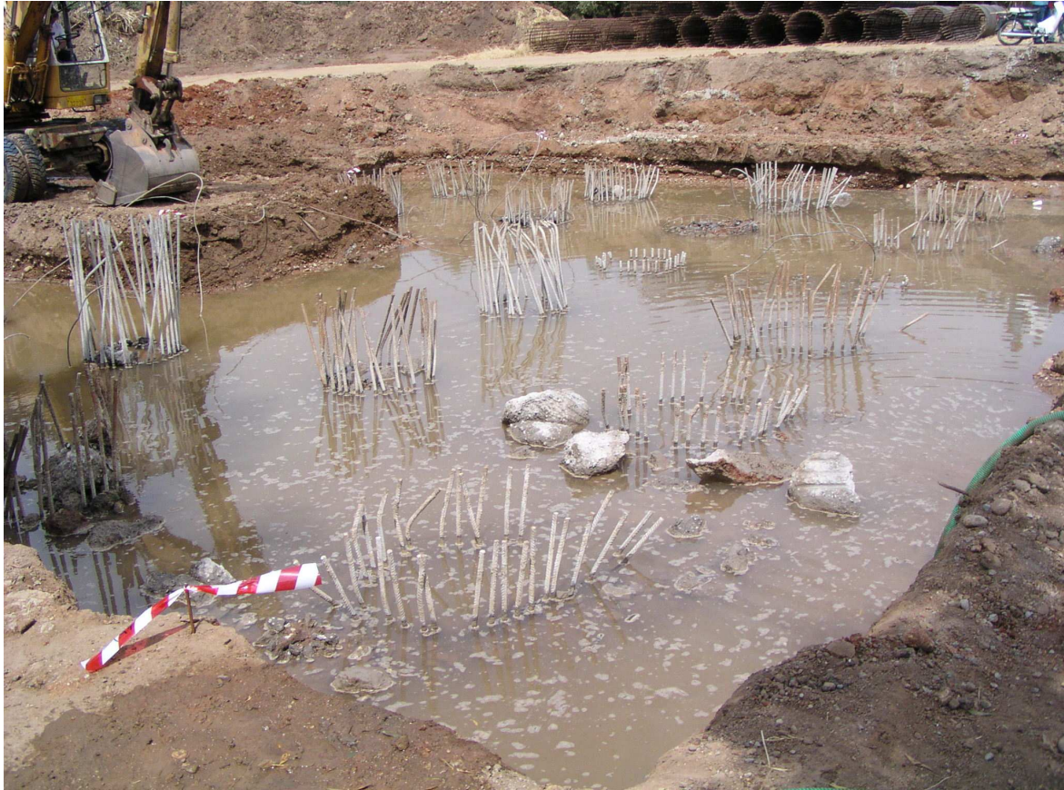
Εικόνα 7.4 – ΣΥΓΚΕΝΤΡΩΣΗ ΝΕΡΟΥ ΣΤΗ ΘΕΣΗ ΚΑΤΑΣΚΕΥΗΣ ΤΟΥ ΚΕΦΑΛΟΔΕΣΜΟΥ ΛΟΓΩ ΕΝΤΟΝΗΣ ΒΡΟΧΟΠΤΩΣΗΣ ΣΤΗΝ ΠΕΡΙΟΧΗ ΤΟΥ ΕΡΓΟΥ ΚΑΤΑ ΤΗ ΦΑΣΗ ΚΑΤΑΣΚΕΥΗΣ ΤΗΣ ΘΕΜΕΛΙΩΣΗΣ.
