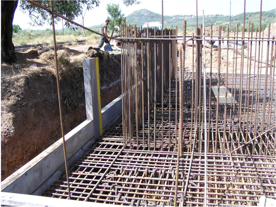
Εικόνα 7.12 – ΛΕΠΤΟΜΕΡΕΙΑ ΤΗΣ ΟΠΛΙΣΗΣ ΣΤΗΝ ΚΕΦΑΛΗ ΤΟΥ ΑΚΡΟΒΑΘΡΟΥ.
