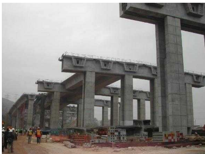
Εικόνα 2.6 – ΜΕΣΟΒΑΘΡΑ ΜΟΡΦΗΣ ΠΛΑΙΣΙΟΥ.
