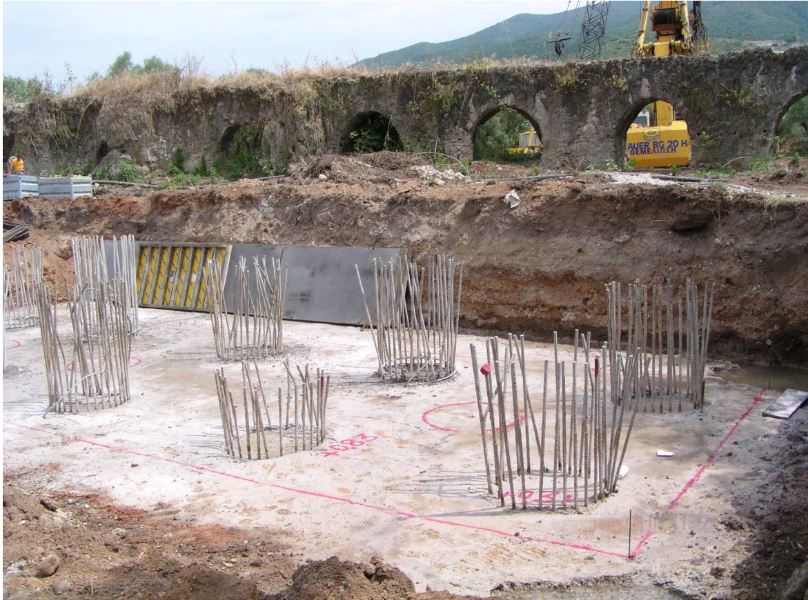
Εικόνα 7.8 – ΘΕΜΕΛΙΩΣΗ ΜΕΣΟΒΑΘΡΟΥ ΠΡΙΝ ΤΗ ΣΚΥΡΟΔΕΤΗΣΗ ΤΟΥ ΚΕΦΑΛΟΔΕΣΜΟΥ – ΔΙΑΚΡΙΝΕΤΑΙ Η ΣΗΜΑΝΣΗ ΤΗΣ ΧΑΡΑΞΗΣ ΣΤΗΝ ΕΞΥΓΙΑΝΤΙΚΗ ΣΤΡΩΣΗ ΣΚΥΡΟΔΕΜΑΤΟΣ.
