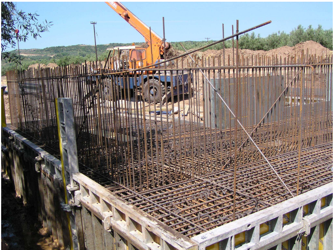
Εικόνα 7.13 – ΑΠΟΨΗ ΤΟΥ ΑΚΡΟΒΑΘΡΟΥ ΠΡΙΝ ΤΗ ΣΚΥΡΟΔΕΤΣΗ ΤΟΥ.
