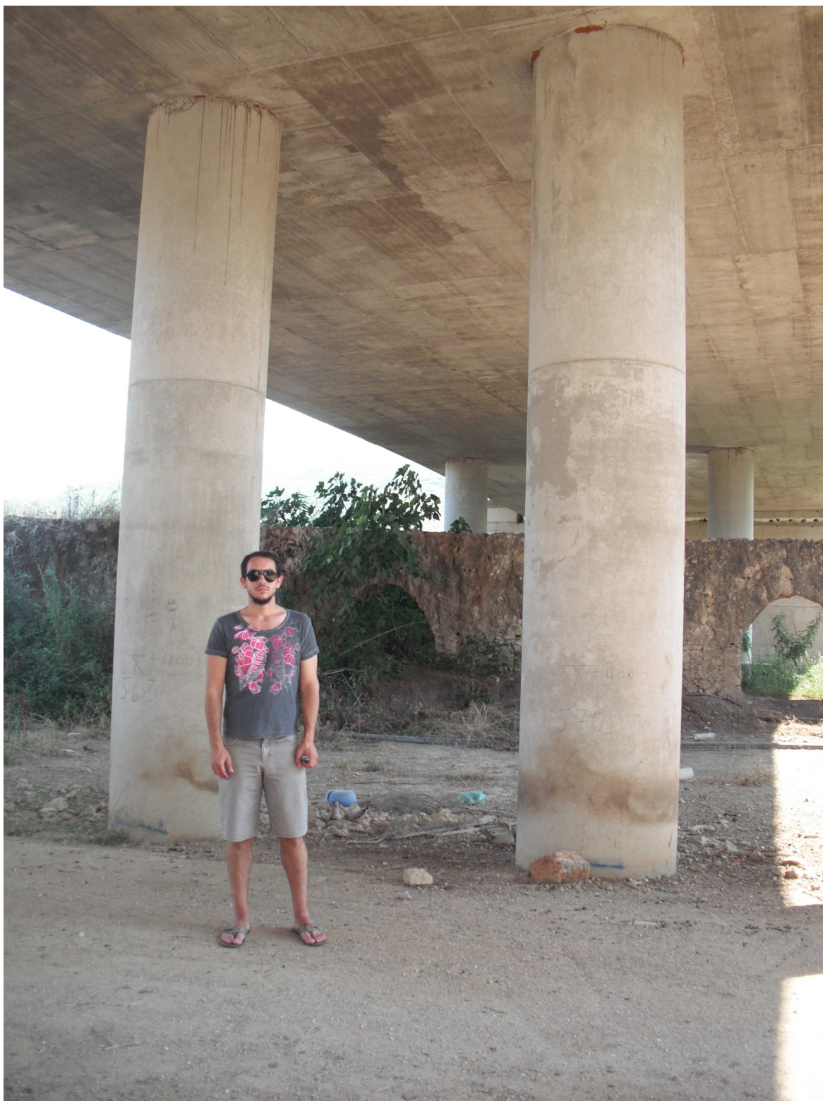
Εικόνα 7.21 – Ο ΣΠΟΥΔΑΣΤΗΣ ΓΑΤΗΣ ΔΗΜΗΤΡΙΟΣ ΚΑΤΑ ΤΗ ΦΩΤΟΓΡΑΦΙΣΗ ΜΕΣΟΒΑΘΡΟΥ ΤΗΣ ΓΕΦΥΡΑΣ ΜΕΤΑ ΤΗΝ ΟΛΟΚΛΗΡΩΣΗ ΤΗΣ ΚΑΤΑΣΚΕΥΗΣ.
