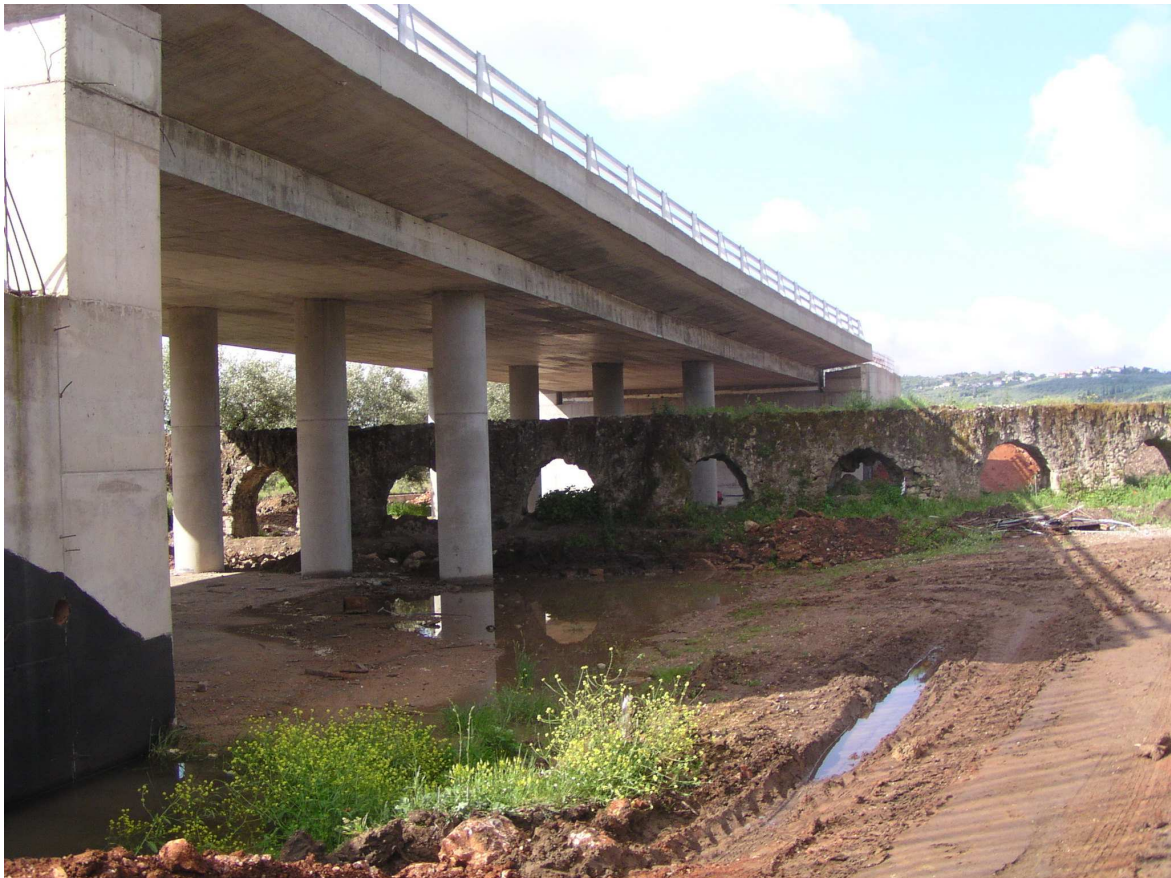
Εικόνα 7.1 – ΔΥΤΙΚΗ ΟΨΗ ΤΗΣ ΓΕΦΥΡΑΣ ΜΕΤΑ ΤΗΝ ΟΛΟΚΛΗΡΩΣΗ ΤΗΣ ΚΑΤΑΣΚΕΥΗΣ.
