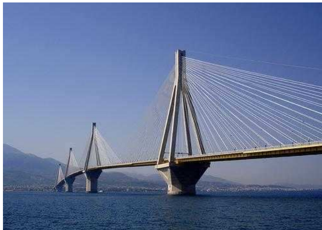
Εικόνα 2.7 – ΜΕΣΟΒΑΘΡΑ ΜΟΡΦΗΣ ΠΥΛΩΝ.
