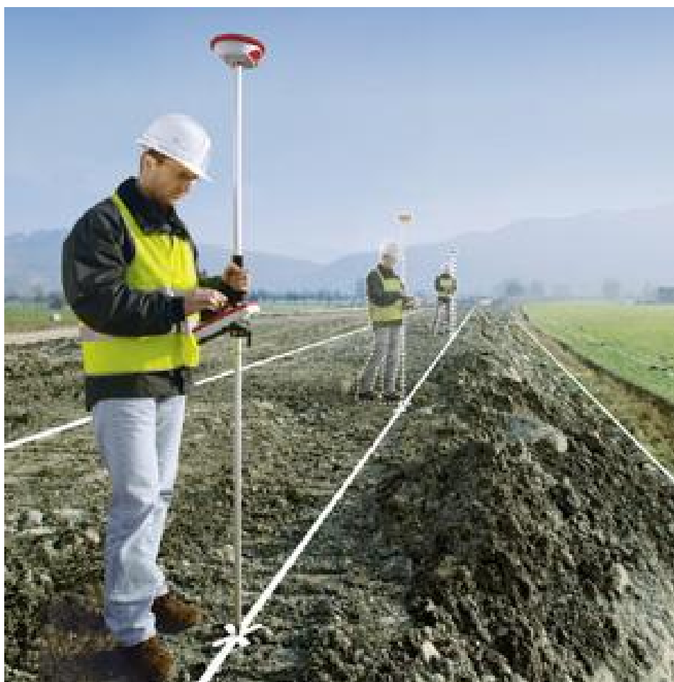
Εικόνα 49. Χάραξη με gps
