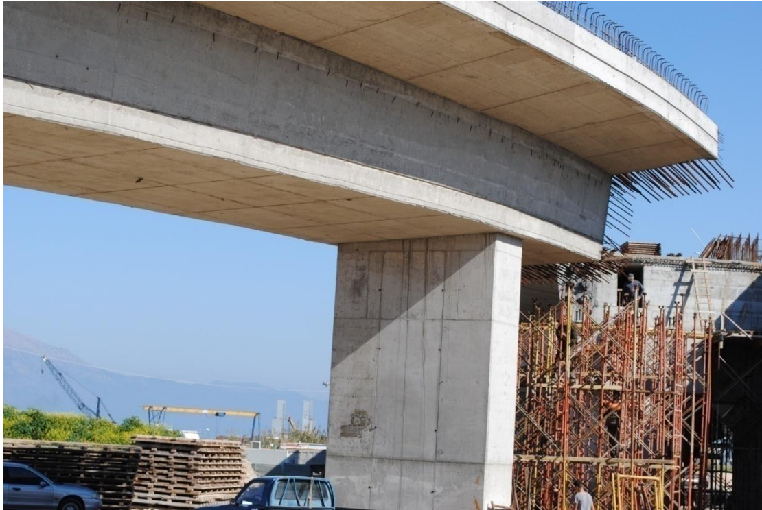
Φωτ. 6.13: ΒΔ όψη του μεσόβαθρου Μ4 ΚΛ.Γ της παρούσας γέφυρας Τ17. (Τοποθέτηση ξυλοτύπων σκυροδέτησης μεταξύ μεσόβαθρων Μ4 ΚΛ.Γ και Μ5 ΚΛ.Γ).
