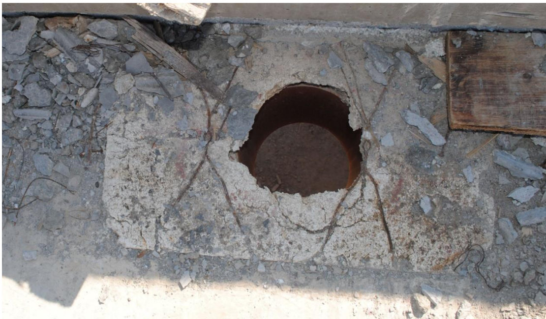
Φωτ. 6.50: Λεπτομέρεια αγωγού υδροδότησης όμβριων υδάτων.
