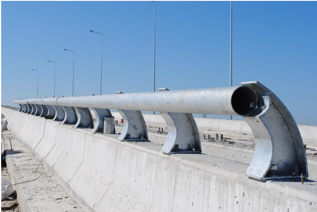
Φωτ. 6.49: Προστατευτικά κιγκλιδώματα και κράσπεδο.
