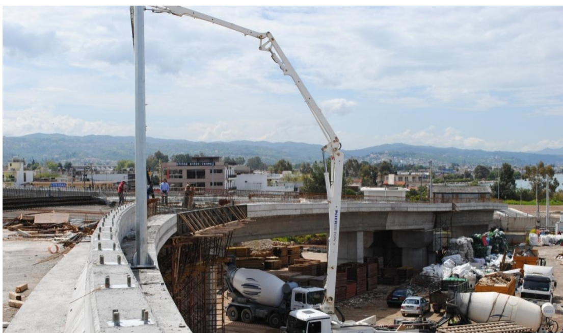
Φωτ. 6.38: ΝΑ όψη της παρούσας γέφυρας T17. Διακρίνεται αριστερά τμήμα του καταστρώματος της γέφυρας T2, η παρούσα γέφυρα T17 με τα μεσόβαθρα M5.ΚΛ.Γ και M4.ΚΛ.Γ όπισθεν των ξυλοτύπων και στη συνέχεια τα μεσόβαθρα M3.ΚΛ.Γ και M2.ΚΛ.Γ. μετά τον αρμό ακολουθεί η γέφυρα T15.
