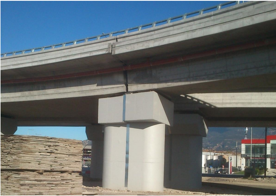
Φωτ. 6.7: Ολοκληρωμένο τμήμα αρμού μεταξύ γέφυρας T2 (αριστερά) και μεσόβαθρου M5 ΚΛ.Γ της παρούσας γέφυρας T17 (δεξιά).
