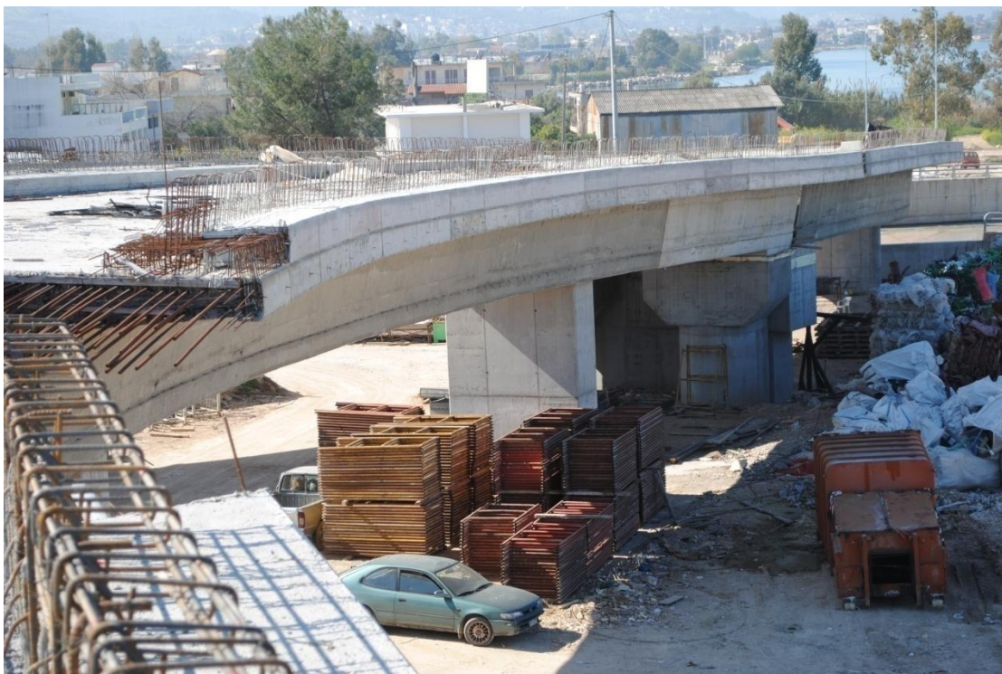
Φωτ. 6.32: Σκυροδετημένο τμήμα της παρούσας γέφυρας T17. (Διακρίνονται από αριστερά τα μεσόβαθρα M3.ΚΛ.Γ και M2.ΚΛ.Γ αυτής και ακολουθεί μετά τον αρμό η γέφυρα T15).
