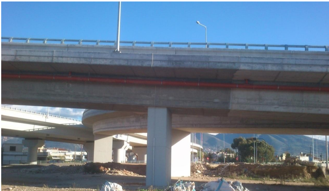
Φωτ. 6.16: ΝΔ όψη του ολοκληρωμένου τμήματος του μεσόβαθρου Μ3.ΚΛ.Γ της παρούσας γέφυρας Τ17.
