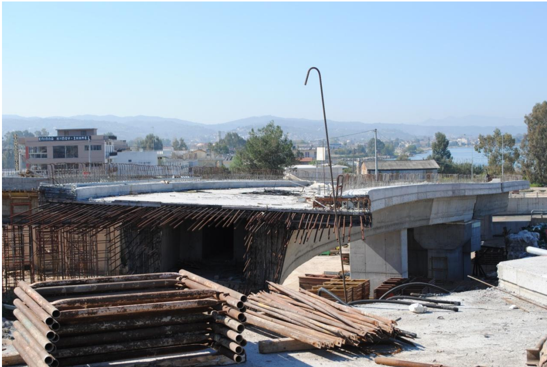
Φωτ. 6.33: Σκυροδετημένο τμήμα της παρούσας γέφυρας T17, (σε φάση κατασκευής το τμήμα άνωθεν του μεσόβαθρου M4.ΚΛ.Γ).
