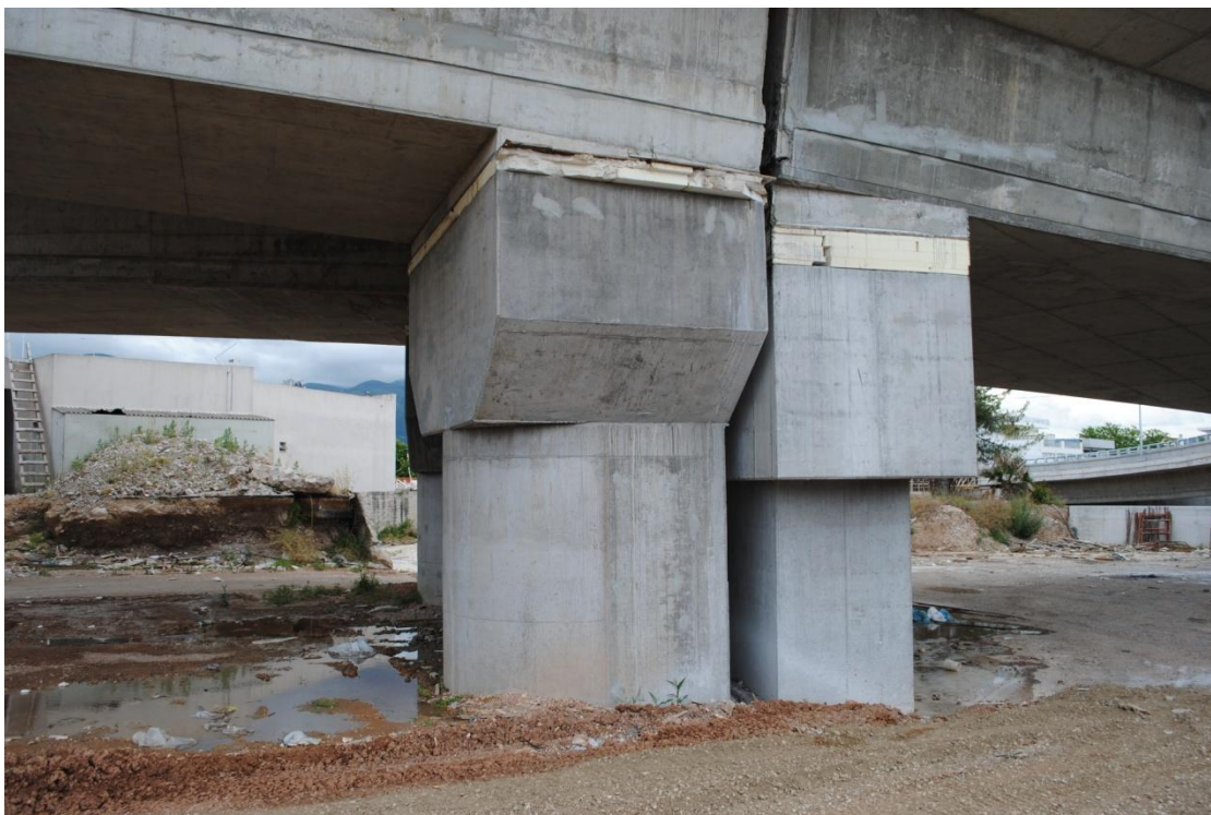
Φωτ. 6.26: Αρμός μεταξύ γέφυρας Τ17 (αριστερά) και Τ15 (δεξιά). (Διακρίνεται και το ημικυκλικό άκρο του Μ2.ΚΛ.Γ μεσόβαθρου με εξωτερικές διαστάσεις 2,5m x 2,5m).
