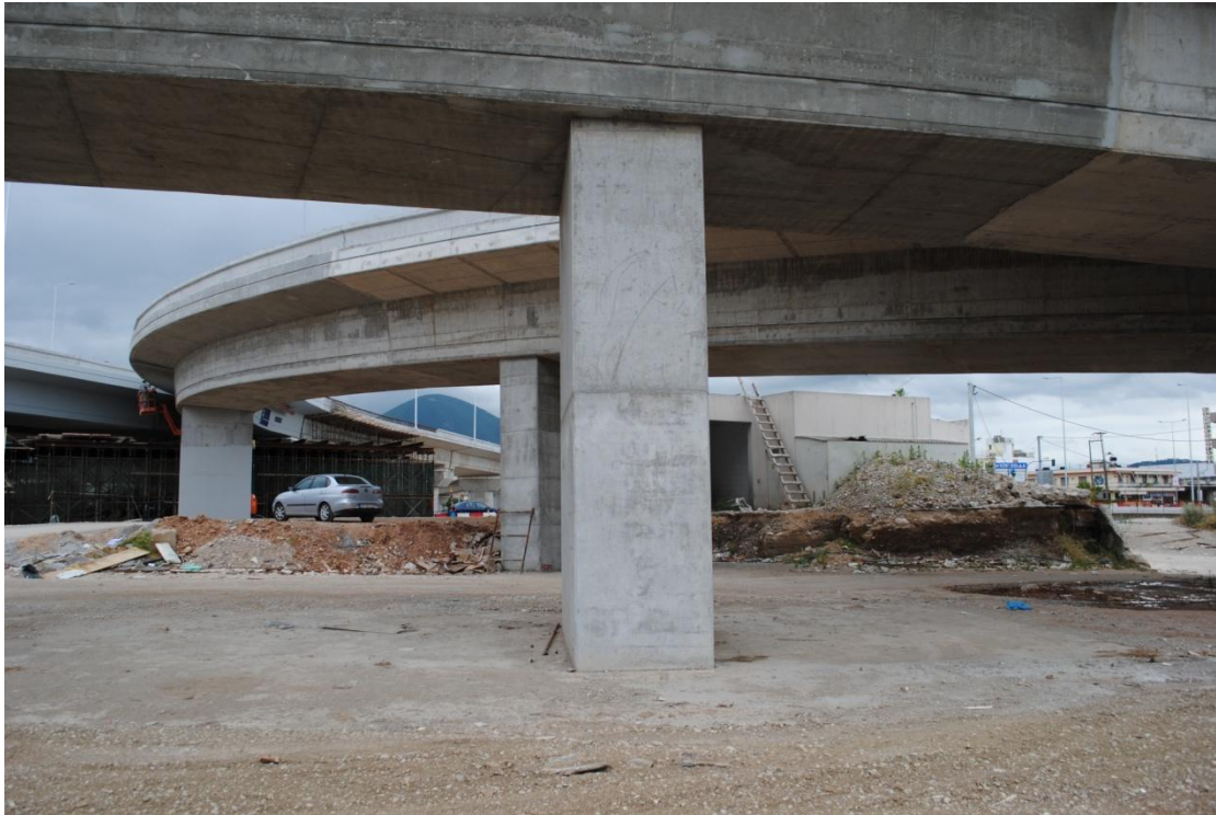
Φωτ. 6.15: ΝΔ όψη του μεσόβαθρου Μ3.ΚΛ.Γ της παρούσας γέφυρας Τ17. (Σε δεύτερο πλάνο η γέφυρα Τ16).
