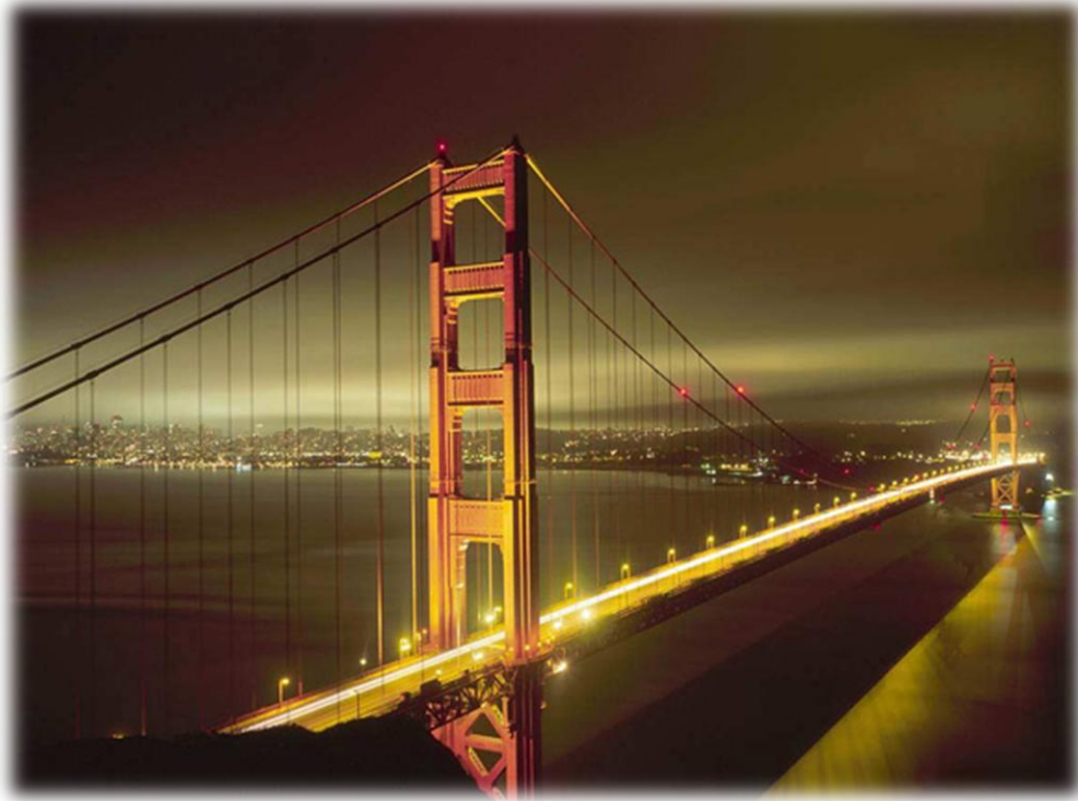
Σχήμα 1.2 - Γέφυρα της Χρυσής Πύλης, Σαν Φρανσίσκο.
