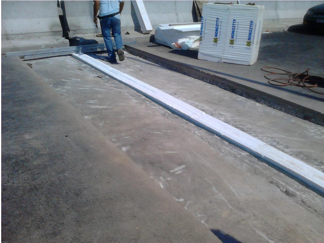
Φωτ. 6.52: Τοποθέτηση αρμών συστολο-διαστολής.
