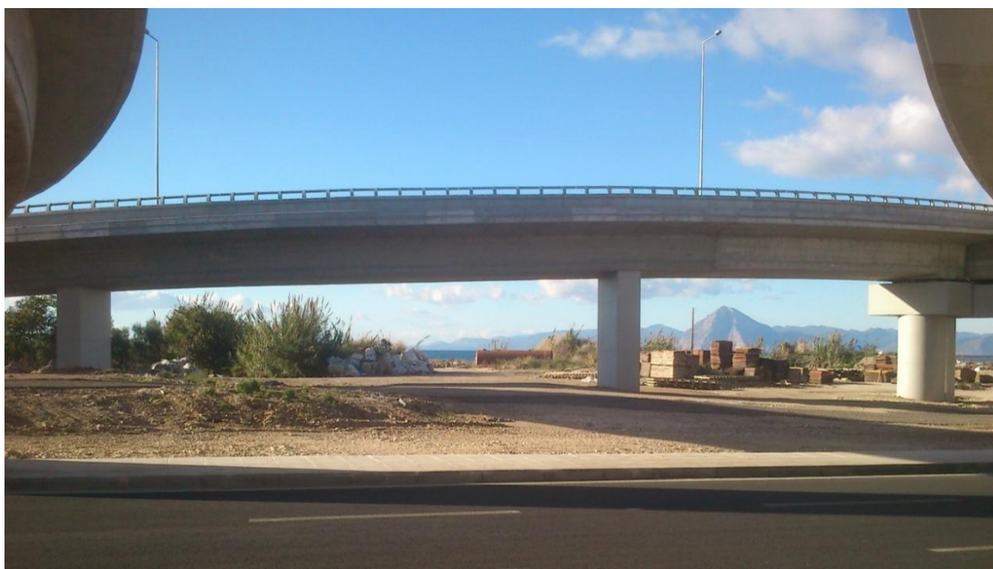
Φωτ. 6.37: Ολοκληρωμένο τμήμα της παρούσας γέφυρας T17, (διακρίνονται από αριστερά τα μεσόβαθρα M3.ΚΛ.Γ, M4.ΚΛ.Γ και M5.ΚΛ.Γ).
