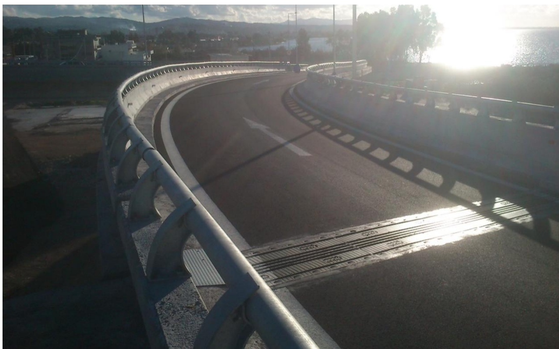
Φωτ. 6.47: Ολοκληρωμένο τμήμα της παρούσας γέφυρας T17.
