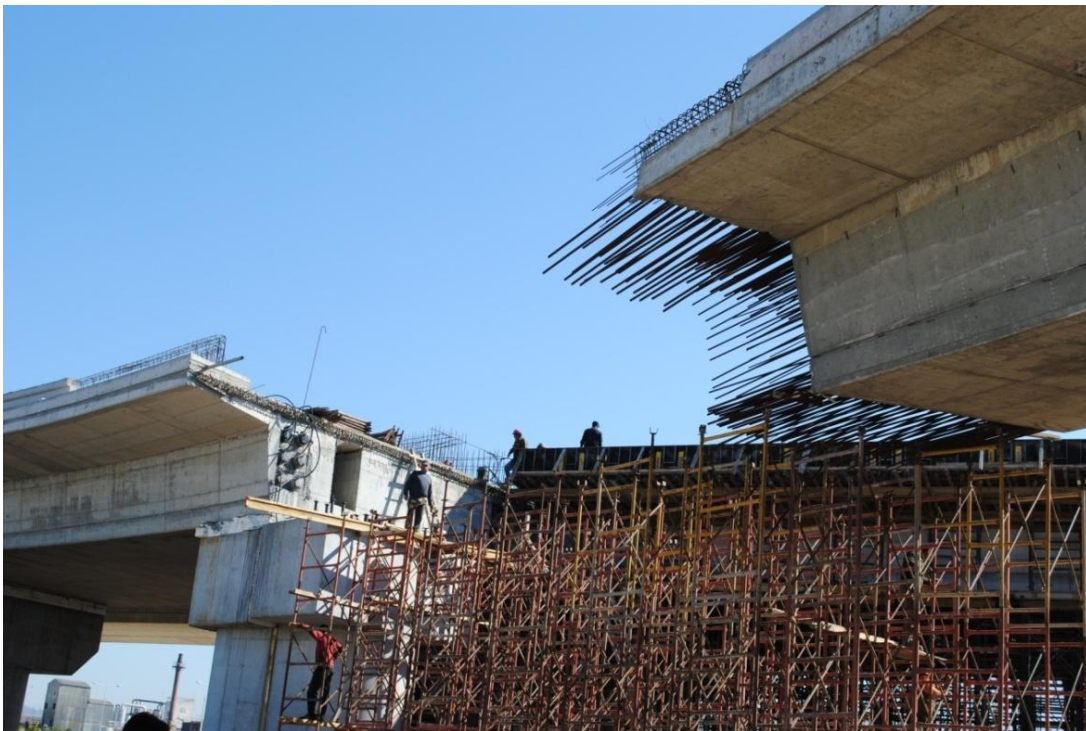
Φωτ. 6.4: Τοποθέτηση ξυλοτύπων ανωδομής μεσόβαθρων Μ4 ΚΛ.Γ- Μ5 ΚΛ.Γ της παρούσας γέφυρας Τ17.
