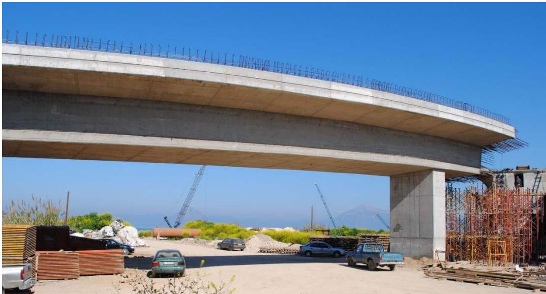
Φωτ. 6.35: Ολοκληρωμένο τμήμα της παρούσας γέφυρας T17(δεξιά), διακρίνεται το μεσόβαθρο M3.ΚΛ.Γ (μονολιθική σύνδεση με την ανωδομή) και αριστερά η γέφυρα T16.
