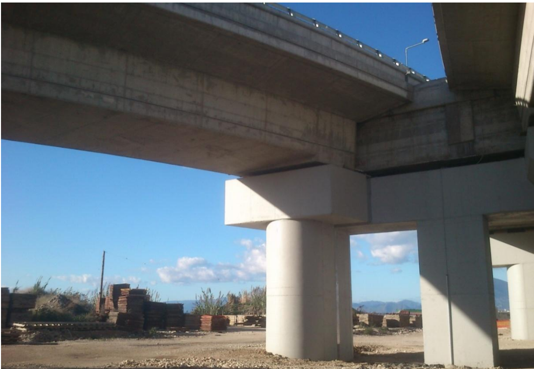
Φωτ. 6.7: Ολοκληρωμένο τμήμα αρμού μεταξύ γέφυρας T2 (αριστερά) και μεσόβαθρου M5 ΚΛ.Γ της παρούσας γέφυρας T17 (δεξιά).
