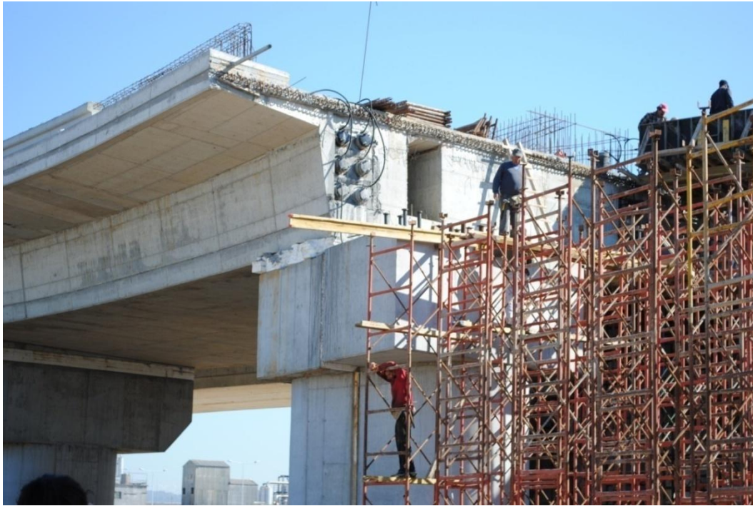
Φωτ. 6.3: ΒΔ όψη μεσόβαθρου Μ5 ΚΛ.Γ της παρούσας γέφυρας Τ17 (σε πρώτο πλάνο – τοποθέτηση ξυλοτύπων ανωδομής μεσόβαθρων Μ4 ΚΛ.Γ- Μ5 ΚΛ.Γ) διακρίνονται τα συρματόσχοινα προέντασης της γέφυρας Τ2.
