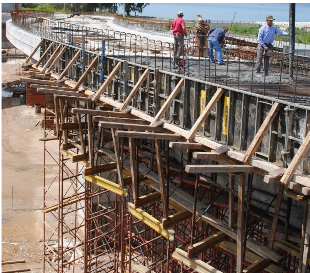
Φωτ. 6.44: Σκυροδέτηση του καταστρώματος της παρούσας γέφυρας T17.
