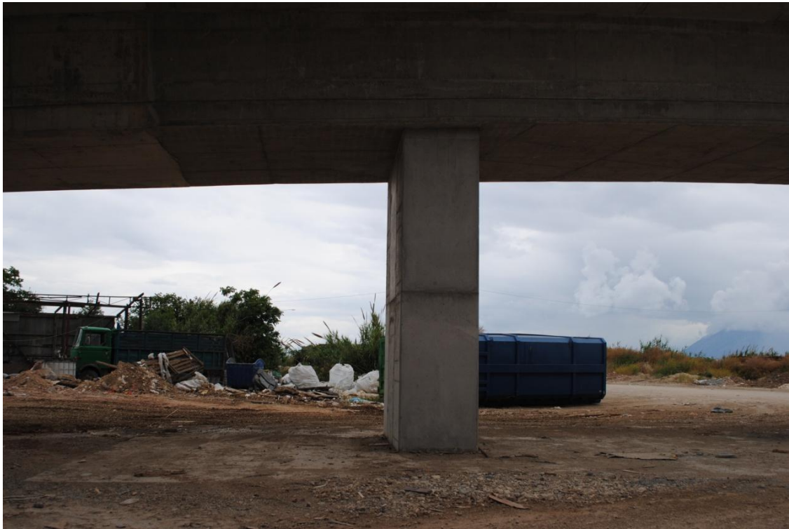
Φωτ. 6.21: Νότια όψη μεσόβαθρου Μ3 ΚΛ.Γ της παρούσας γέφυρας Τ17 (μονολιθική σύνδεση με την ανωδομή).
