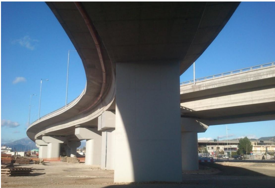
Φωτ. 6.14: Ολοκληρωμένο τμήμα του μεσόβαθρου Μ4 ΚΛ.Γ της παρούσας γέφυρας Τ17, ορθογωνικής διατομής 3,4m x 1,35m (μονολιθική σύνδεση με την ανωδομή).
