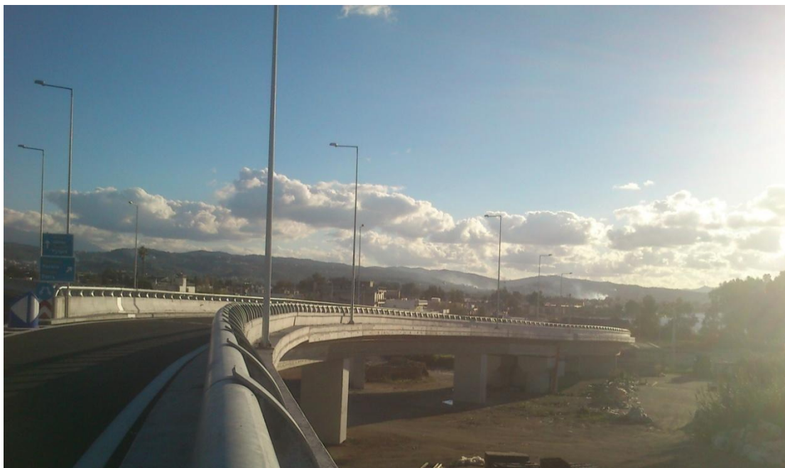
Φωτ. 6.39: ΝΑ όψη της ολοκληρωμένης γέφυρας T17. (Διακρίνονται από αριστερά τμήμα της γέφυρας T2, τα μεσόβαθρα Μ4.ΚΛ.Γ, Μ3.ΚΛ.Γ και Μ2.ΚΛ.Γ της γέφυρας T17, ακολουθεί ο αρμός και μετά η γέφυρα T15).
