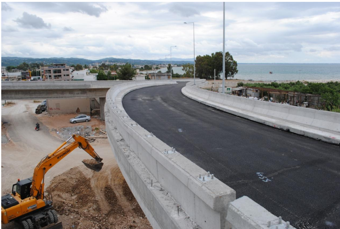
Φωτ. 6.46: Ασφαλτοστρωμένο τμήμα της παρούσας γέφυρας T17 (εν αναμονή αντιολισθηρής ασφαλτικής στρώσης).
