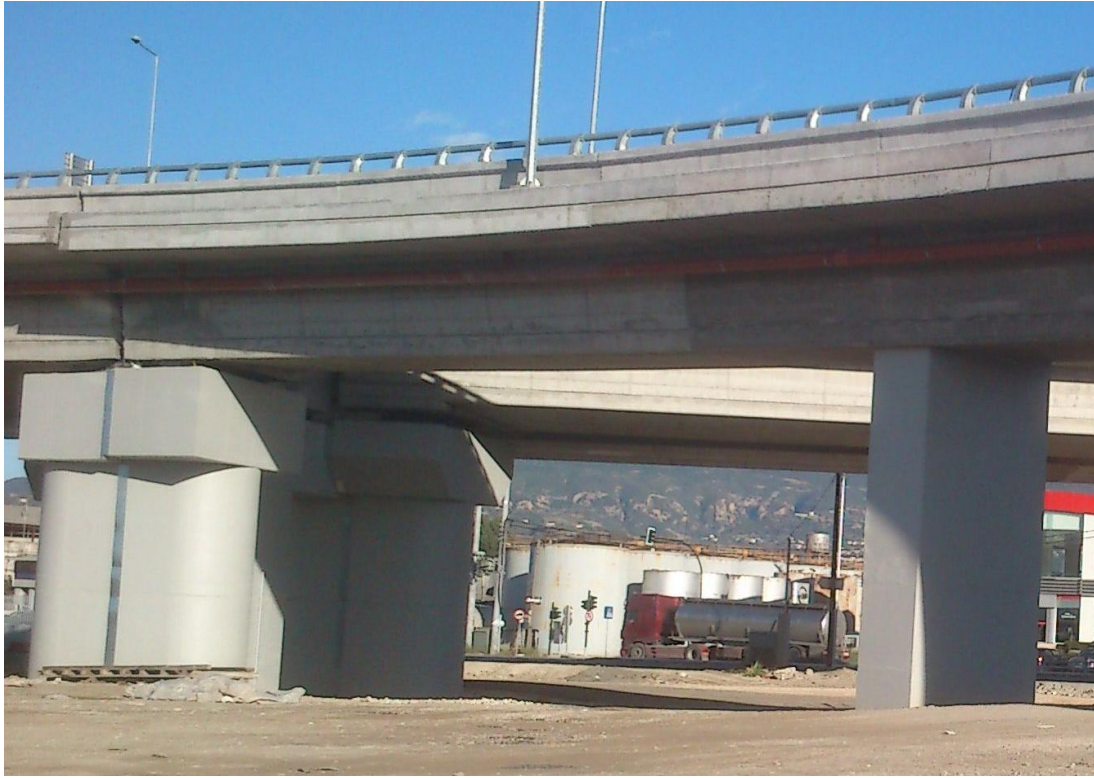
Φωτ. 6.5: Ολοκληρωμένο τμήμα ανωδομής μεσόβαθρων M4 ΚΛ.Γ- M5 ΚΛ.Γ της παρούσας γέφυρας T17.
