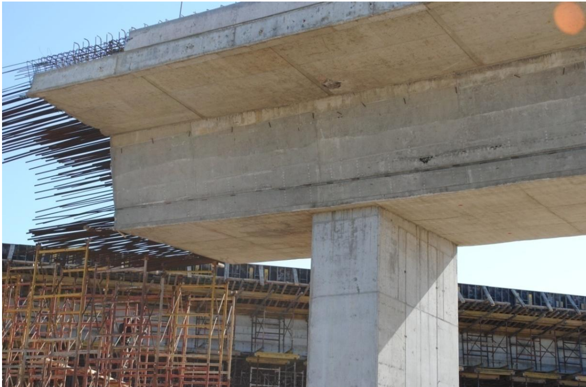
Φωτ. 6.12: Όψη μεσόβαθρου M4 ΚΛ.Γ της παρούσας γέφυρας T17. (Σε δεύτερο πλάνο η ανωδομή της γέφυρας T3).
