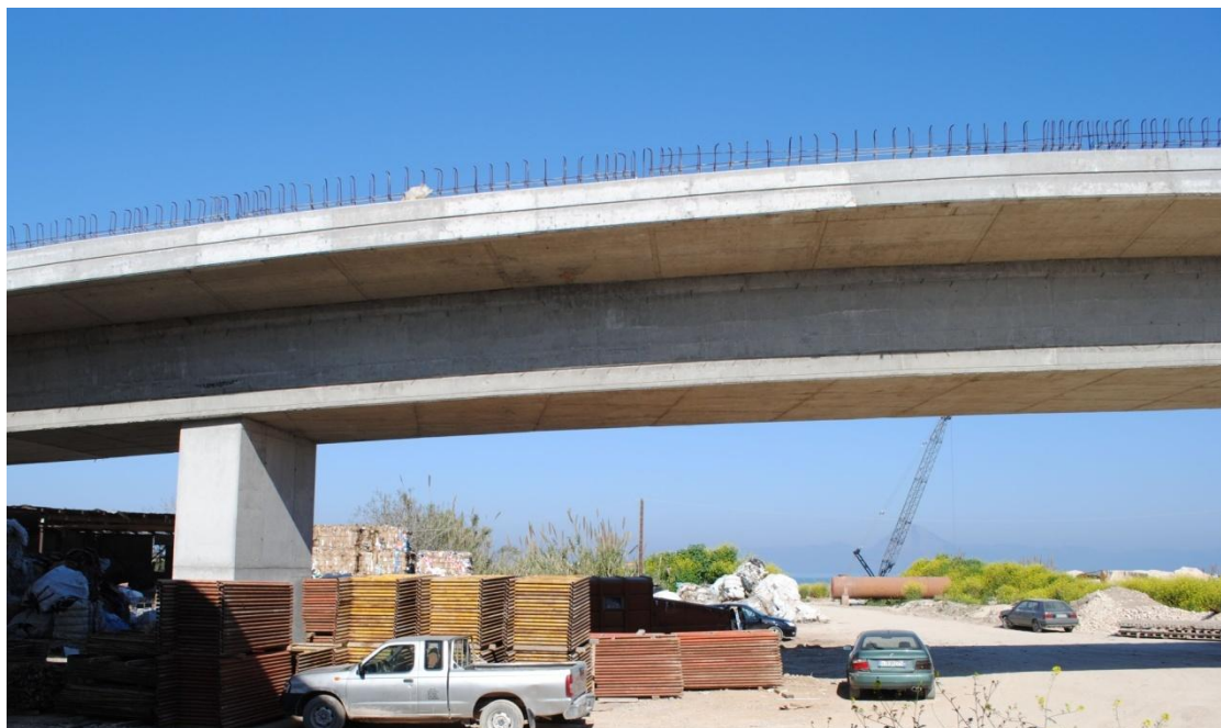
Φωτ. 6.34: Σκυροδετημένο τμήμα της παρούσας γέφυρας T17, διακρίνεται το μεσόβαθρο M3.ΚΛ.Γ (μονολιθική σύνδεση με την ανωδομή).
