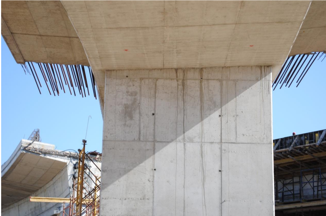
Φωτ. 6.11: Μεσόβαθρο M4 ΚΛ.Γ ορθογωνικής διατομής 3,4m x 1,35m (μονολιθική σύνδεση με την ανωδομή).
