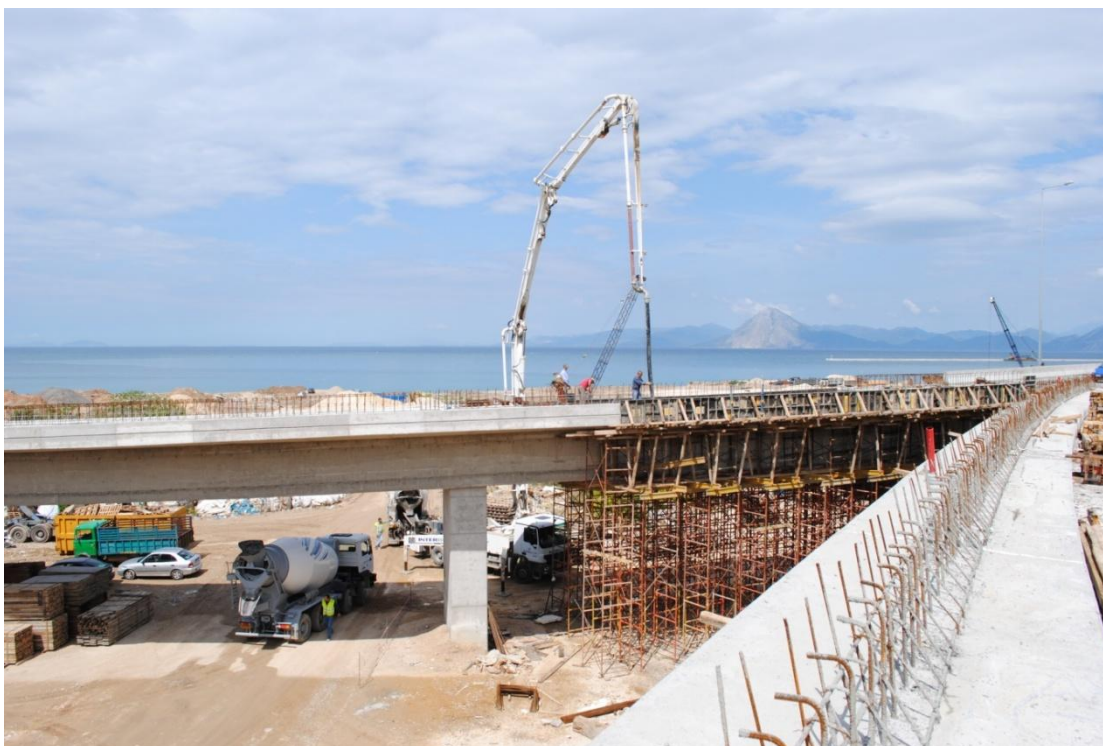
Φωτ. 6.40: ΒΔ όψη της γέφυρας T17. (Σε φάση κατασκευής το τμήμα άνωθεν μεταξύ των μεσόβαθρων Μ4.ΚΛ.Γ [αριστερά] και Μ5.ΚΛ.Γ [δεξιά]).
