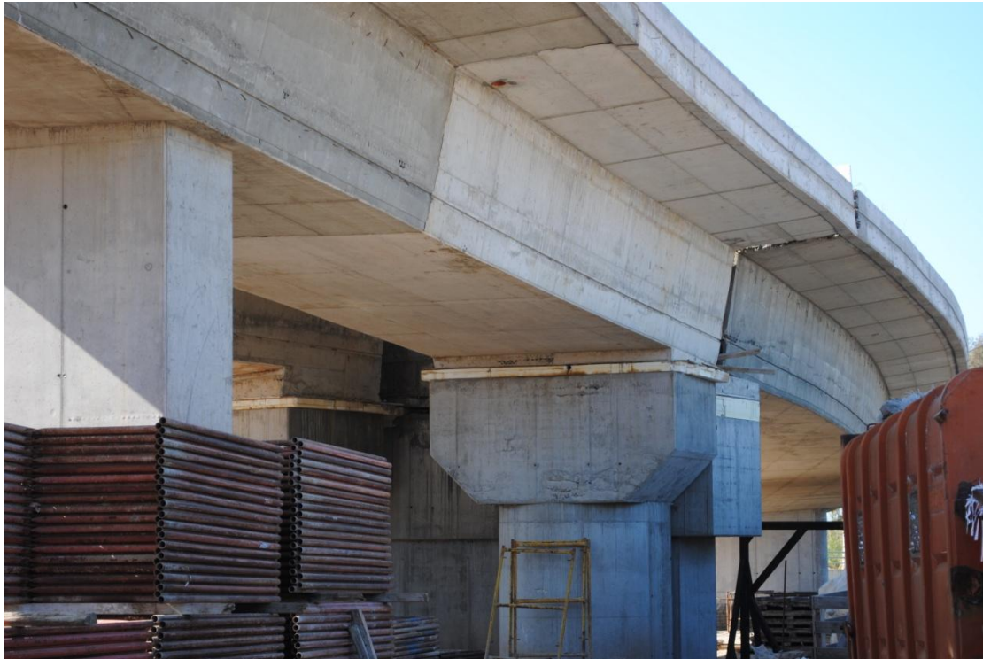
Φωτ. 6.25: ΝΑ όψη μεσόβαθρου Μ2.ΚΛ.Γ της παρούσας γέφυρας Τ17, (διακρίνεται από αριστερά και το μεσόβαθρο Μ3.ΚΛ.Γ).
