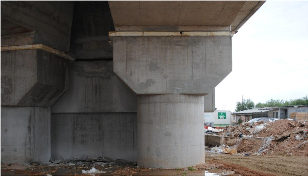
Φωτ. 6.23: Κεφαλοδοκός του μεσόβαθρου Μ2.ΚΛ.Γ της παρούσας γέφυρας Τ17(δεξιά) και αριστερά το αντίστοιχο μεσόβαθρο της γέφυρας Τ16.
