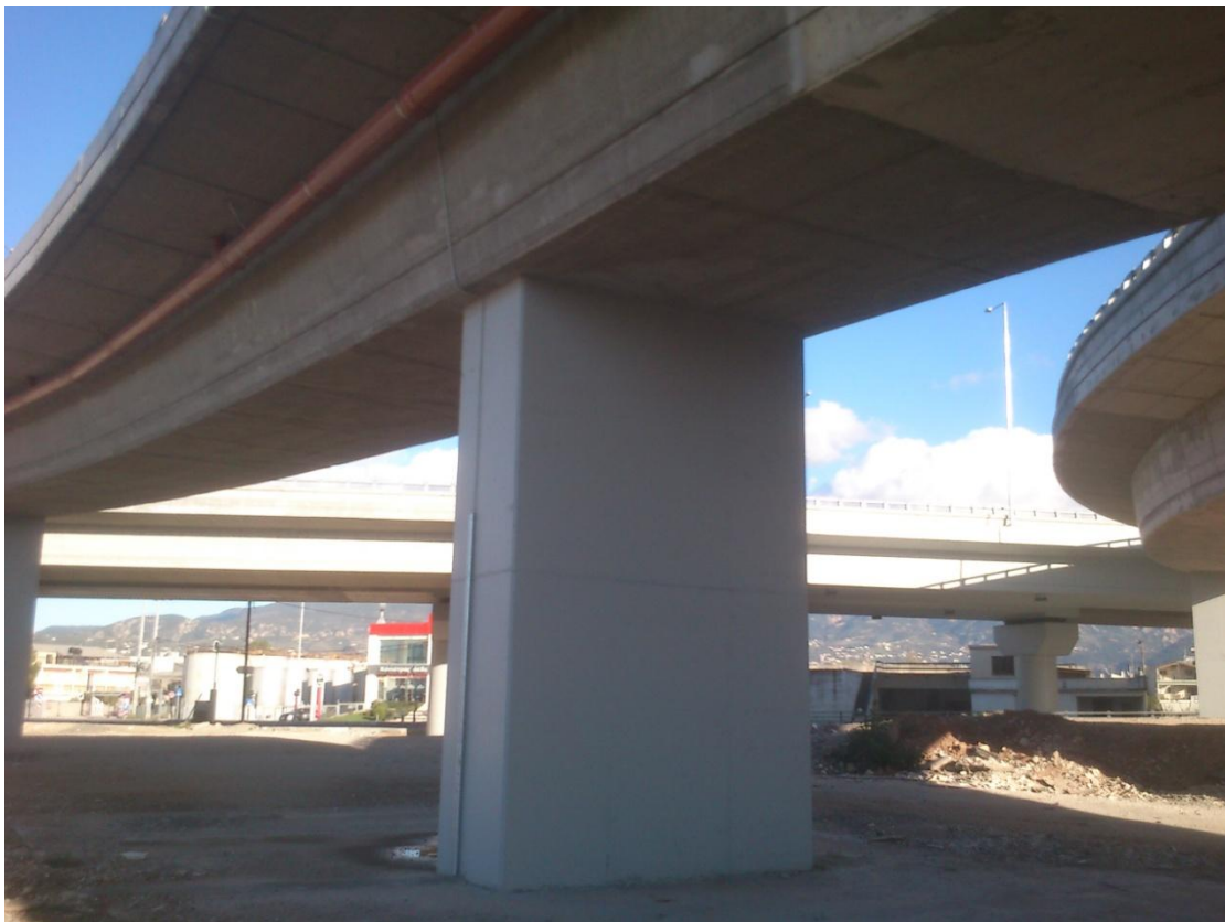
Φωτ. 6.18: Όψη του ολοκληρωμένου μεσόβαθρου Μ3.ΚΛ.Γ της παρούσας γέφυρας Τ17. (Σε δεύτερο πλάνο η γέφυρα Τ3).
