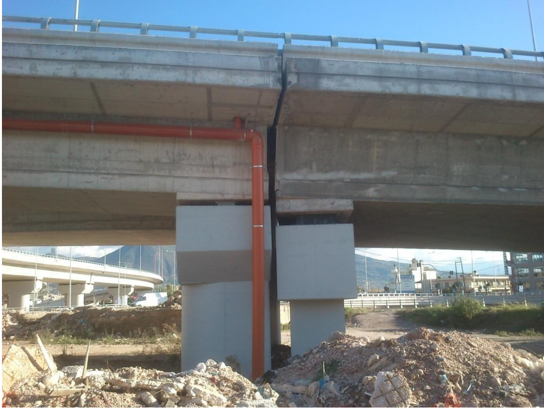
Φωτ. 6.27: Ολοκληρωμένο τμήμα του αρμού μεταξύ της γέφυρας T17 (αριστερά) και T15 (δεξιά). Διακρίνεται ο σωλήνας αποχέτευσης των όμβριων υδάτων.
