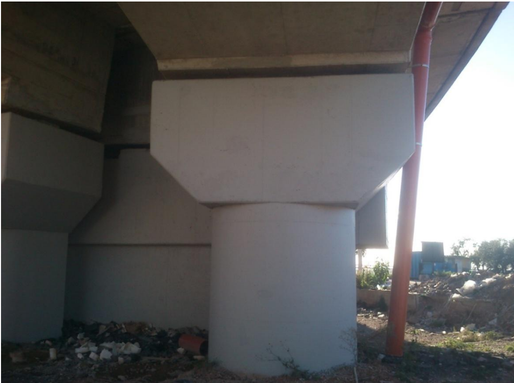
Φωτ. 6.24: Ολοκληρωμένο τμήμα της κεφαλοδοκού του μεσόβαθρου Μ2.ΚΛ.Γ της παρούσας γέφυρας Τ17.
