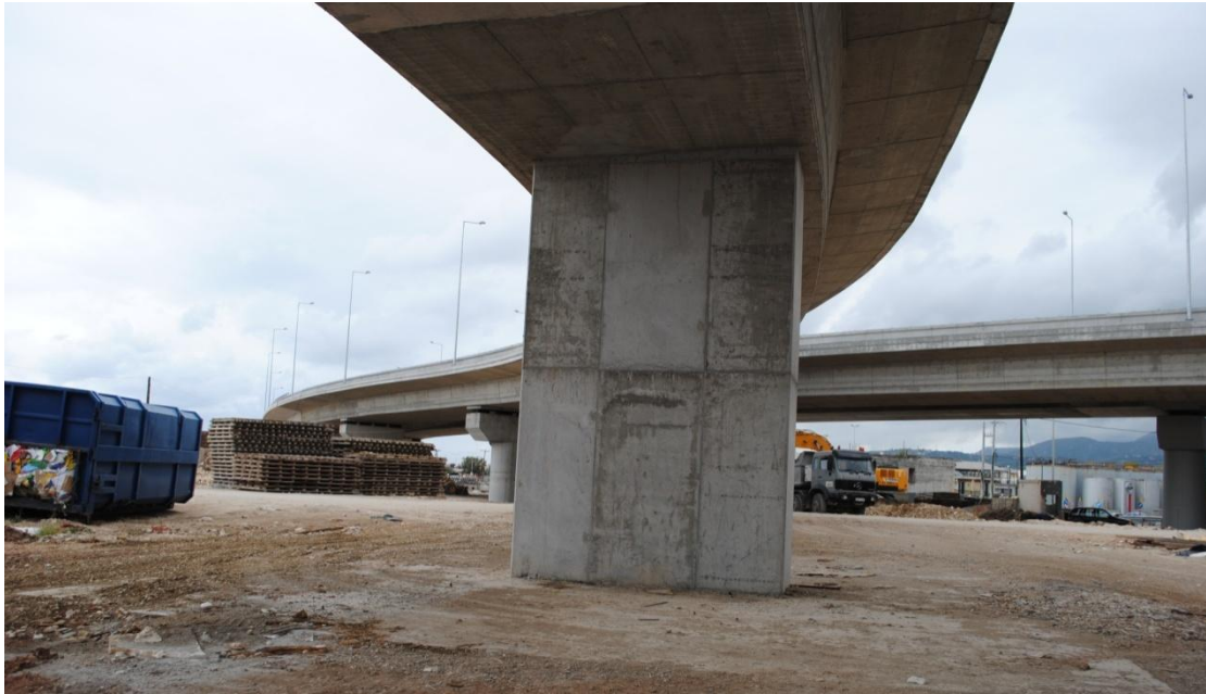
Φωτ. 6.17: ΝΔ όψη μεσόβαθρου Μ3.ΚΛ.Γ της παρούσας γέφυρας Τ17. (Σε δεύτερο πλάνο η γέφυρα Τ2 [αριστερά] και η γέφυρα Τ3 [δεξιά]).
