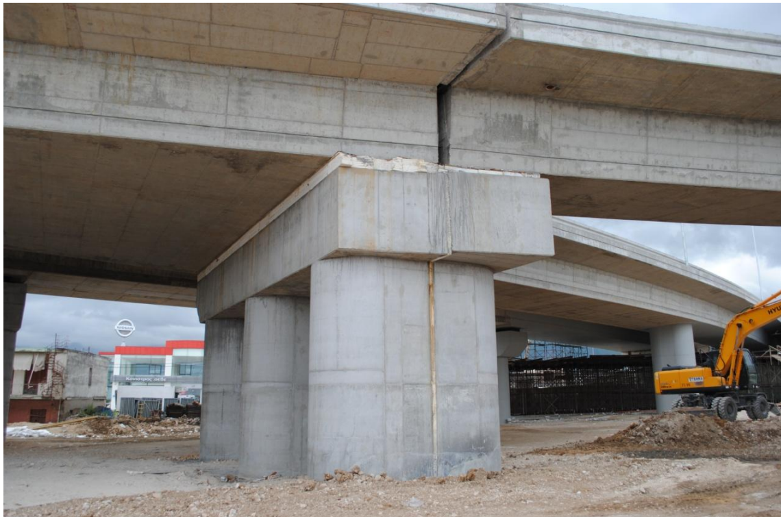
Φωτ. 6.6: Αρμός μεταξύ γέφυρας T2 (αριστερά) και μεσόβαθρου M5 ΚΛ.Γ της παρούσας γέφυρας T17 (δεξιά).
