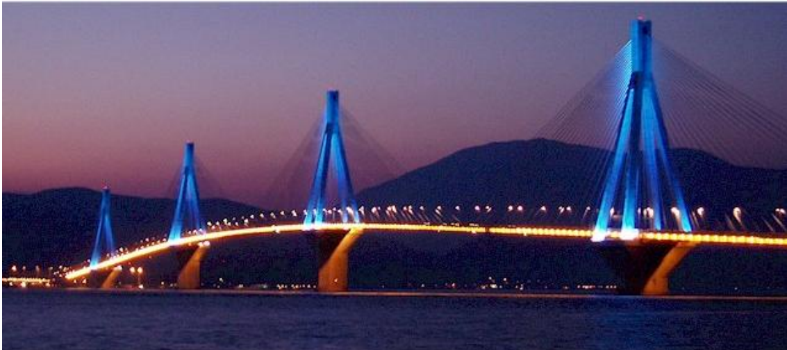
Σχήμα 1.1 – Γέφυρα Ρίου – Αντιρρίου.
