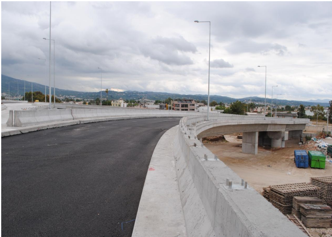
Φωτ. 6.45: ΝΑ όψη της παρούσας γέφυρας – ασφαλτοστρωμένο τμήμα της. (Εν αναμονή αντιολισθηρής ασφαλτικής στρώσης).
