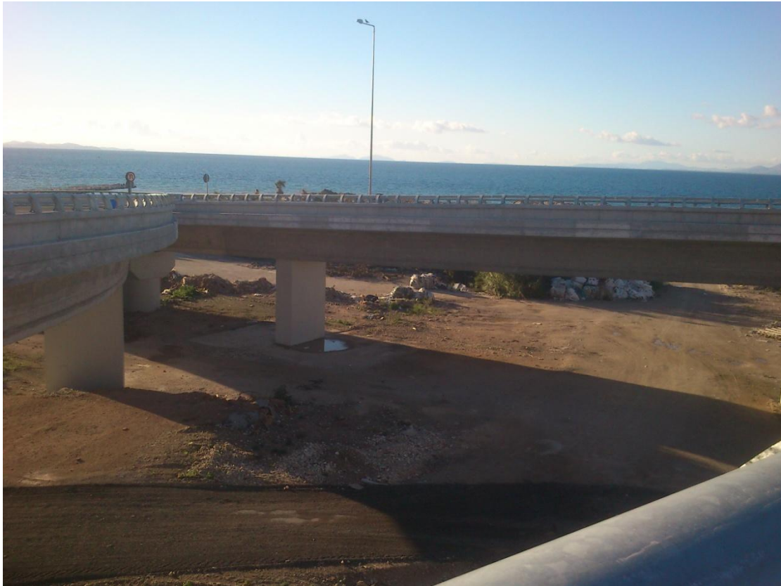
Φωτ. 6.35: Ολοκληρωμένο τμήμα της παρούσας γέφυρας T17(δεξιά), διακρίνεται το μεσόβαθρο M3.ΚΛ.Γ (μονολιθική σύνδεση με την ανωδομή) και αριστερά η γέφυρα T16.
