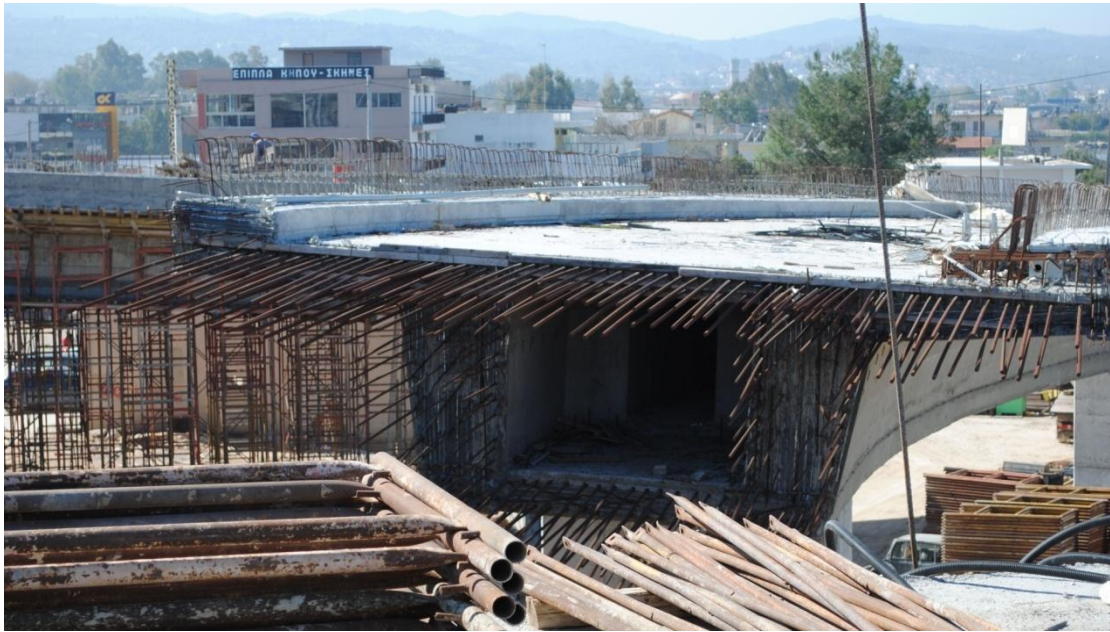
Φωτ. 6.31: Οπλισμός άνωθεν του μεσόβαθρου M4.ΚΛ.Γ της παρούσας γέφυρας T17. (Σε πρώτο πλάνο το μονοκυψελωτό κιβώτιο ύψους 2,5m από σκυρόδεμα C35/45).
