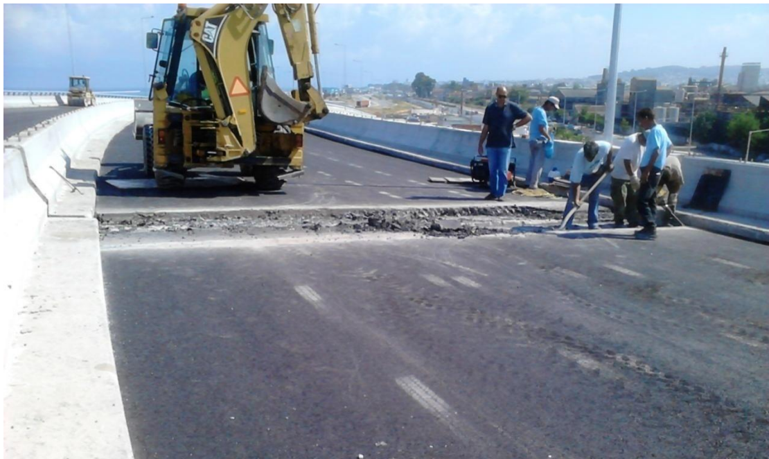
Φωτ. 6.53: Τοποθέτηση αρμών συστολο-διαστολής (αφαίρεση της απαιτούμενης ασφάλτου για την τοποθέτηση του αρμού).
