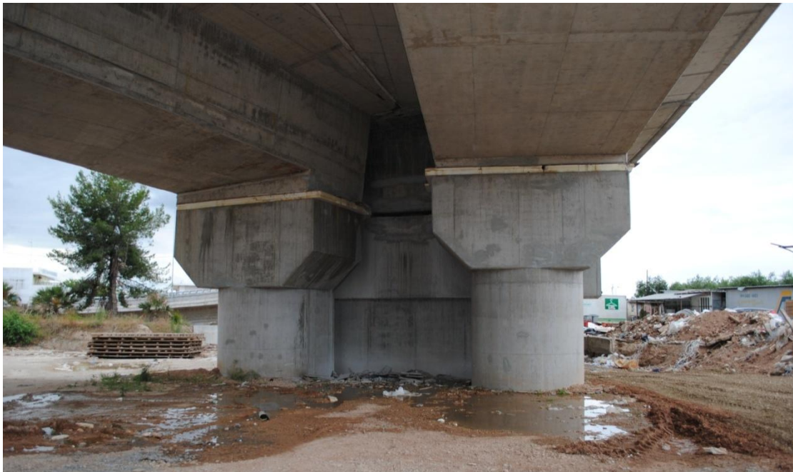
Φωτ. 6.28: Διαχωρισμός κλάδου Γ-Δ καθώς και θέσεις εφεδράνων (δεξιά το μεσόβαθρο M2.ΚΛ.Γ της παρούσας γέφυρας T17 και αριστερά το αντίστοιχο της γέφυρας T16).
