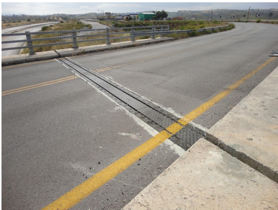
Φωτ. 6.9 Αρμός συστολής-διαστολής ολικού εύρους μετακίνησης 140 mm στο Νοτιοδυτικό άκρο της γέφυρας.
