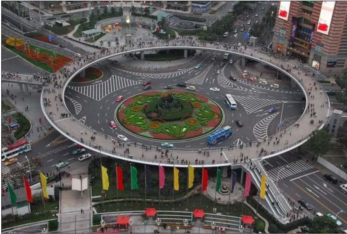
Φωτ. 1.26 Κυκλική Πεζογέφυρα Pundong, Σαγκάη.
