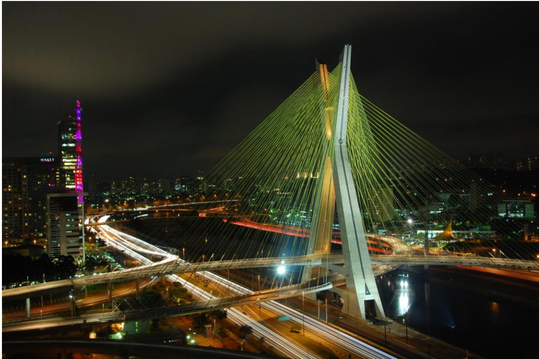
Φωτ. 1.6 Γέφυρα Octavio Frias de Oliveira Σάο Πάολο, Βραζιλία.
