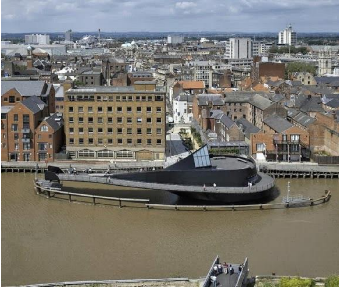
Φωτ. 1.14 River Hull Footbridge, Βρετανία.
