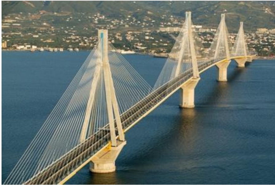
Φωτ. 1.19 Γέφυρα Ρίου-Αντιρρίου.
