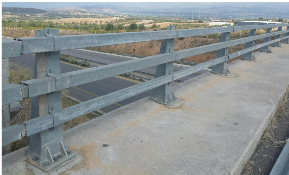
Φωτ. 6.7 Τμήμα του στηθαίου ασφαλείας τύπου ΣΤΕ-1 της γέφυρας.
