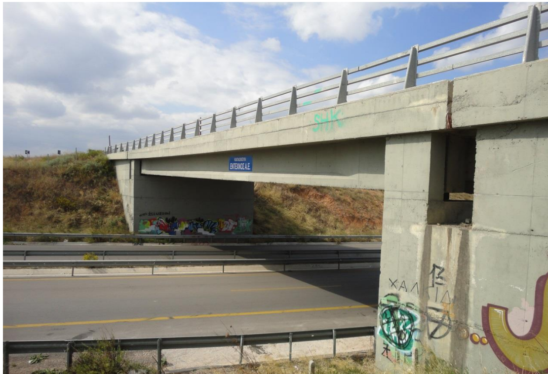
Φωτ. 6.2 Βορειοδυτική όψη της γέφυρας.
