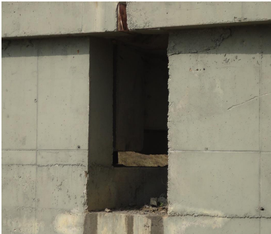
Φωτ. 6.3 Λεπτομέρεια της περιοχής έδρασης του φορέα ανωδομής στο ακρόβαθρο της γέφυρας.
