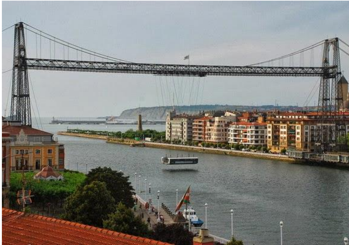
Φωτ. 1.12 Vizcaya Bridge, Ισπανία.
