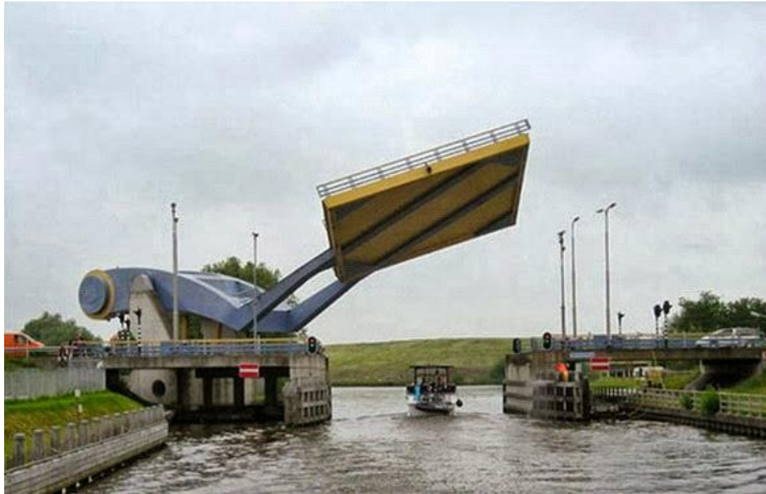
Φωτ. 1.10 Slauerhoffbrug, Ολλανδία.
