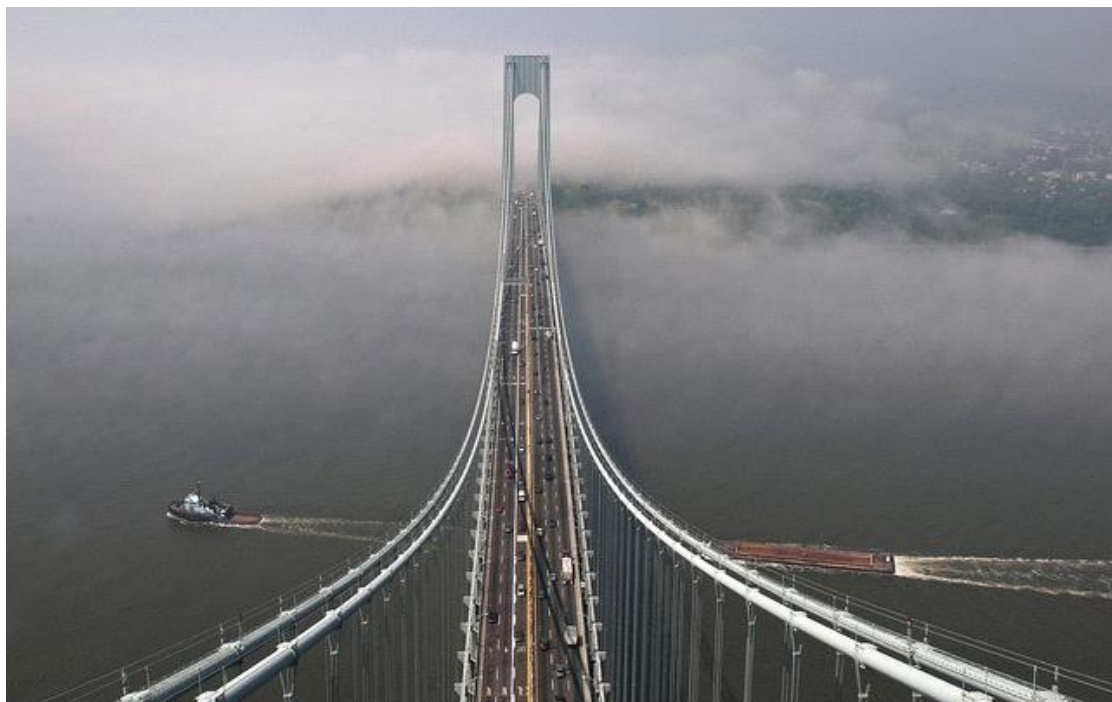
Φωτ. 1.23 Verrazano Narrows Bridge, Νέα Υόρκη.
