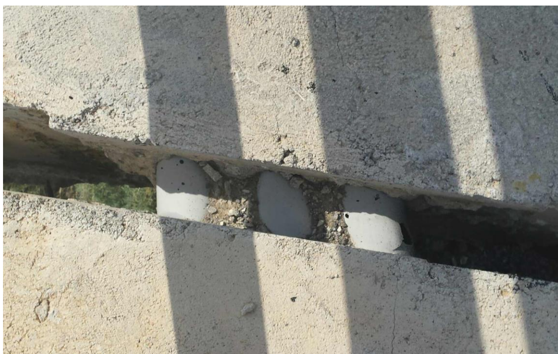
Φωτ. 6.12 Τμήμα των σωληνώσεων του δικτύου υποδομών που έχει αποκαλυφθεί σε περιοχή όπου διακόπτεται η συνέχεια του πεζοδρομίου.
