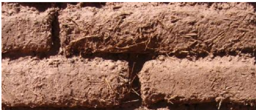
Εικόνα 1: Λεπτομέρεια από κτίσμα. Διακρίνονται τα πλέγματα από το άχυρο μέσα στο τούβλο από πηλό. Φωτογραφία από http://fugahumana.files.wordpress.com/2012/07/mud-and-straw-brick.jpg
