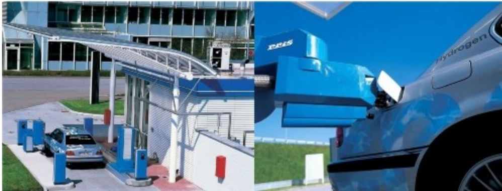
Εικόνα 44: Ο σταθμός ανεφοδιασμού στο αεροδρόμιο του Μονάχου και το ρομποτικό σύστημα τροφοδοσίας.
