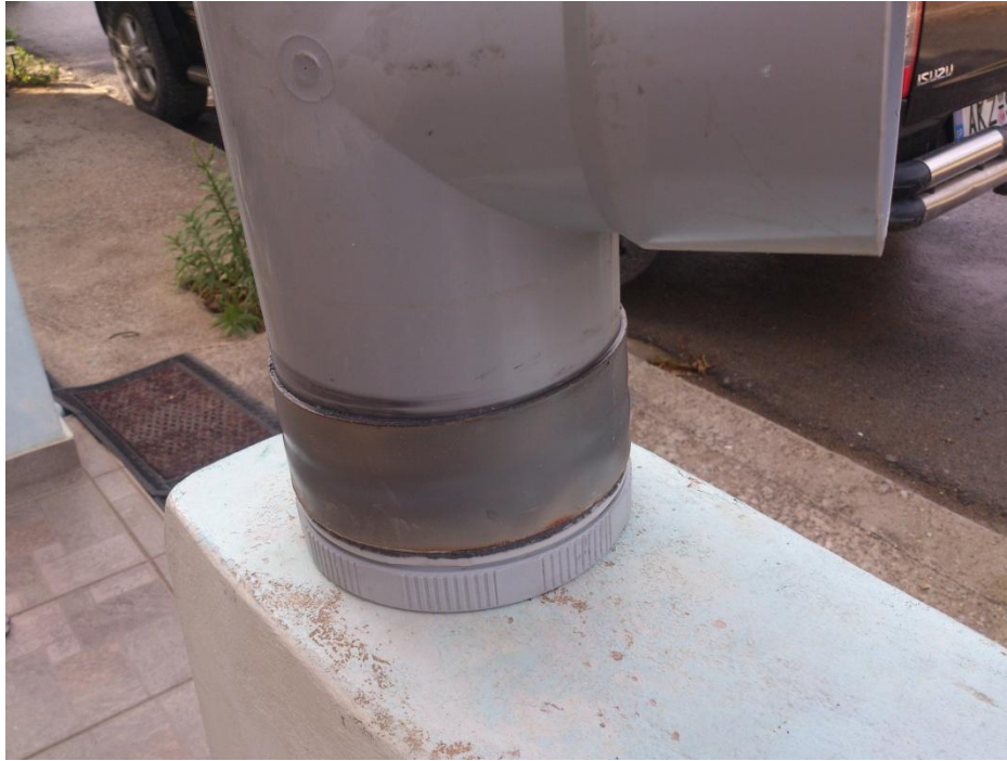
Εικόνα 3.4 Τελική σύνδεση σωληνώσεων, μετά την ολοκλήρωση της κόλλησης.
