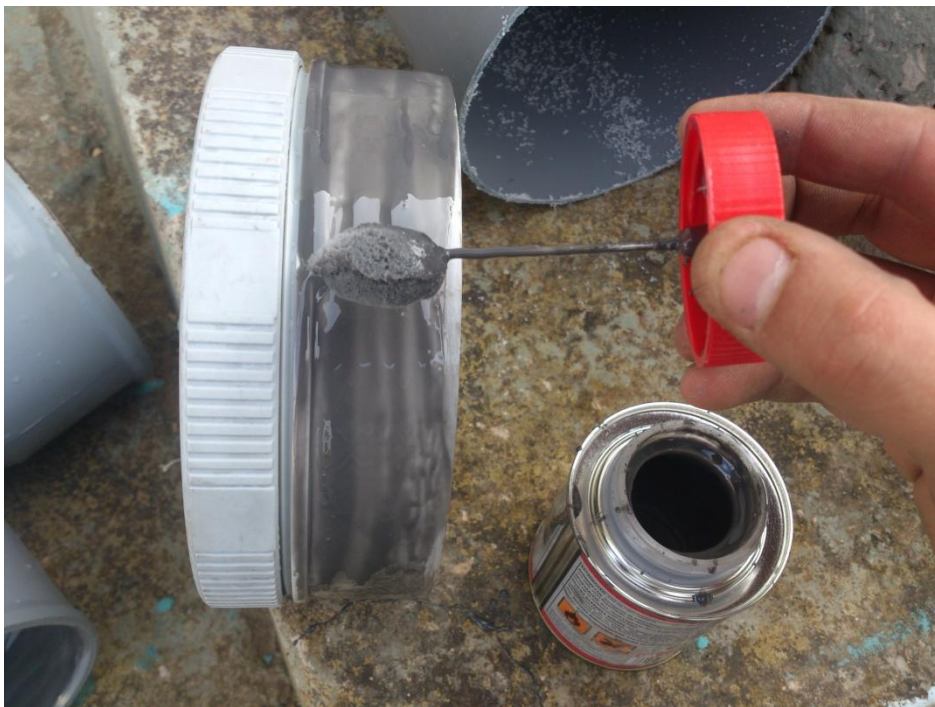
Εικόνα 3.3 Διαδικασία κόλλησης σωληνώσεων.
