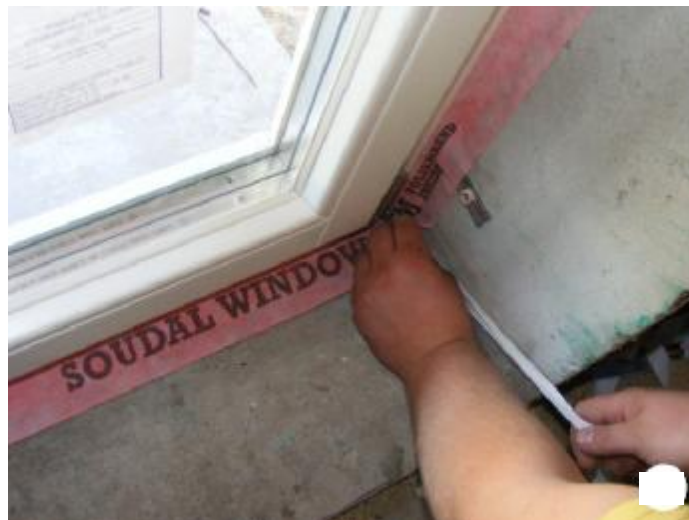
Εικόνα 12: Ταινία στεγανοποίησης μεταξύ κουφώματος και κτιρίου
