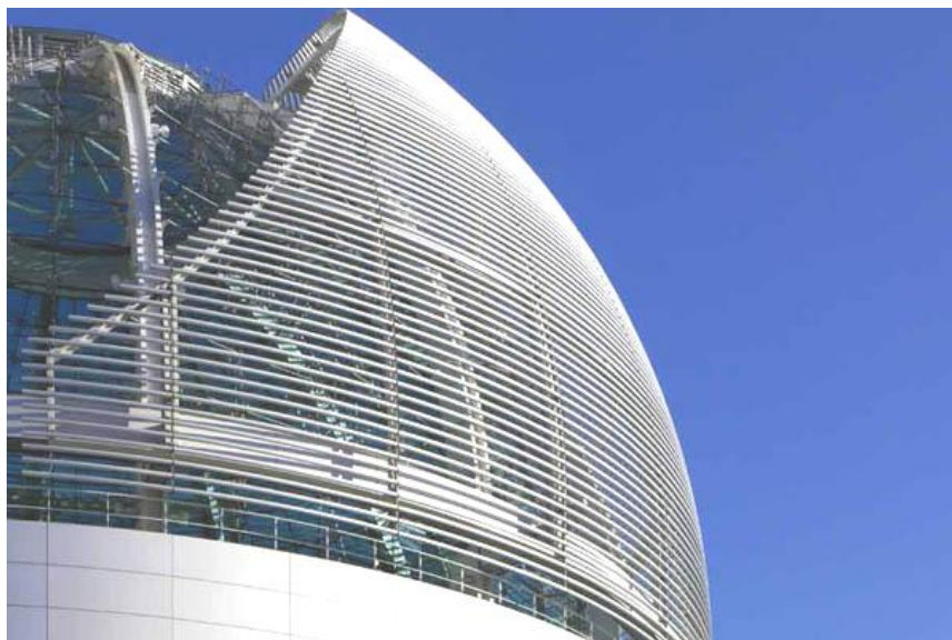
Εικόνα 3: Σταθερό σκίαστρο στο San Jose City Hall
