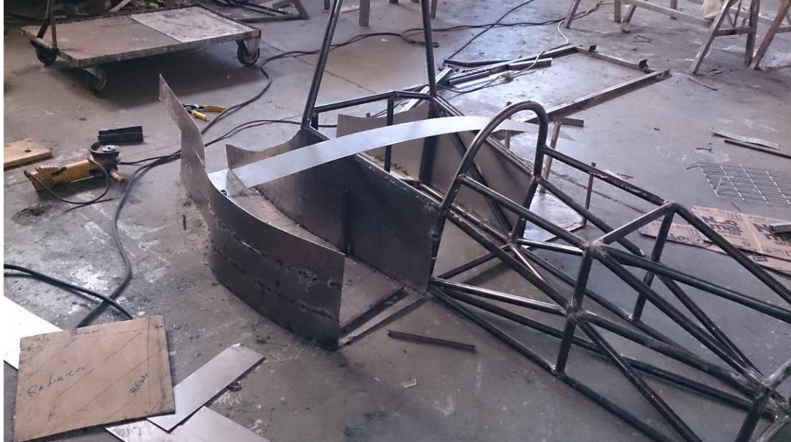
Εικόνα: 8.43 Φωτογραφία κατά την κατασκευή του δεξιού καλουπιού από λαμαρίνα
