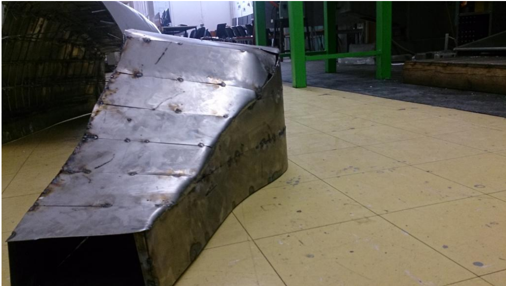
Εικόνα: 8.49 Πίσω όψη καλουπιού από λαμαρίνα αεραγωγού
