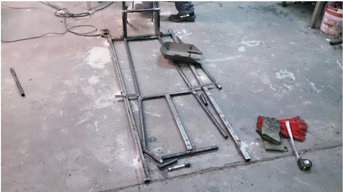
Εικόνα: 8.15 Τυχαία άποψη υποπλαίσιο κατά την διάρκεια κατασκευής του κύριου πλαισίου
