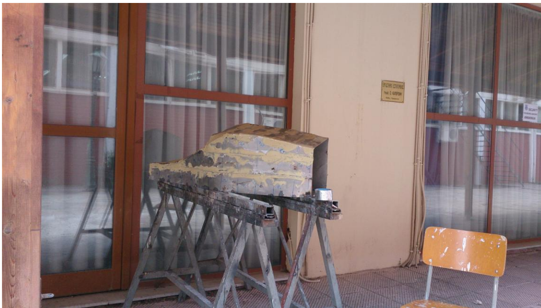
Εικόνα: 8.50 Στοκάρισμα και τρίψιμο καλουπιού αεραγωγού
