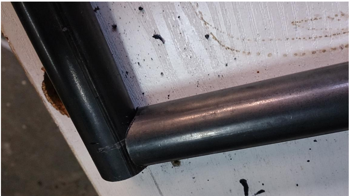
Εικόνα: 8.4 Τυχία εικόνα κατά την διάρκεια ταιριάσματος των σωλήνων
