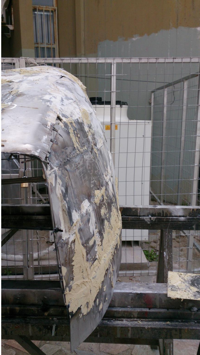
Εικόνα: 8.31 Φωτογραφία κατά την διάρκεια στοκαρίσματος του κύριου καλοπιού
