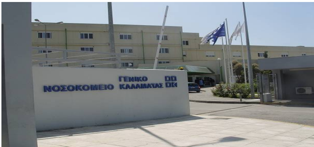
Εικόνα 4. Γενικό Νοσοκομείο Καλαμάτας
