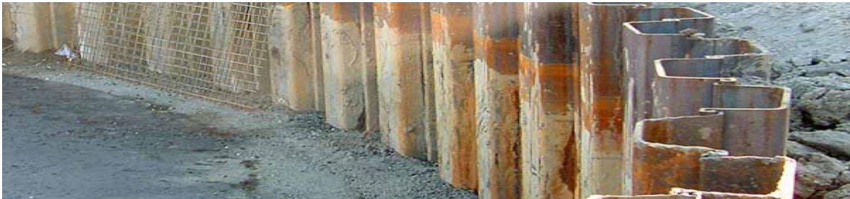
Εικόνα 4: Πασσαλοσανίδες.
