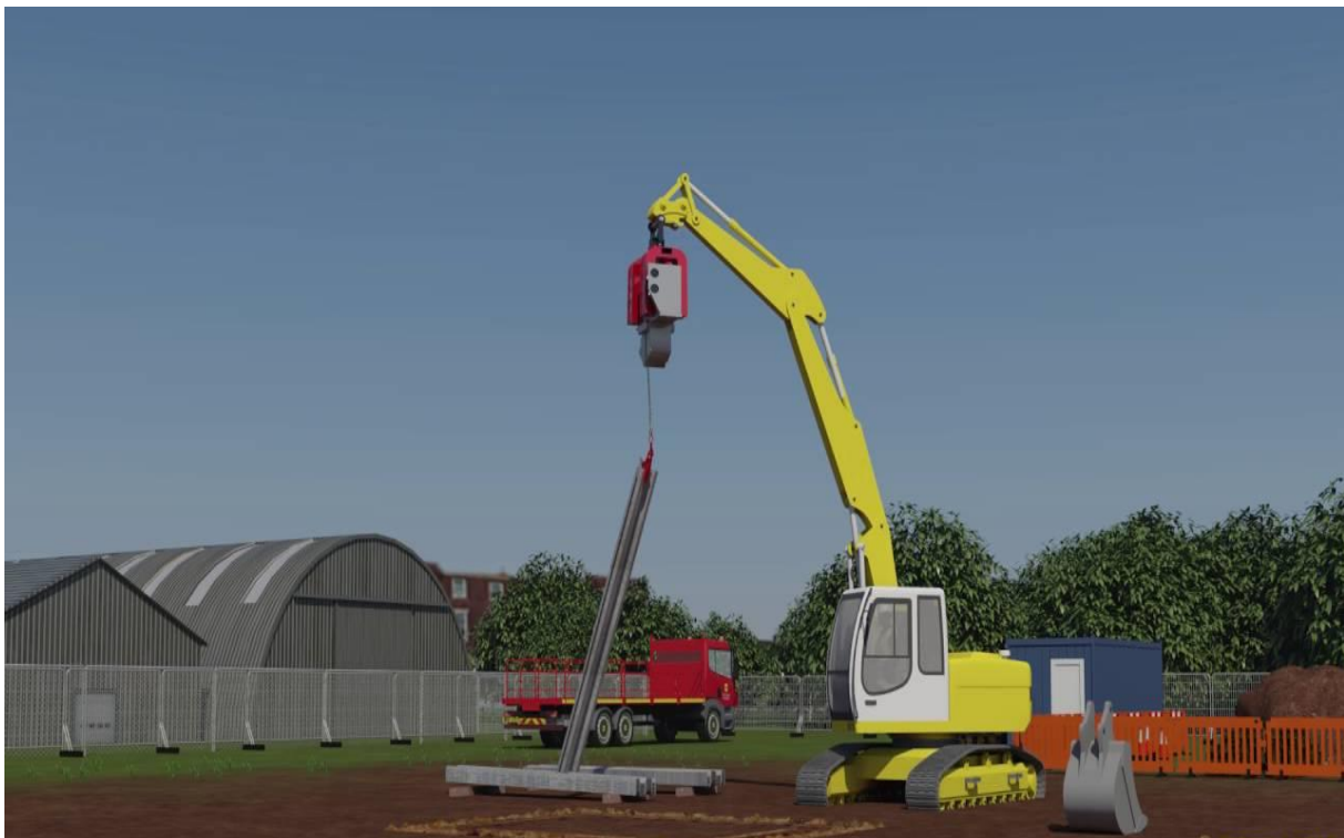
Εικόνα 11: Αφαίρεση πασσαλοσανίδας.
