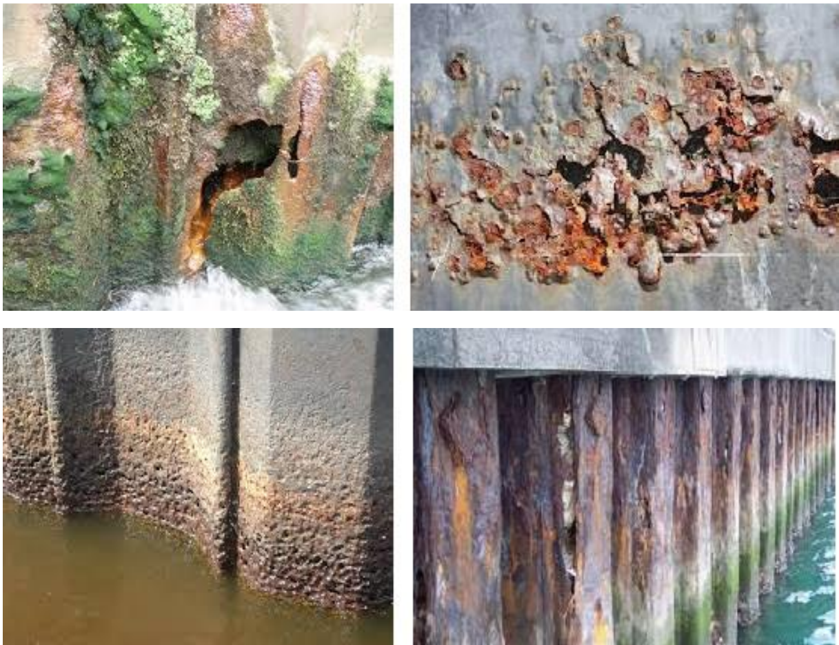
Εικόνα 34: Διάβρωση πασσαλοσανίδας.
