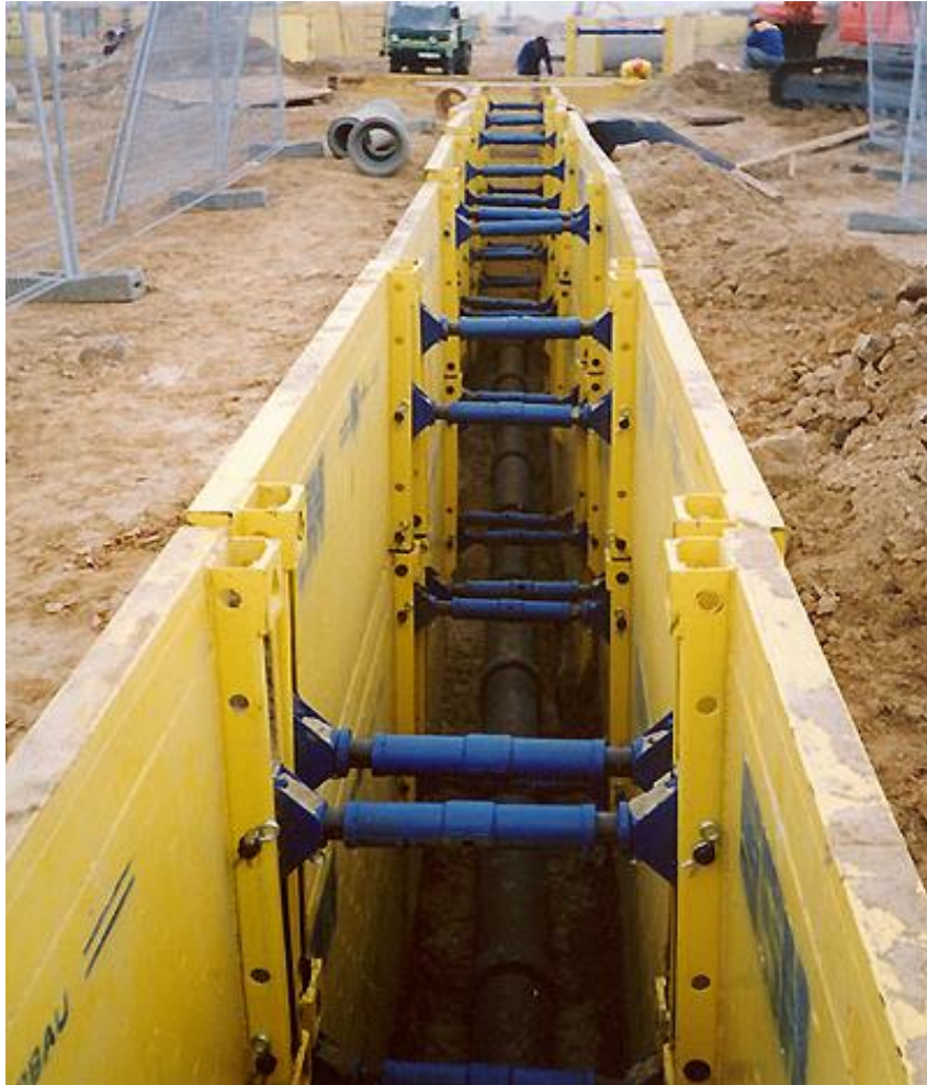
Εικόνα 31: Αντιστήριξη μεταλλικού τοίχου με αντηρίδες.
