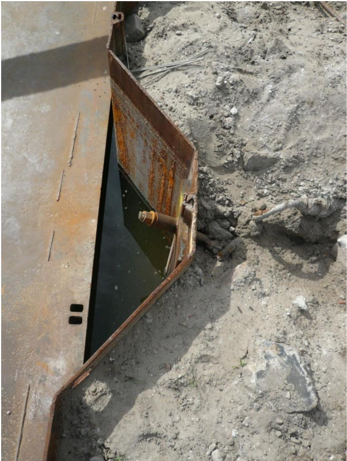
Εικόνα 9: Πασαλοσανίδα τύπου U.
