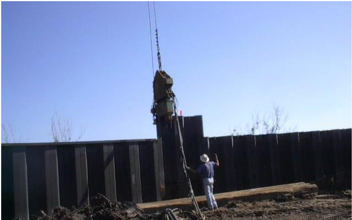
Εικόνα 10: Αφαίρεση πασσαλοσανίδας.
