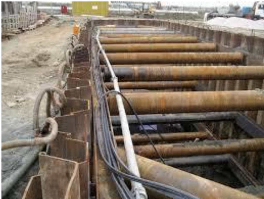
Εικόνα 32: Αντιστήριξη πασσαλοσανίδων με αντηρίδες.
