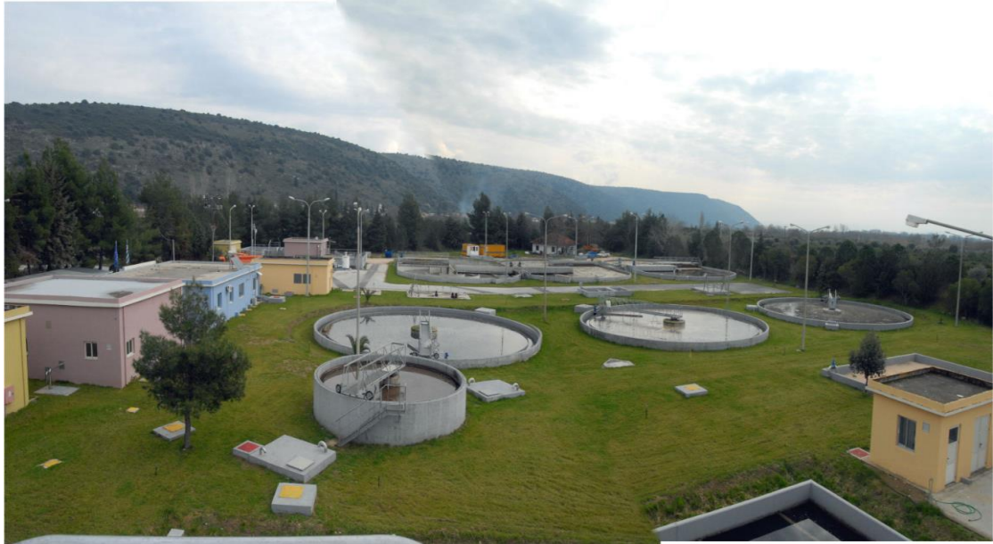
Εικόνα 2. Πανοραμική θέα εγκαταστάσεων.
