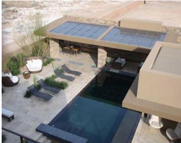
Φωτοβολταϊκά Πάνελ σε επίπεδη στέγη
