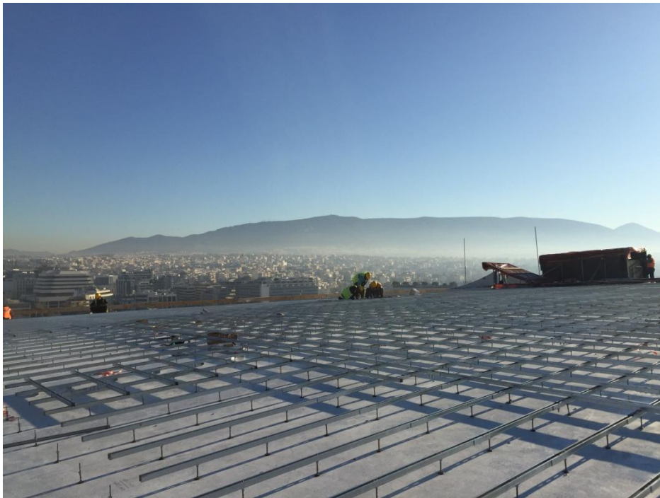
Διαδικασία τοποθέτησης των αξόνων με βάση το πώς έχουν τοποθετηθεί οι ντίζες από τα τοπογραφικά συνεργεία
