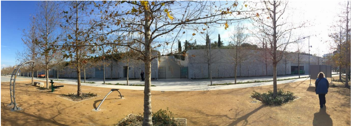
Πανοραμική άποψη του κτιρίου των εργατών και στο δώμα του φαίνεται το φυτεμένο δώμα
