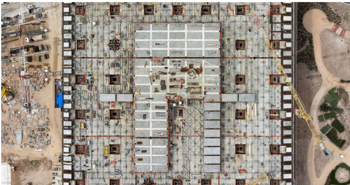
Φάση από την τοποθέτηση της άνω στρώσης από φεροσεμέντ του Στεγάστρου
