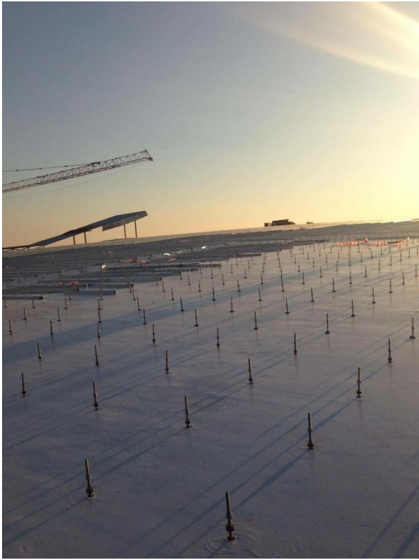
Διαδικασία τοποθέτησης των φωτοβολταϊκών πάνελ
