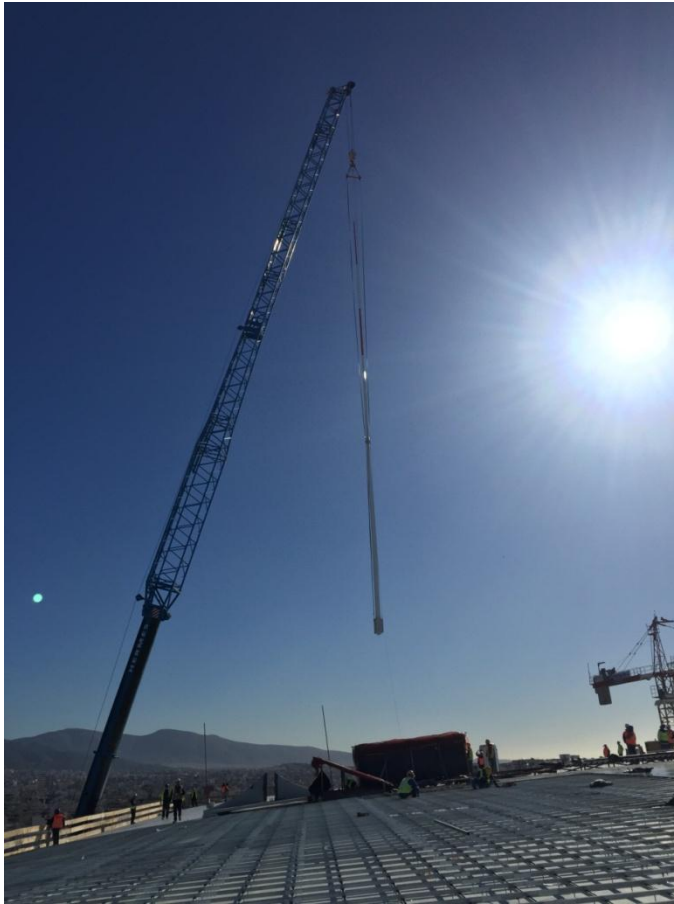
Τοποθέτηση του αλεξικέρανου καθώς και οι διαδικασίες ολοκλήρωσης των βάσεων για την τοποθέτηση των πάνελ σε άξονες X-X και Y-Y
