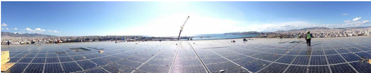
Πανοραμική άποψη των φωτοβολταϊκών πάνελ στο Ενεργειακό Στέγαστρο
