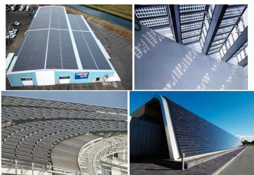
BIPV Πάνελ ενσωματωμένα στο κέλυφος των κτιρίων
