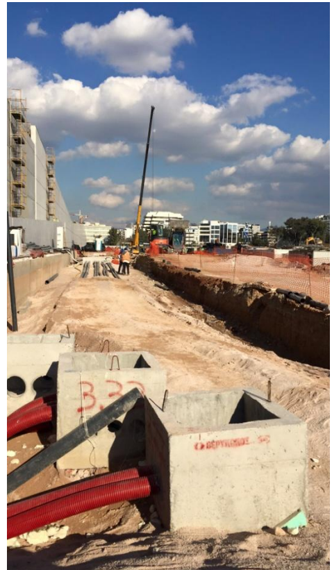
Τοποθέτηση φρεατίων και σωληνώσεων άρδευσης και ύδρευσης
