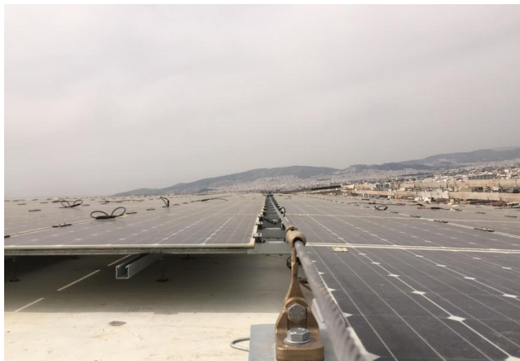
Μεταλλικό συρματόσχοινο που χρησιμοποιείται από τους συντηρητές των Φωτοβολταϊκών
