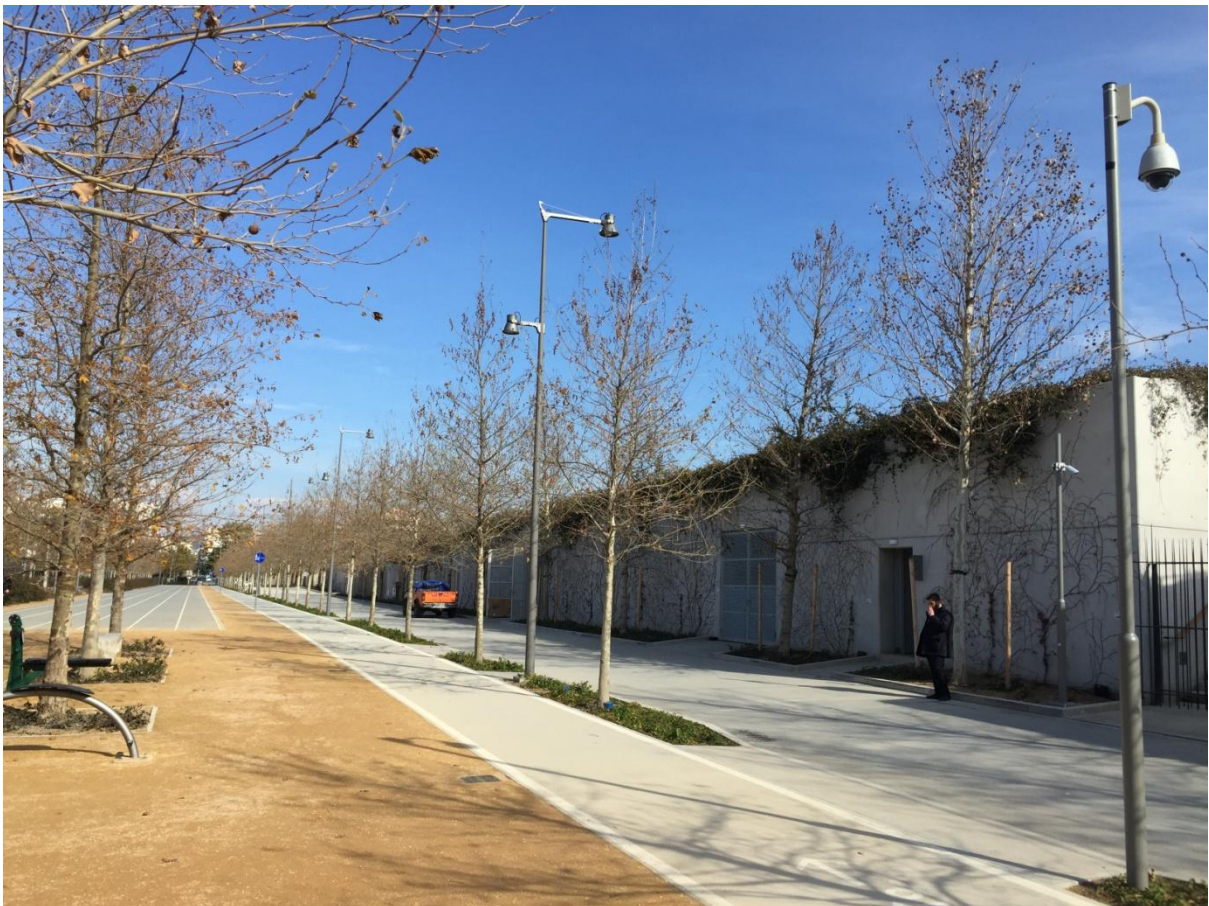
Φωτογραφική απεικόνιση του κτιρίου των εργατών καθώς και το West Pedestrian
