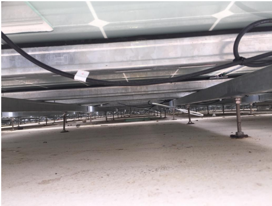
Φωτογραφική απεικόνιση του ενδιάμεσου κενού μεταξύ Πάνελ και ενεργειακού στεγάστρου
