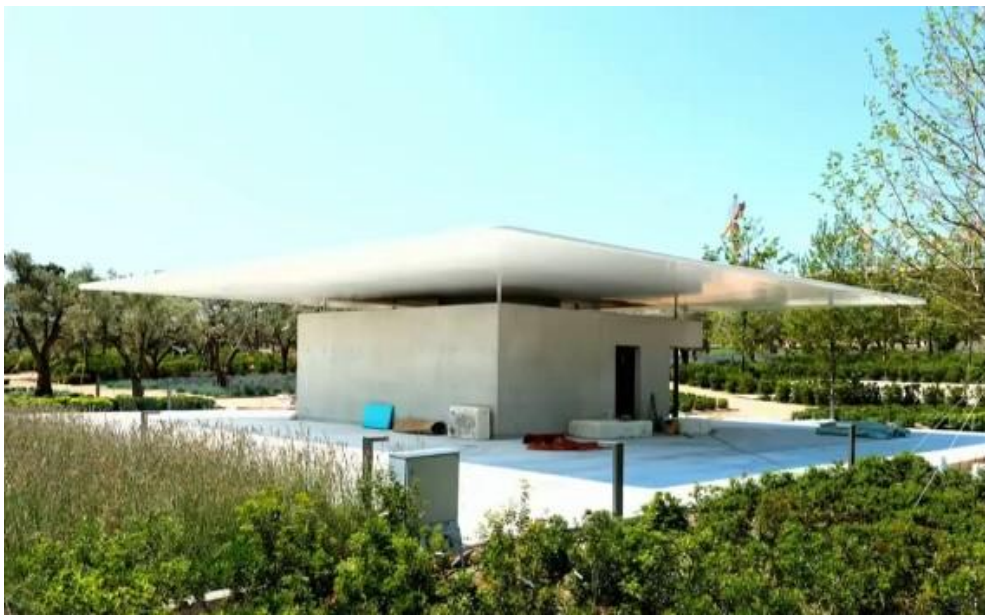
Κτίσμα με σκέπαστρο από φεροτσιμέντο εντός του Πάρκου για να χρησιμοποιηθεί ως χώρος εστίασης
