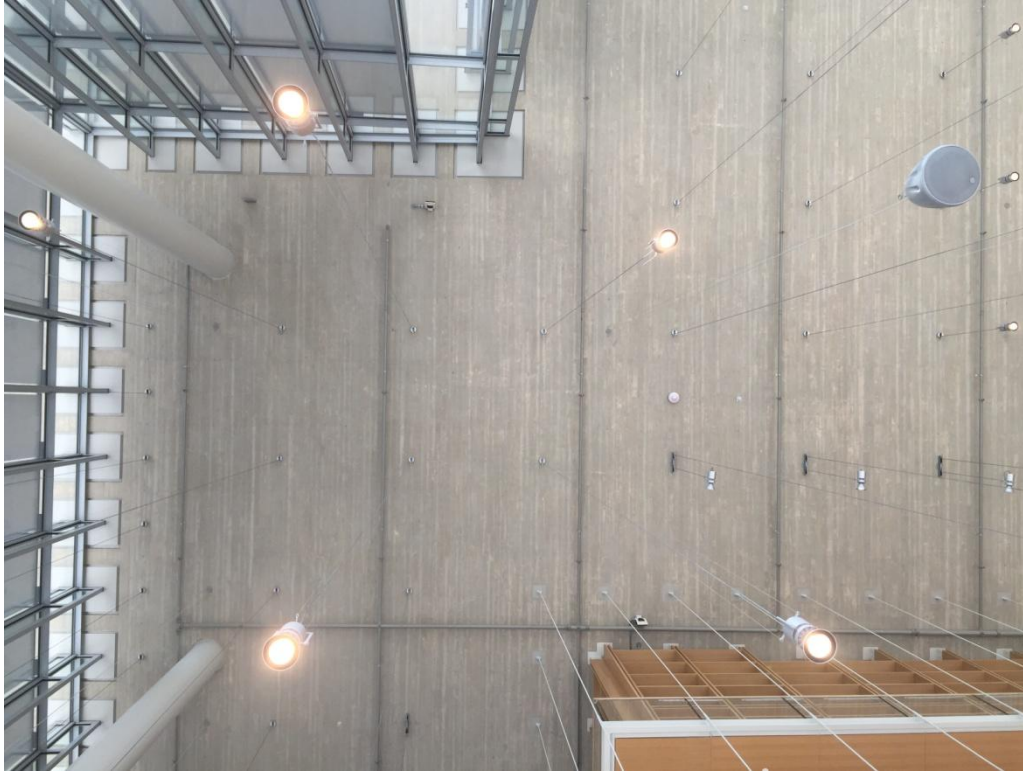
Εσωτερική άποψη της οροφής και των στοιχείων φωτισμού .
