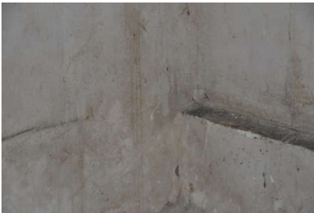
Υπάρχουσα κατάσταση χώρου X2
