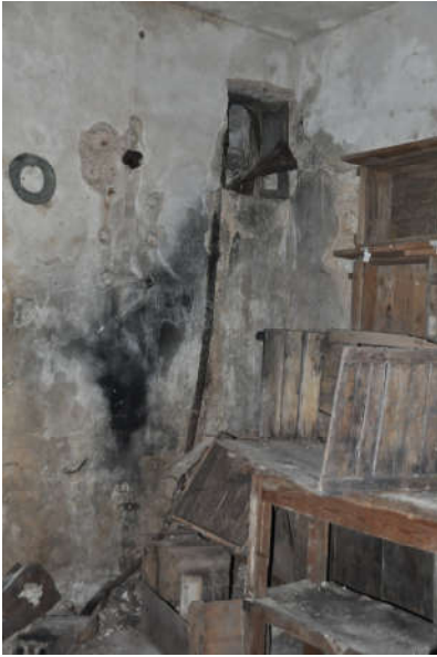
Υπάρχουσα κατάσταση χώρου X2
