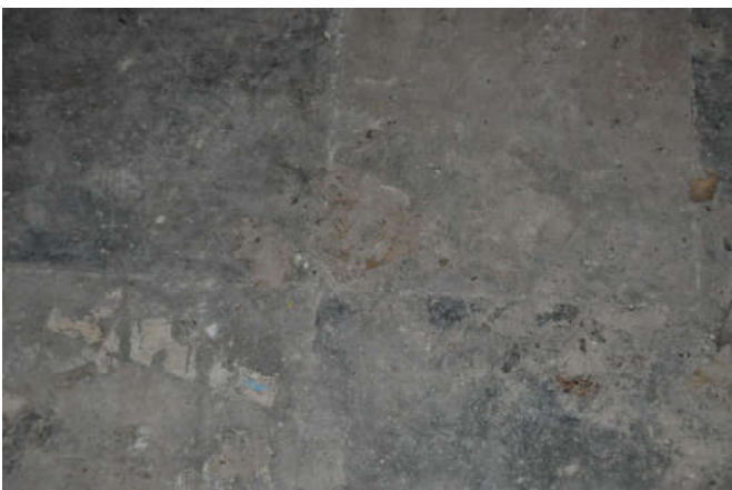
Υπάρχουσα κατάσταση χώρου X2
