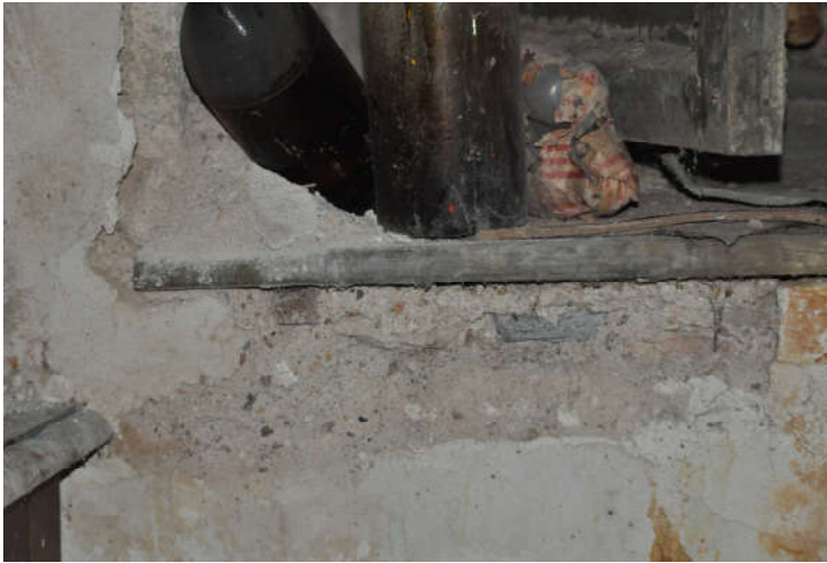
Υπάρχουσα κατάσταση χώρου X2
