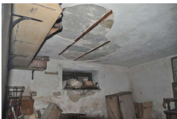
Υπάρχουσα κατάσταση χώρου X1
