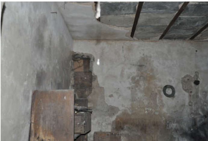
Υπάρχουσα κατάσταση χώρου X2
