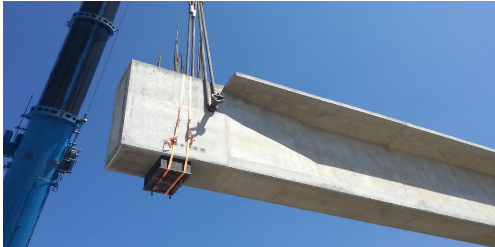
Σχήμα 21 Σεισμική μόνωση σε γέφυρα ποταμού Σκουπέικου
