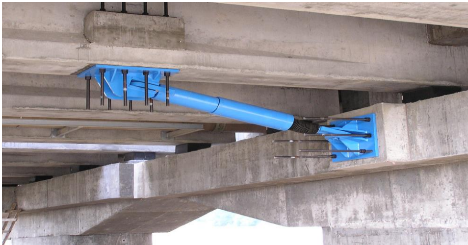
Σχήμα 20 Σεισμική μόνωση σε γέφυρα στο ποταμό Νέστο[15]
